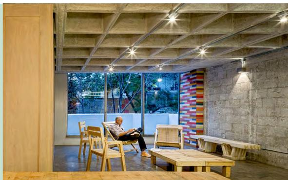
Imagen 133. Sistema de entepiso con losa casetonada. Fotografía: Rafael Gamo.
