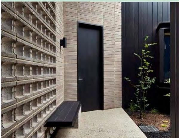
Imagen 134. Ejemplo de muro con blocks de concreto.
