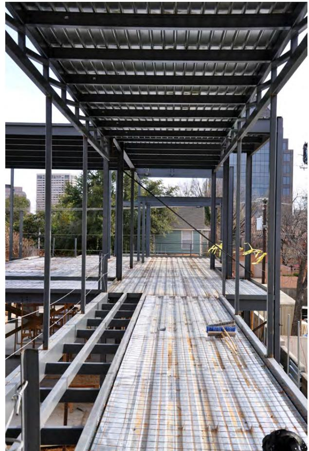
Imagen 140. Ejemplificación de sistema estructural propuesto.
