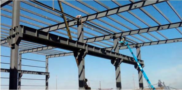
Imagen 86. Sistema estructural con marcos de acero.
