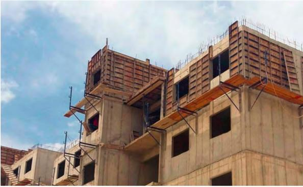
Imagen 136. Estructura monolítica de concreto armado.
