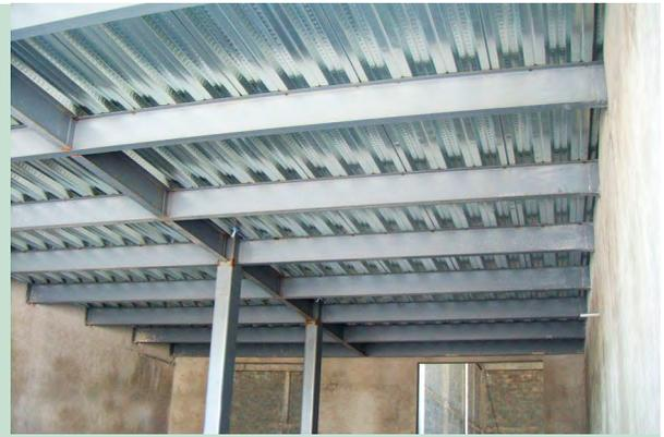
Imagen 127. Sistema de entrepiso con lámina metálica losacero.
