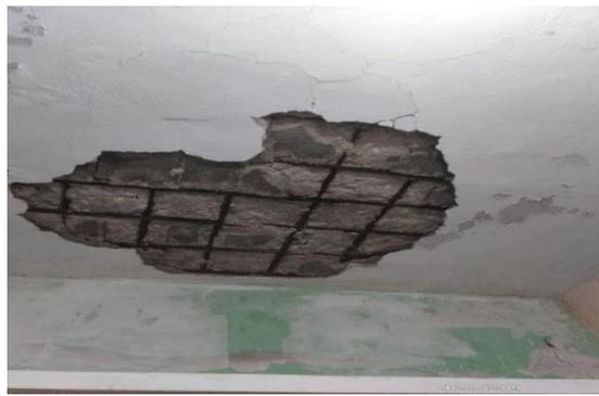
**Imagen 9: propia. Visita a casa-habitación con losa de concreto con filtraciones.**
