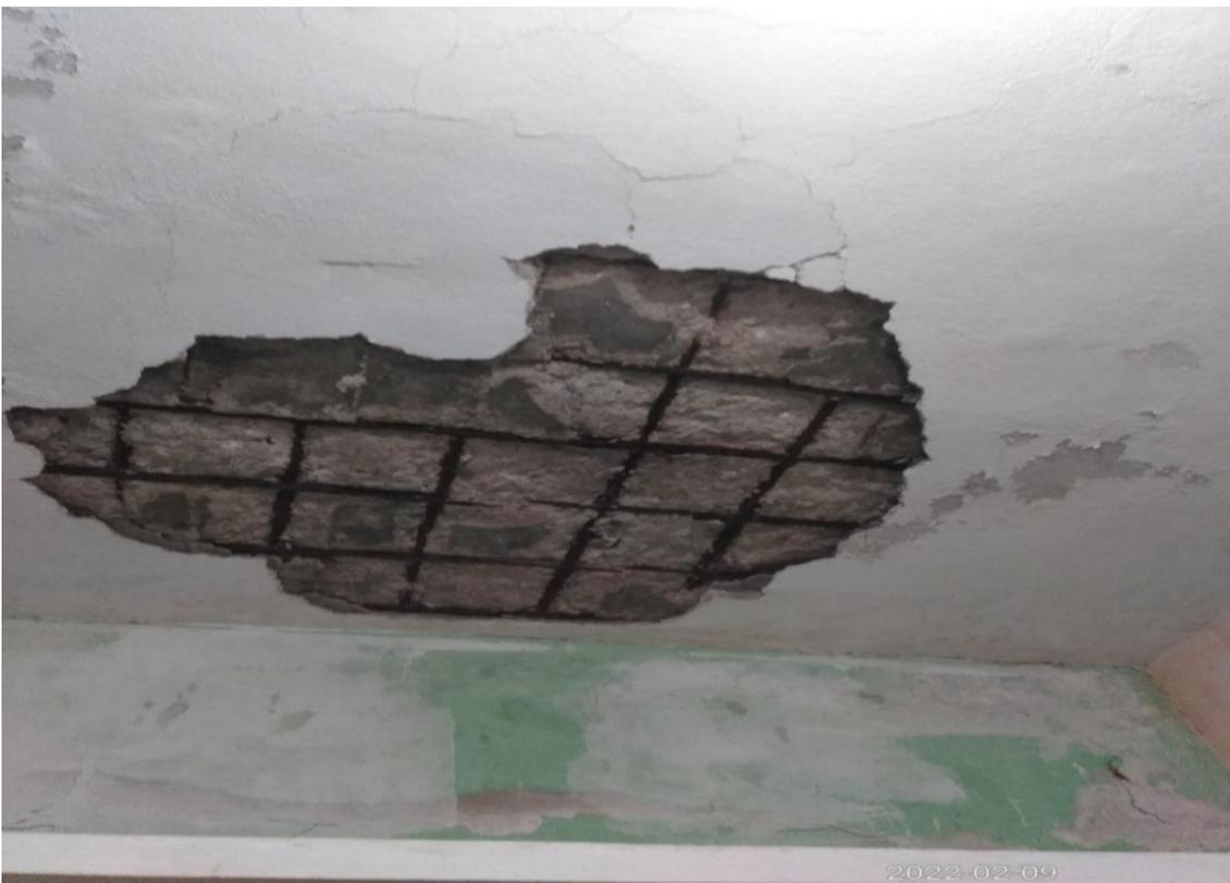
**Imagen 2: propia. Visita a casa-habitación con losa de concreto con filtraciones.**
