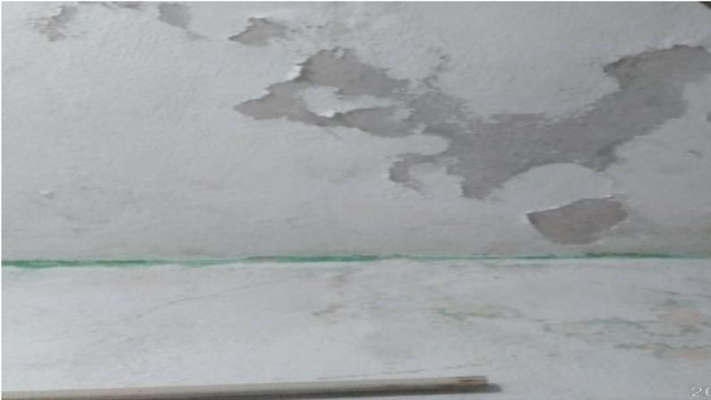
**Imagen 1: propia. Visita a casa-habitación con losa de concreto con filtraciones.**
