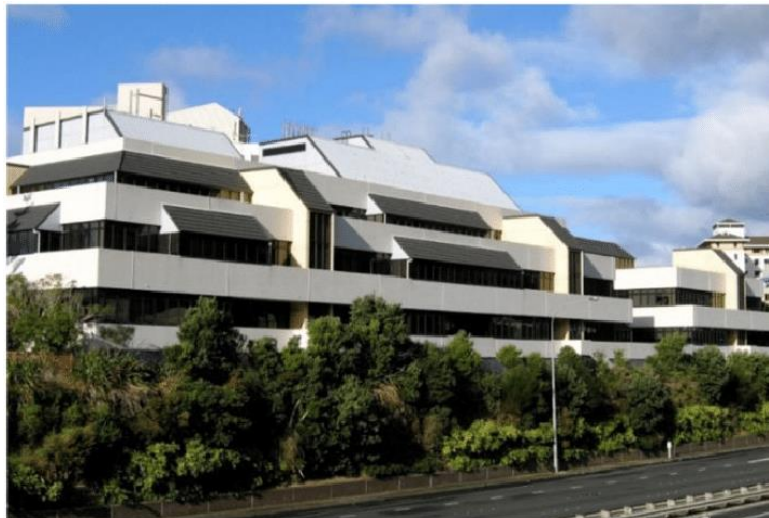
Figura 1.3: Edificio William Clayton en Nueva Zelanda. Makris, Nicos. (2018).
