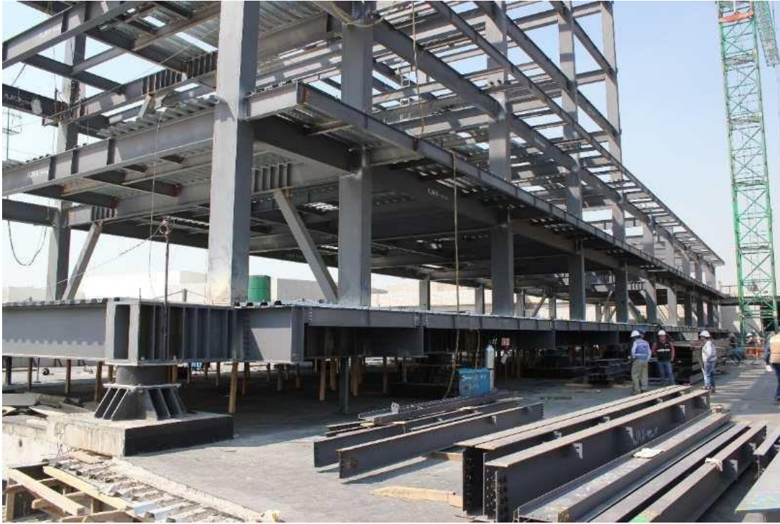
Figura 1.1: Hotel Vía Vallejo, Ciudad de México (México).
