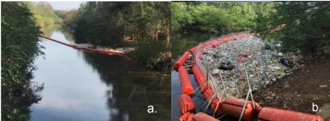
Ilustración 4. a) Instalación del dispositivo B.O.B. b) Contención de basura flotante por dispositivo modificado
