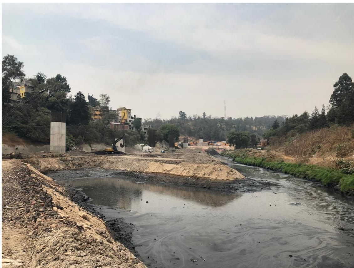
Ilustración 15. Proceso de limpieza de la presa por método de deshidratación
