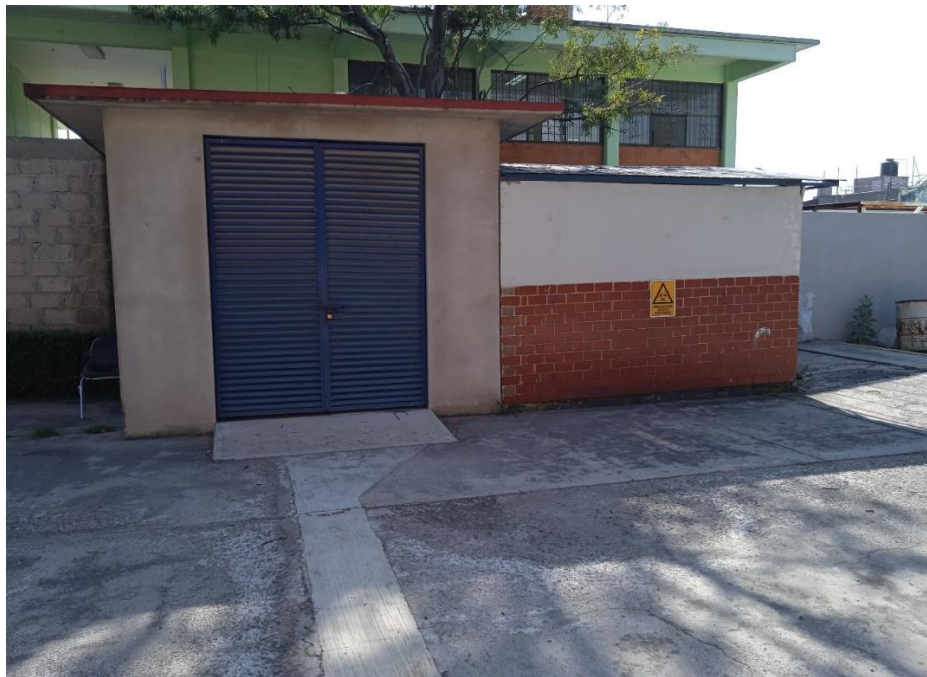
Imagen 2. Almacén temporal de R.P.B.I. de la CUAS Estado de México
