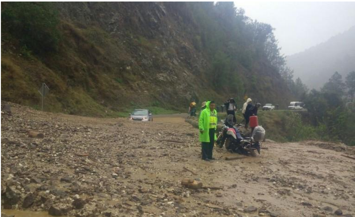
Figura 3.10 Carretera obstruida a causa de un flujo de lodos. (Laura Molina, 2017)
