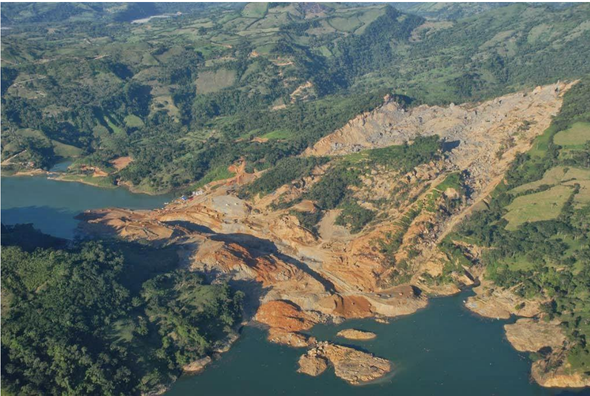
Figura 3.13 Deslizamiento que bloqueo el cauce del rio Grijalva. (2007)
