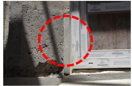
IMAGEN 78. Injerto de pieza de cantera.
