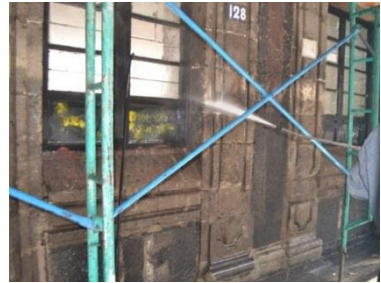
IMAGEN 73. Uso de agua a presión.
