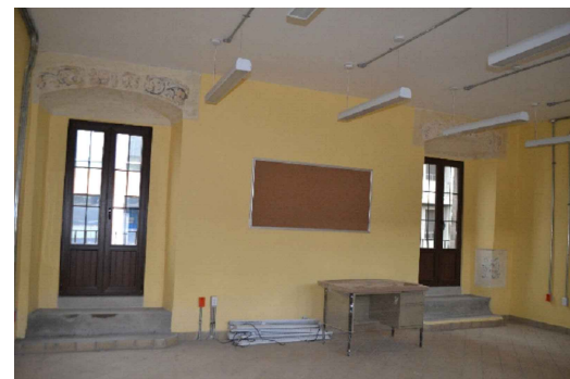
④ Aula con vestigio de pintura mural en enmarcamientos de accesos de balcón.
