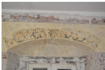
IMAGEN 84. Enlucido final de cal con pigmentación
