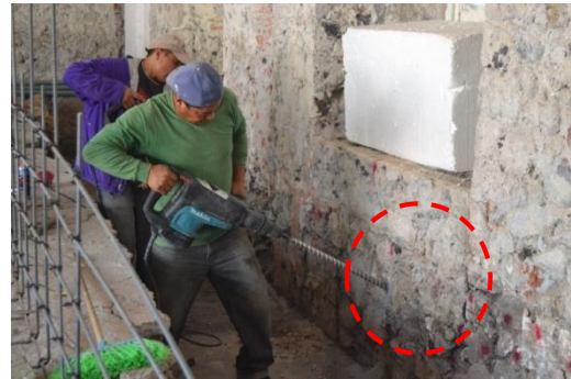
IMAGEN 87. Perforación en cimentación
