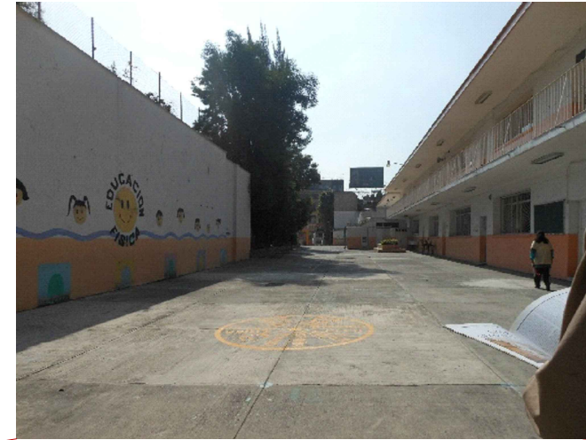
② Vista del patio que se unifica con el patio 2 y vestibula al conjunto de edificio.
