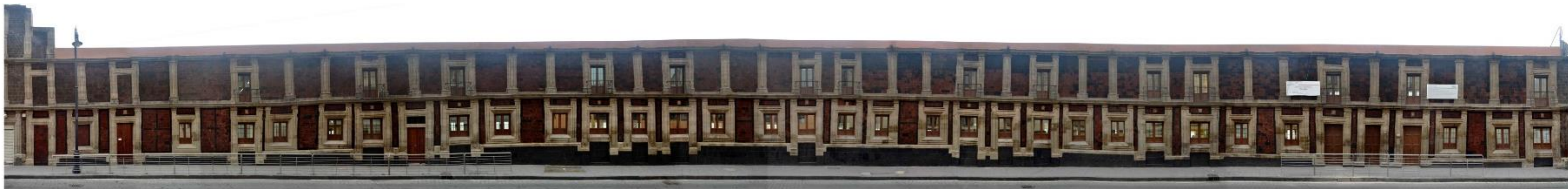
FACHADA DESPUES DE TRABAJOS DE RESTAURACIÓN
