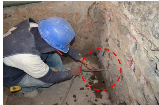
IMAGEN 88. Inyección de Hidrorepel
