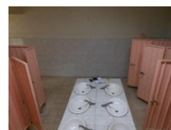
IMAGEN 53. Sanitarios de niñas ubicados en el edificio A, OCTUBRE 2013.
