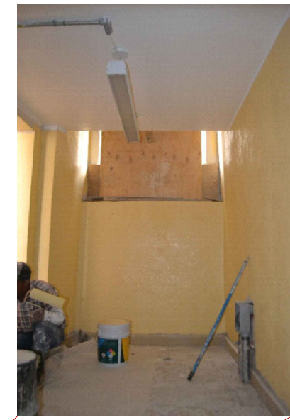
④ Trabajos de colocación de pintura vinilica en parte inferior de escaleras. Así como instalación eléctrica.
