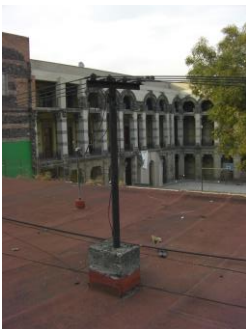
IMAGEN 57. Tendido de instalación eléctrica con resistencias de porcelana. FEBRERO 2014
