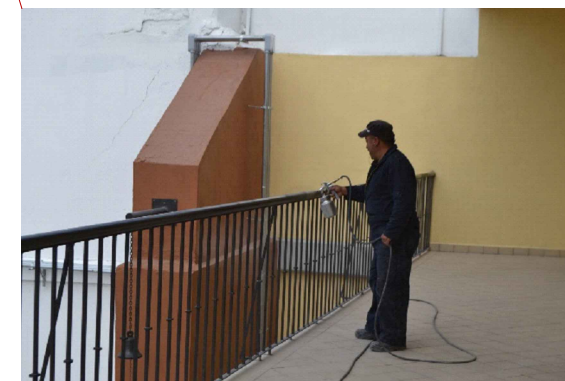
⑧ Colocación de recubrimiento en barandal como parte de los trabajos finales de restauración.
