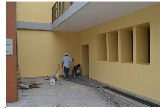
④ Se observa espacio libre después de las modificaciones de la recuperación de la crijía del edificio, desapareciendo el área que existía anteriormente del auditorio.
