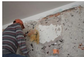
IMAGEN 82. Descubrimiento de pintura mural con bisturí
