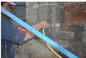
IMAGEN 81. Inyección de Mortero para adherencia de la pieza
