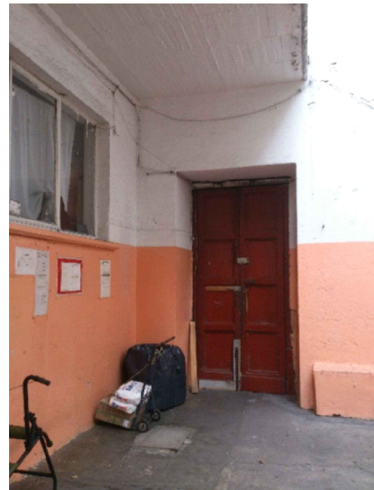
③ Patio de servicio, actual acceso principal al plantel, se observa deterioro de la puerta de madera, recubrimiento en malas condiciones y un guardapolvo de pintura esmalte inadecuado a los muros. se logra identificar cables de instalaciones hasta el momento desconocidas expuestas al intemperie.
