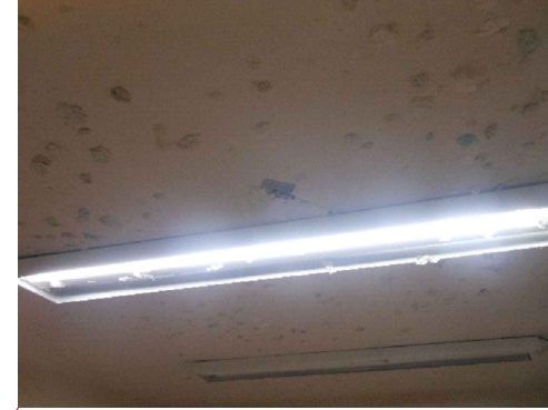
5 Acumulación de bolas de papel en plafón en baños de niños y niñas, como daño al espacio.
