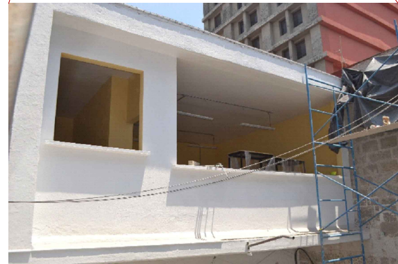
⑥ Bodega visto desde patio exterior.
