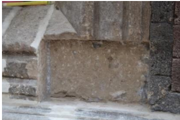
IMAGEN 79. Retiro de Pieza Dañada
