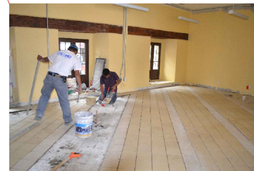
⑧ Colocación de baldosas cerámicas de 20 X 20 cms color amarillo, colocado a 45°, en área administrativa de la escuela.
