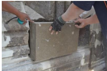
IMAGEN 80. Colocación de Pieza para labrado en sitio
