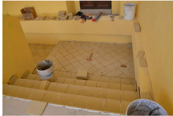
① Colocación de piso con cambio de dirección formando un tapete cerámico, en las escaleras nuevas.
