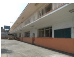
IMAGEN 51. Vista de Aulas edificio
