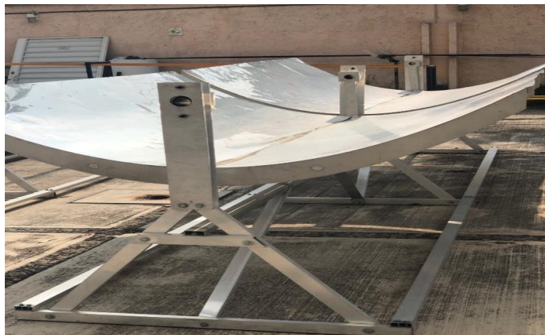
Figura 4.9 base de estructuras de las parábolas del sistema de colectores solares de las fes Aragón.
