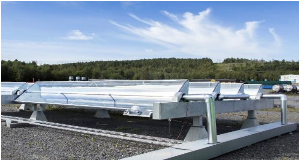
Figura 3.2 Colector Solar Parabólico.
