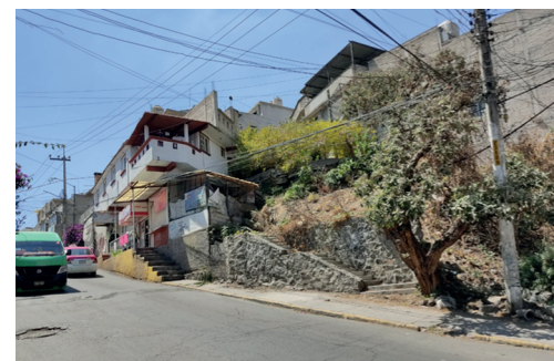
Imagen 5. Banqueta sin rampa, únicamente escaleras para transitar. Al lado unas escaleras inconclusas, que llevan a un terreno baldío en la periferia de la CDMX. Camino a la Cantera, Tlalpan, 2023
