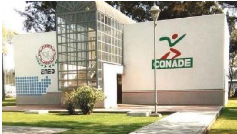
Ilustración 30. Instalaciones de CONADE, Villas Tlalpan
