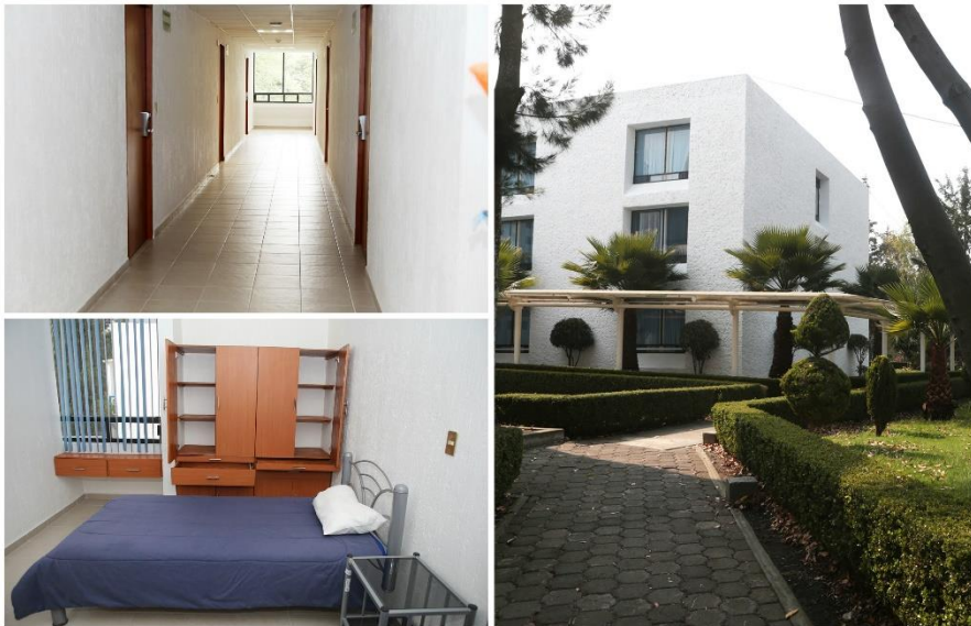
Ilustración 33. Edificio de Residencia, CONADE Villas Tlalpan
