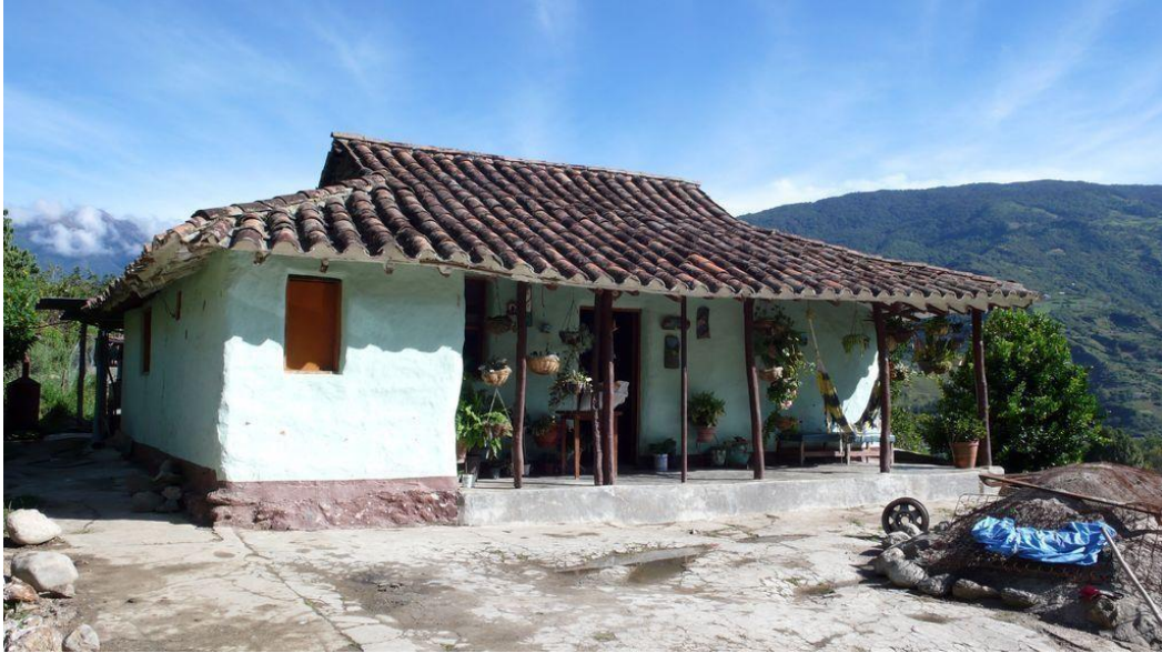
Figura 7 Casa de Bajareque
