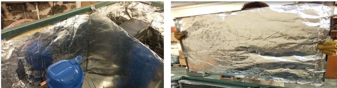
Figura 5-10. Colocación del aislante térmico en el interior de las tapas de acero galvanizado. (Diseño y construcción de una bomba de calor geotérmica 3 TR, 2022)
