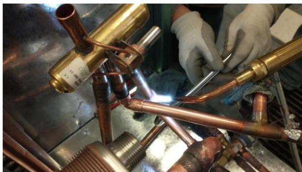
*Figura 5-14. Tubería de cobre soldada con soldadura de plata y oxi-acetileno. (Diseño y construcción de una bomba de calor geotérmica 3 TR, 2022)*
