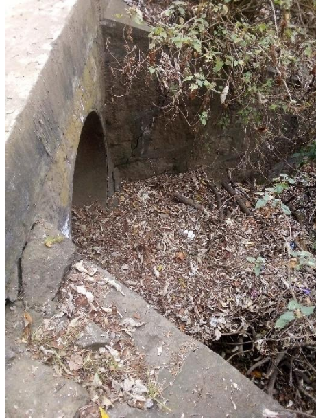
Fotografía 17 de canaleta para el paso de los escurrimientos. Foto propia.
