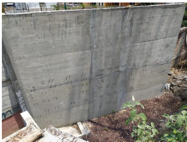
Fotografía 31: Construcción de la barda de 5 metros, en la calle de las Buganvilias. Fuente: Archivo propio
