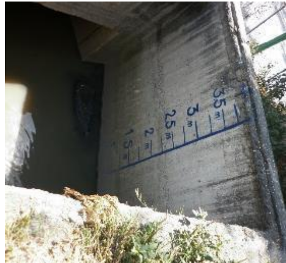
Fotografía 15: Profundidad de lumbreira. Foto propia
