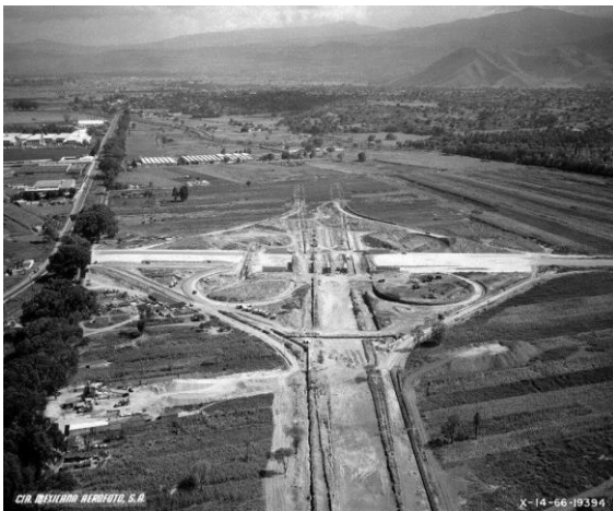
Fotografía 1: Construcción de Viaducto- Tlalpan en 1968, al fondo se observa los predios deprimidos y la construcción del Anillo Periférico. Fuente: ICA aerofoto (1966). CIA Mexicana Aerofoto S.A. (visto por última vez el día 23 de diciembre del 2022 en https://www.facebook.com/tlalpanhistoria/photos/el-tr%C3%A9bol-del-anillo-perif%C3%A9rico-y-el-viaducto-tlalpan-en-una-fotograf%C3%ADa-%C3%A9rea-de/623164207768036/ ).
