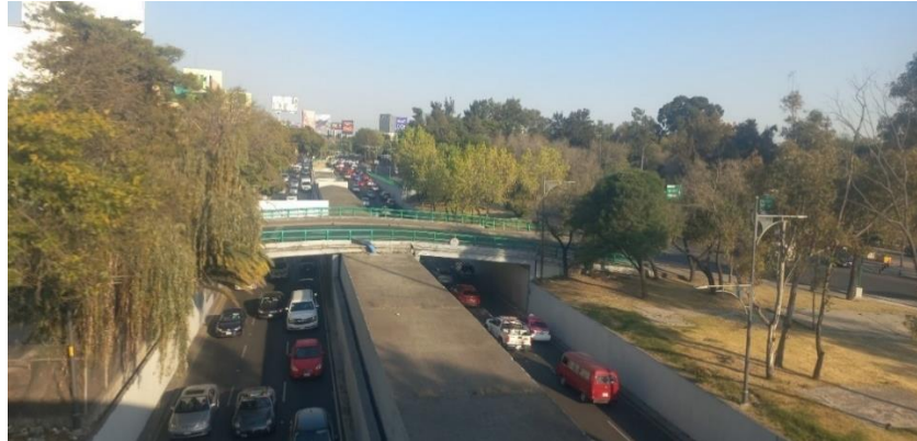
Ilustración 34. Borde Viaducto Río de la Piedad
