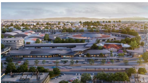
Ilustración 30. Renovación del CETRAM San Lázaro
