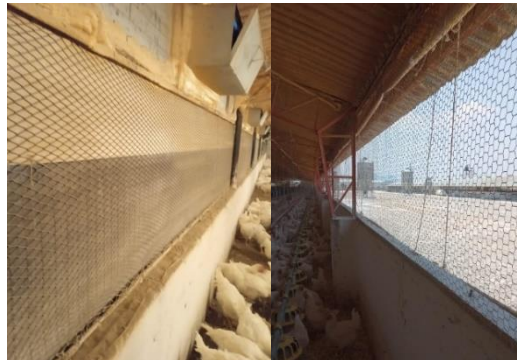
Ilustración 16 Malla pajarea en caseta de ambiente controlado y caseta de ambiente natural.
