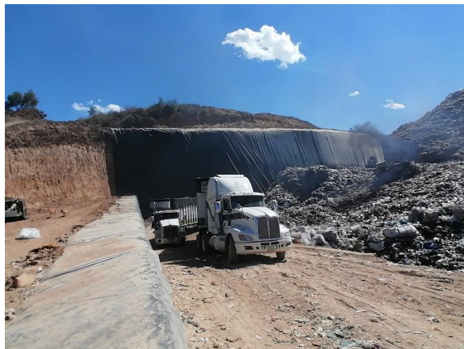
Fotografía 21. Descarga de residuos en celda activa.
