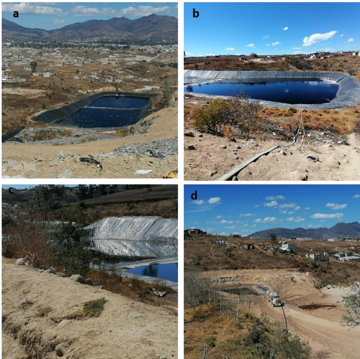
Foto 3.4 Laguna principal de lixiviados (a y c), bombeo de lixiviados a la laguna de evaporación (b) y segunda laguna de lixiviados (d)
