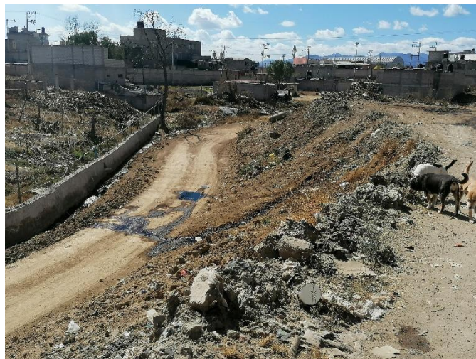
Fotografía 3. Asentamientos urbanos al suroeste del relleno sanitario.
