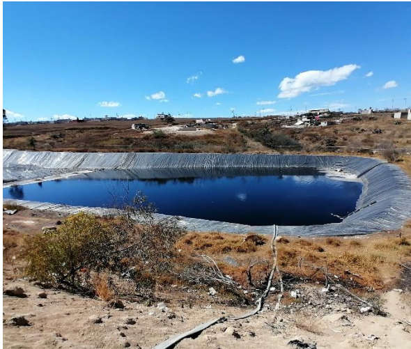
Fotografía 11. Bombeo de lixiviados a la laguna principal.
