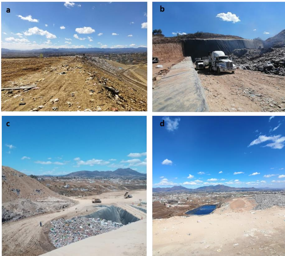
Foto 3.3 Celda cerrada (a y d), celda en operación (b y c)
