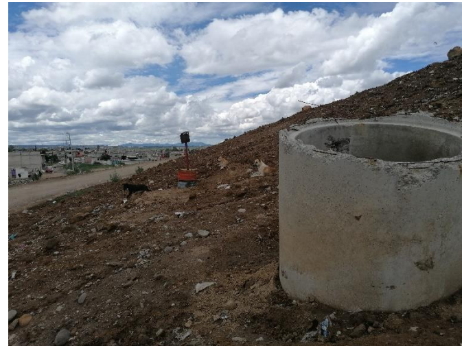
Fotografía 14. Cárcamo de lixiviados y pozo de venteo de biogás.
