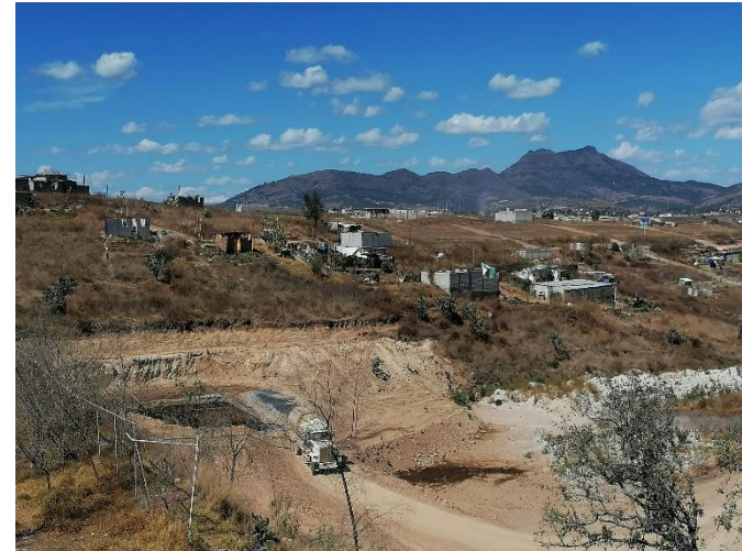
Fotografía 12. Laguna de lixiviados secundaria.
