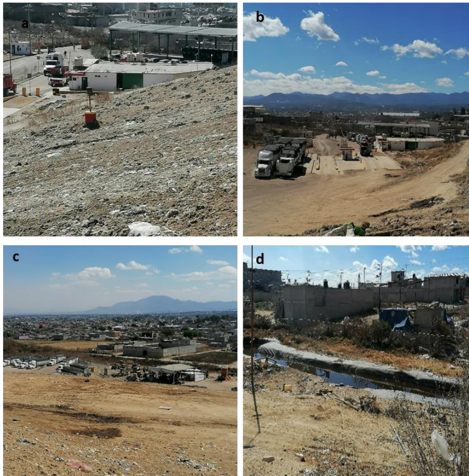
Foto 3.2 Infraestructura del relleno sanitario Cuautitlán Izcalli. Área de oficinas y estacionamiento (a), taller de mantenimiento (b), área de pesaje de camiones (c) y canal de aguas pluviales (d)
