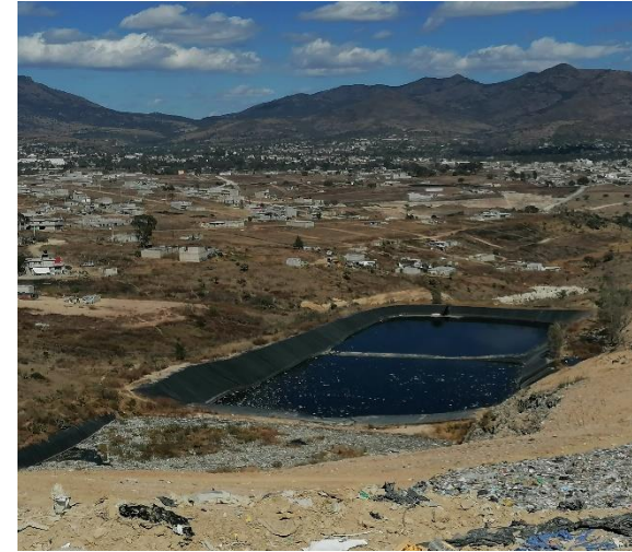
Fotografía 10. Laguna principal de recuperación de lixiviados.
