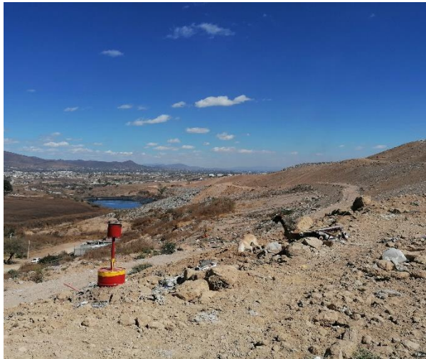
Fotografía 13. Pozo de venteo de biogás.
