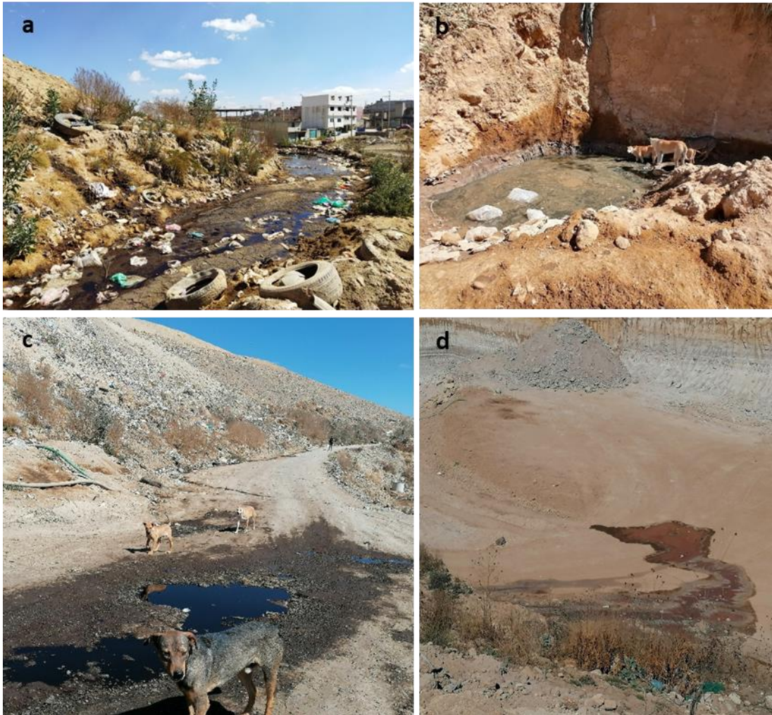
Foto 3.7 Acumulación de lixiviados a un costado de la celda (a), acumulación de lixiviados en zona adyacente a la celda (b), acumulación de lixiviados en caminos (c), escurrimiento de lixiviados (c)
