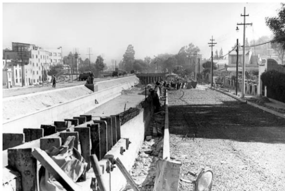
GRAF.126/REP.F15/ IMAGEN: CONSTRUCCION DEL VIADUCTO/1952 / EL PERIODICO EL UNIVERSAL
