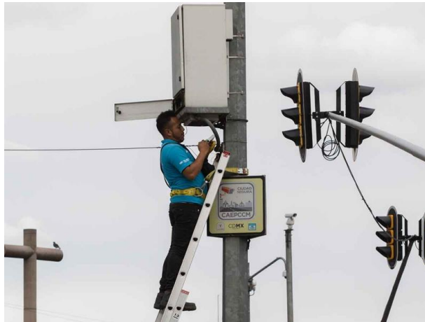
GRAF.173 / IMAGEN; INSTALACION DE CAMARA CONECTADA AL SISTEMA C5 DE LA CDMX.
