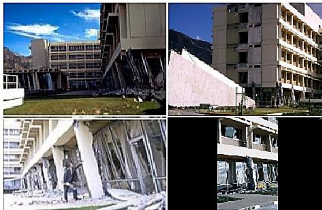
Figura 2.6 Daños en el hospital Olive View, sismo de San Fernando, 1971 (Páez et al. , 2017)
