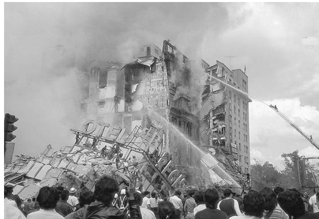
Figura 3.6 Daños por el sismo de 1985 (Pavón y Salcido, 2019)
