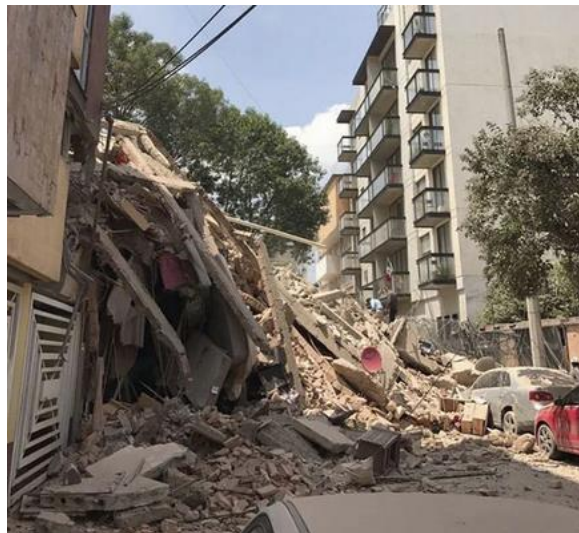
Figura 3.7 Daños por el sismo de 2017 (Pavón y Salcido, 2019)
