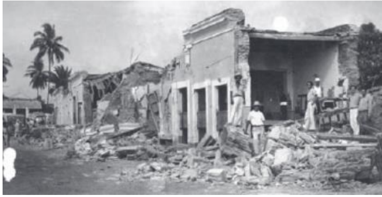
Figura 3.4 Daños por el sismo de 1941 (Bracamontes, 2015)
