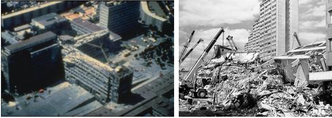
Figura 1.4 Colapso de edificio con irregularidad en planta en la Ciudad de México (Tena, 2010)
