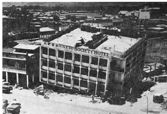
Figura 1.1 Colapso de la planta baja y giro global del Hotel New Society, en Filipinas (Hernández y López, 2007)
