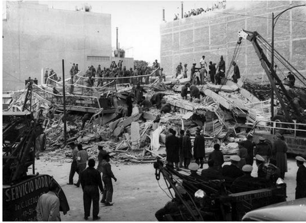
Figura 3.5 Daños por el sismo de 1957 (Pavón y Salcido, 2019)
