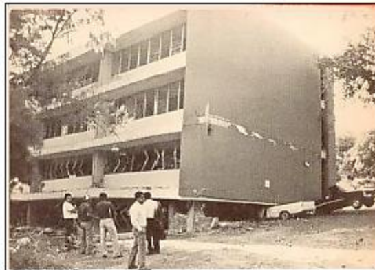
Figura 2.9 Daños en edificio con PBD, sismo de San Salvador, 1986 (Álvarez, 1987)
