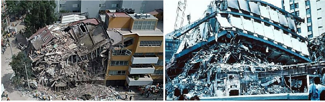
Figura 2.8 Daños en edificios con PBD, sismo de Michoacán, 1985 (Forbes, 2015)
