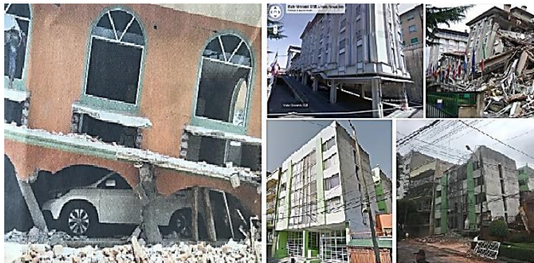
Figura 2.15 Daños y colapso de edificaciones con problemas de PBD en el sismo de México, 2017 (proporcionado por II-UNAM)
