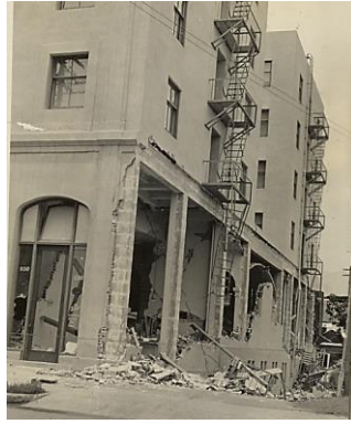
Figura 2.5 Hotel Carrillo después del terremoto de 1925, California (Freeman, 1932)
