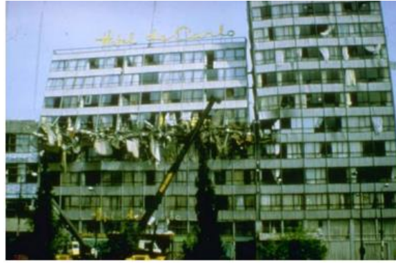
Figura 1.6 Daños en edificios con problemas de golpeteo (Astorga y Rivero, 2009)
