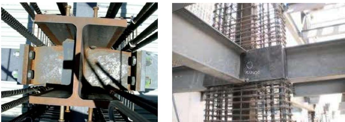
**Figura 1.10 Conexiones típicas de traves y columnas de acero embebidas en concreto.**
