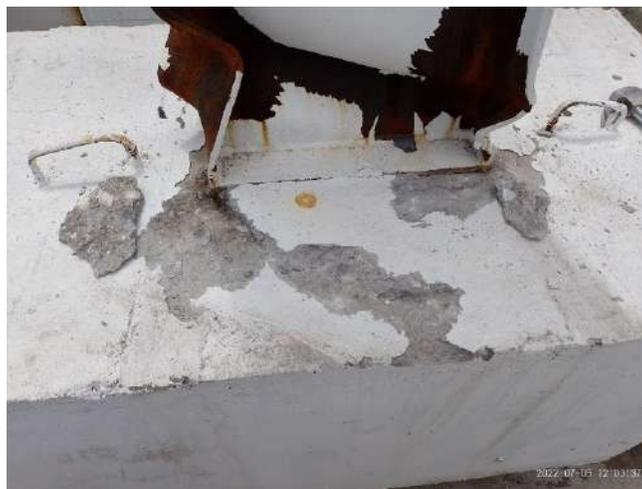
(a) Concreto fracturado y desprendido en zona dañada.
