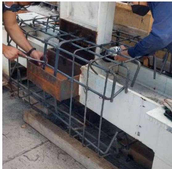
**Figura 3.10 Armado de la conexión MESC.**
