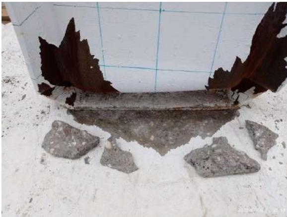
a) Concreto fracturado y desprendido en zona dañada.
