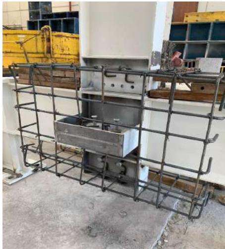
**Figura 3.13 Armado de la conexión MES1.**
