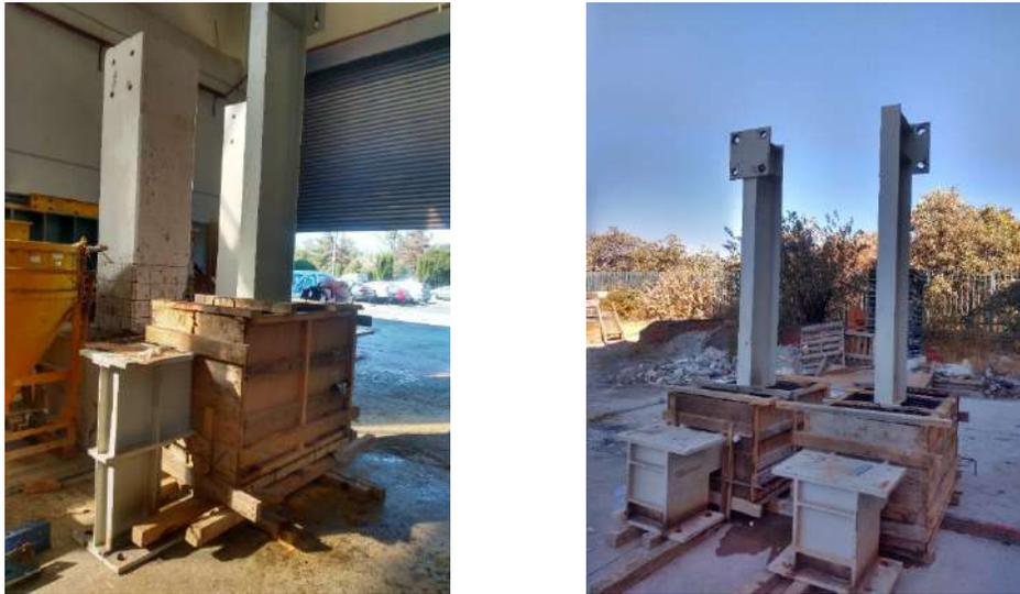
**Figura 3.19 Cimbrado final de los especímenes.**
