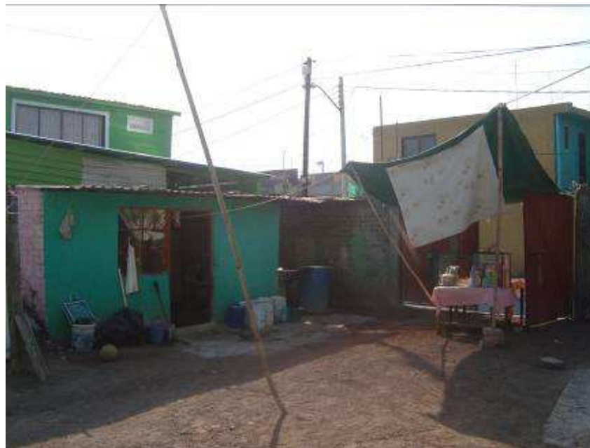
Fachada principal Cuerpo 2. Se aprecia techumbre ligera y muros de carga sin estructurar.
