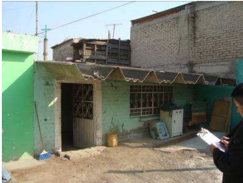
Fachada principal Cuerpo 2. Se aprecia techumbre ligera y muros de carga sin estructurar.
