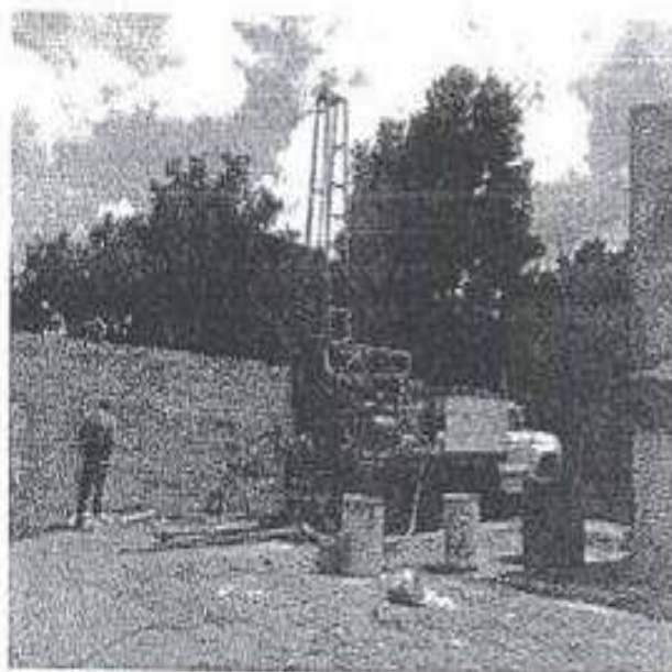
Fotografía 2 Localización del sondeo SM-1.
