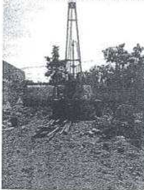
Fotografía 4 Localización del sondeo SM-2
