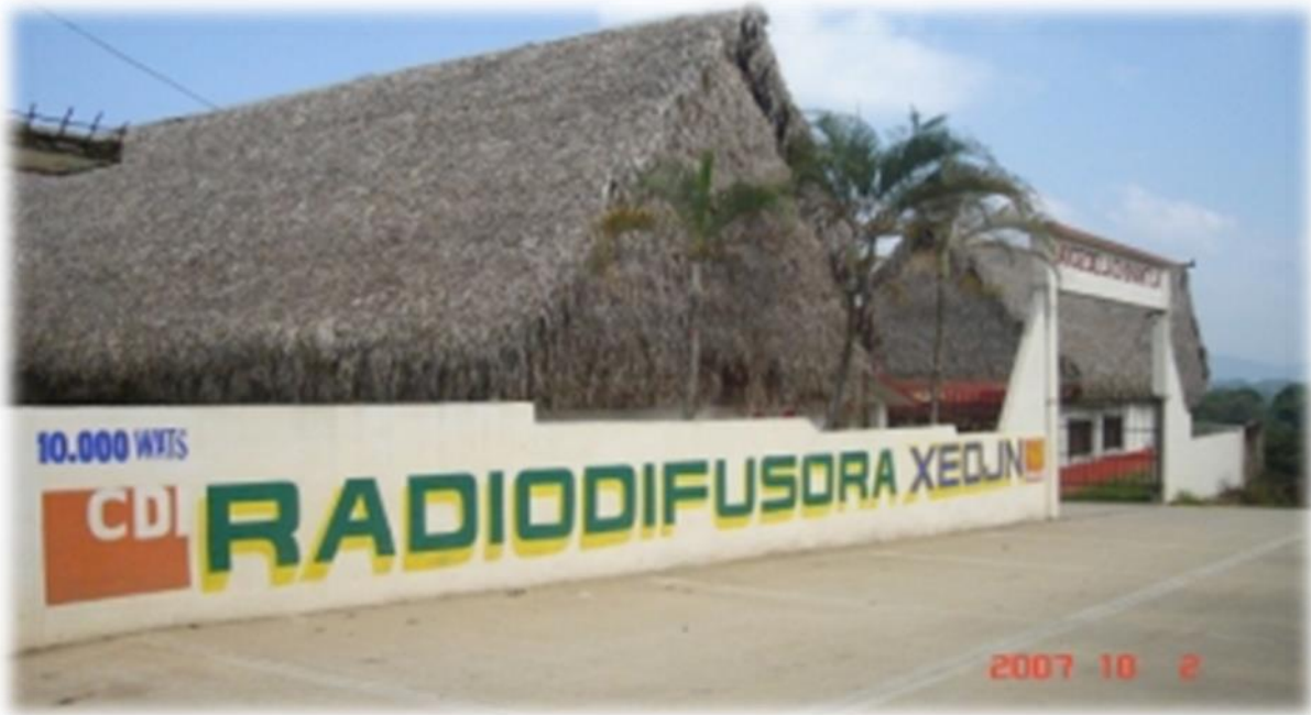
Instalaciones de la XEOJN Foto: Portal CDI
