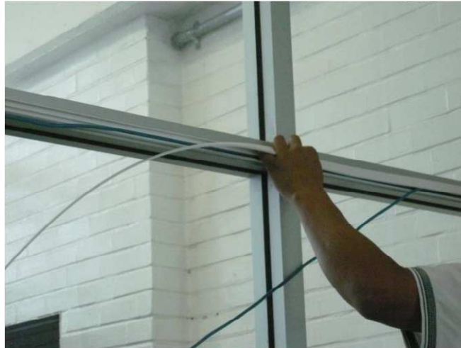
Figura 3.13 Colocación de canaleta. Elaboración personal (2012).
