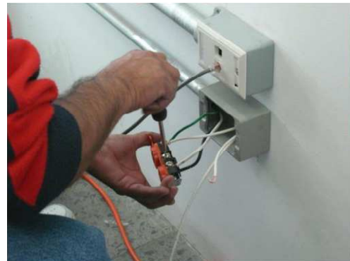
Figura 3.15 Colocación del contacto. Elaboración personal (2012).
