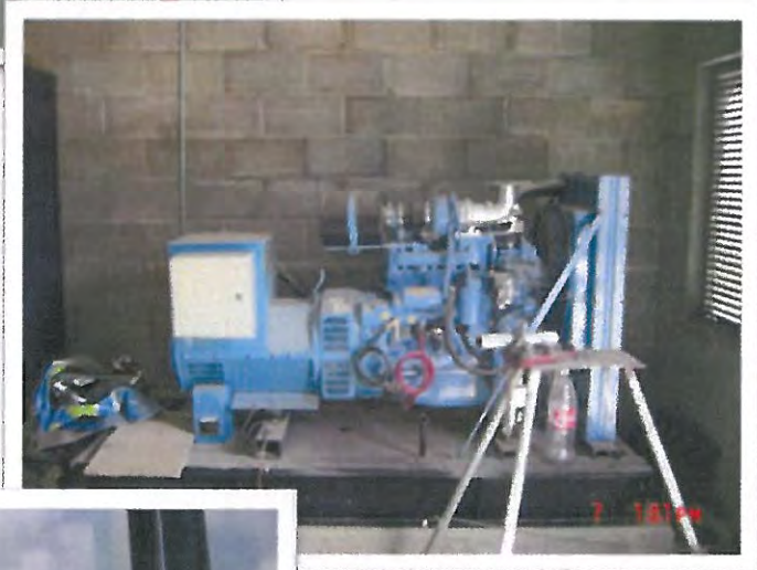
INSTALACIÓN DE MEDIA TENSIÓN ELÉCTRICA
