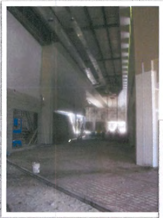
INSTALACIÓN AIRE ACONDICIONADO
