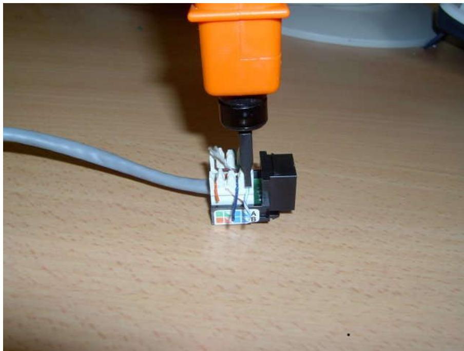
Fig. 3.3.1e Ponchado de cables.
