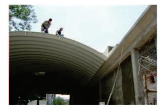
V.2.6.13 Instalación de sistemas de arco techo en cubierta
