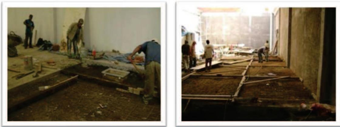
V.2.6.8 Fabricación de firme de concreto
