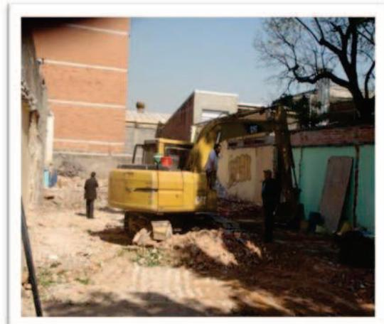
Figura V.1.2.3 Retiro de escombros producto de la demolición de la construcción existente
