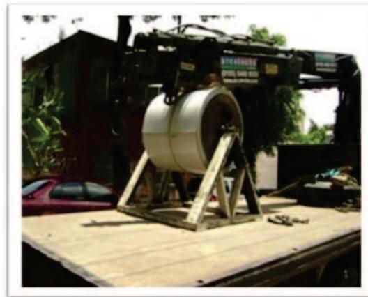
V.2.6.12 Lámina en rollo para fabricación de sistema de arco techo en sitio
