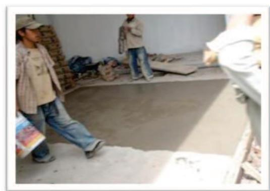
V.2.6.9 Fabricación de firme de concreto
