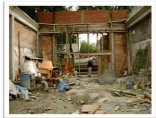
V.2.6.7 Fabricación de muros de tabique rojo recosido
