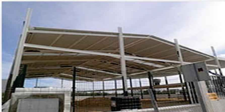
Fig. 1.4.1 Nave industrial en construcción con estructura metálica
