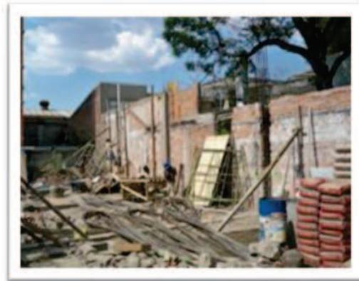
V.2.6.6 Armado y columna de concreto sobre muros existentes
