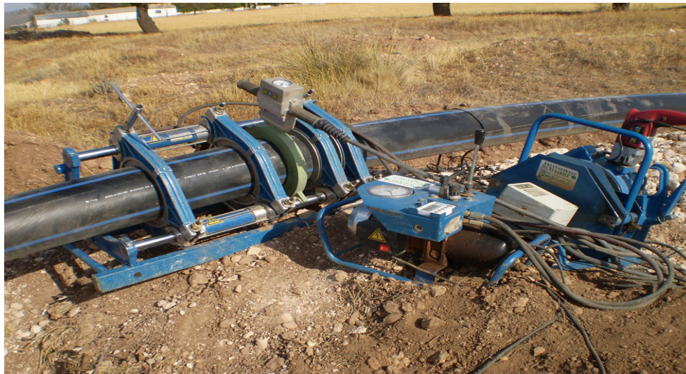
FIG. II.3.9 PROCESO DE TERMOFUSION DE TUBO PAD
