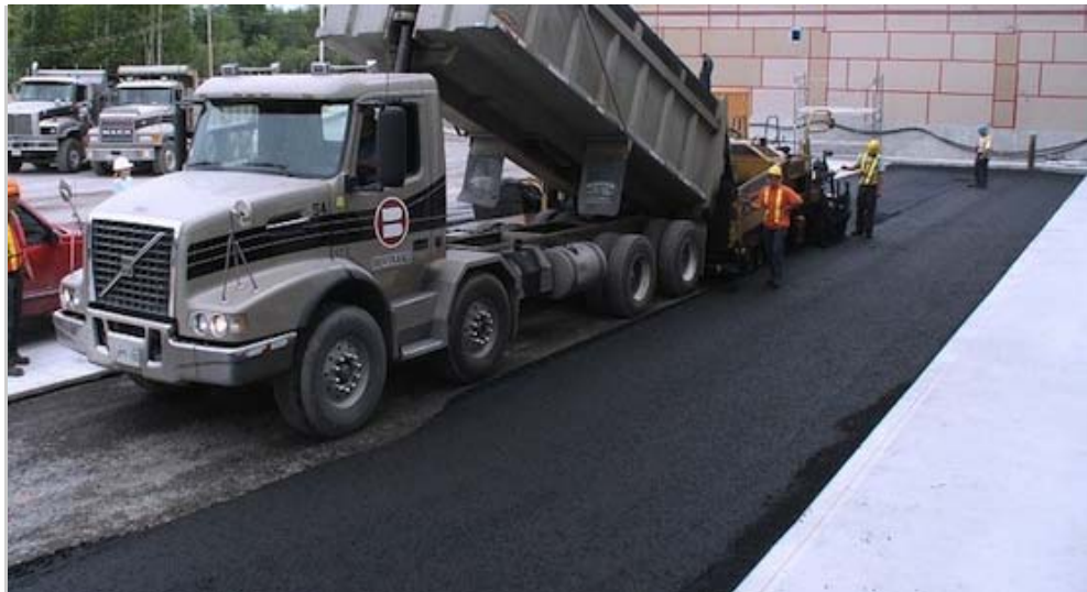
FIG. II.5.6 COLOCACIÓN DE ASFALTO
