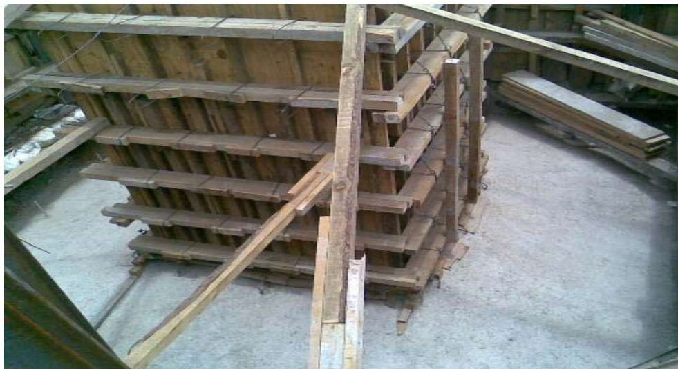
FIG. II.5.2 CONSTRUCCIÓN DE ZAPATA Y DADO
