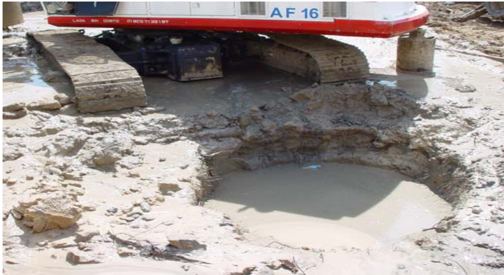
FIG. II.1.7 PERFORACIÓN PARA HINCADO DE PILAS
