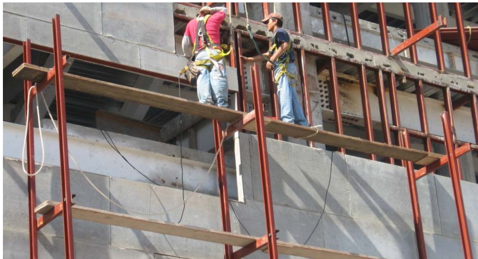
FIG. II.5.5 COLOCACION DE FALDONES
