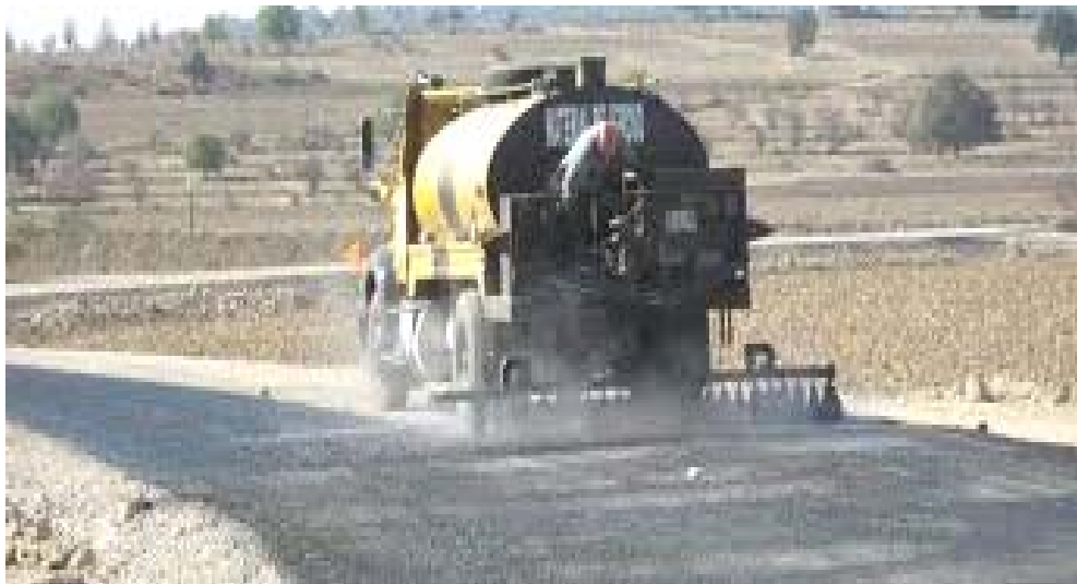
FIG. II.3.10 RIEGO DE IMPREGNACIÓN
