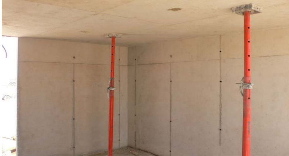
FIG. II.1.3 APUNTALAMIENTO DE LOSA
