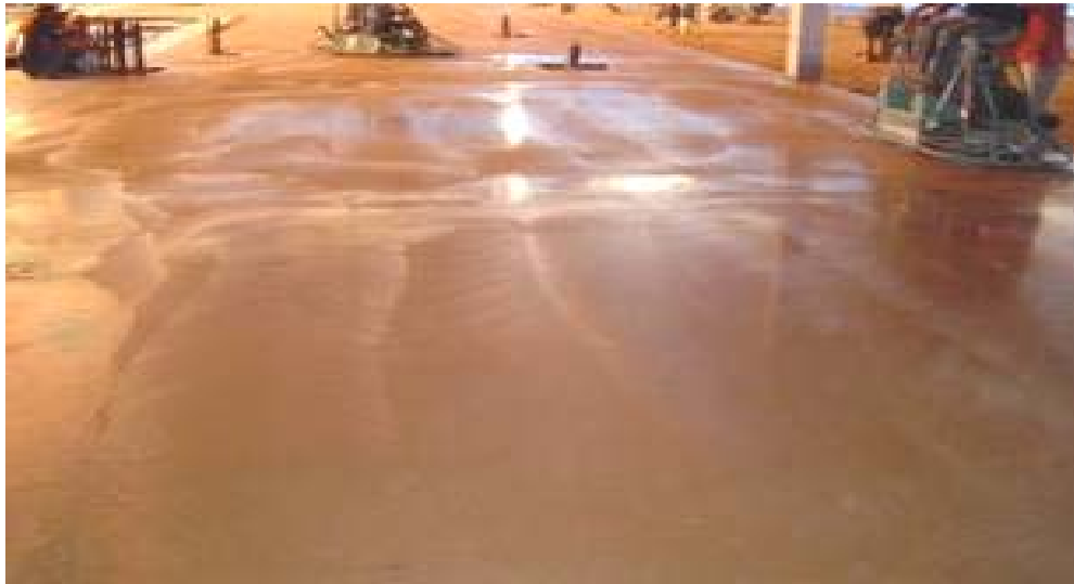
FIG. II.5.3 TERMINACIÓN DE PISO
