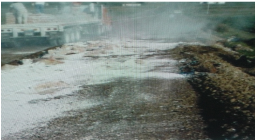
Fig. II.3.2 MEJORAMIENTO DE TERRACERIA CON CAL HIDRATADA
