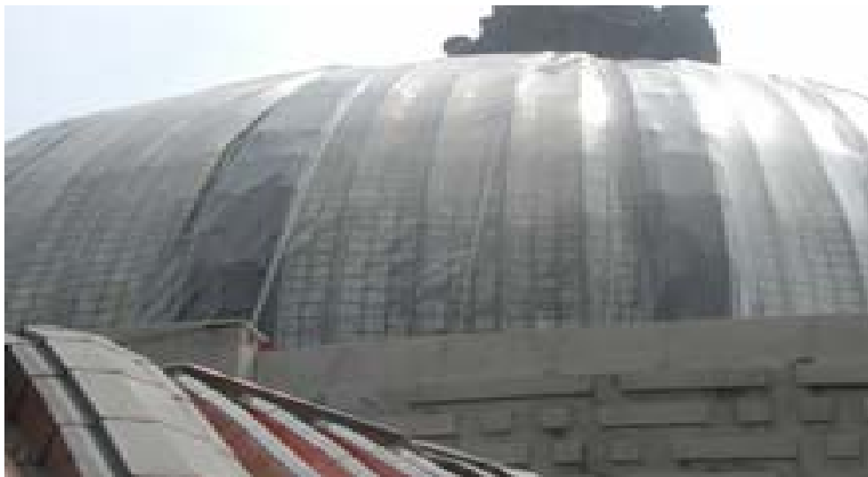
FIG. II.4.11 CÚPULA CENTRAL EN PROCESO DE RESTAURACIÓN
