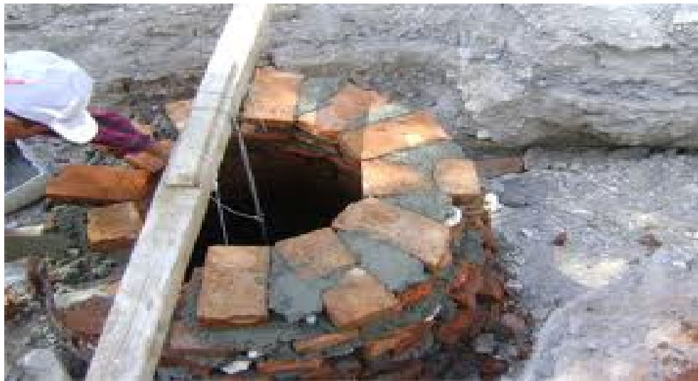
Fig. II.3.4 FABRICACION DE POZO DE VISITA
