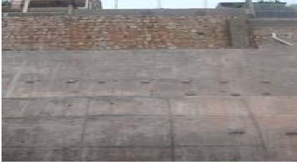
FIGURA II.1.8 MURO DE CONTENCIÓN
