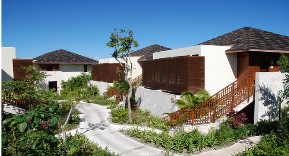
FIG. II.7.3 ACABADOS DE VILLA EN EXTERIOR
