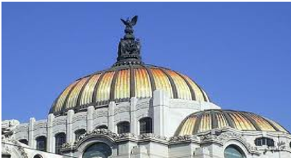
FIG. II.4.2 CÚPULA ANTES DE RESTAURACIÓN
