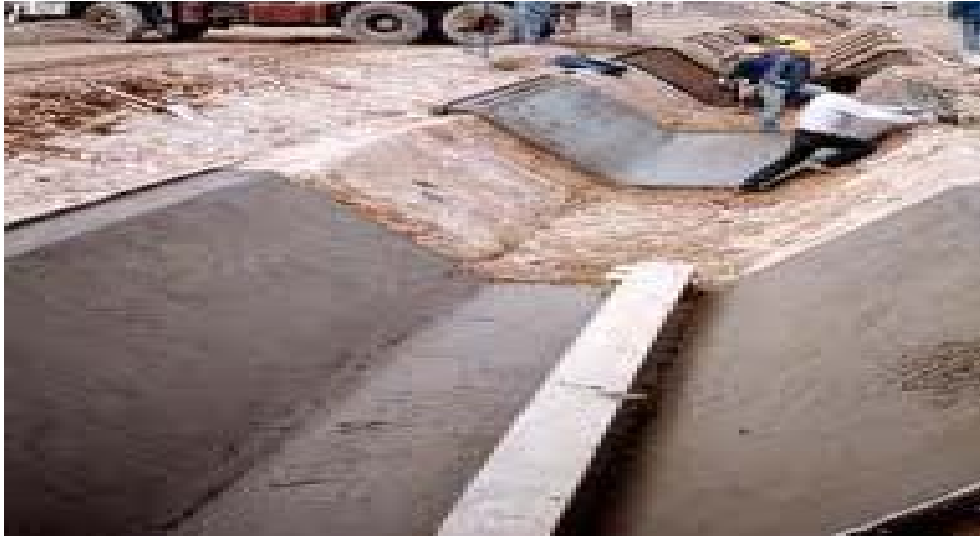
FIG. II.3.12 CANAL TRAPEZIAL DE RIEGO
