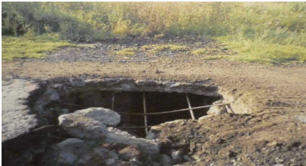
FIG. II.3.11 CANALES DE RIEGO EXISTENTES
