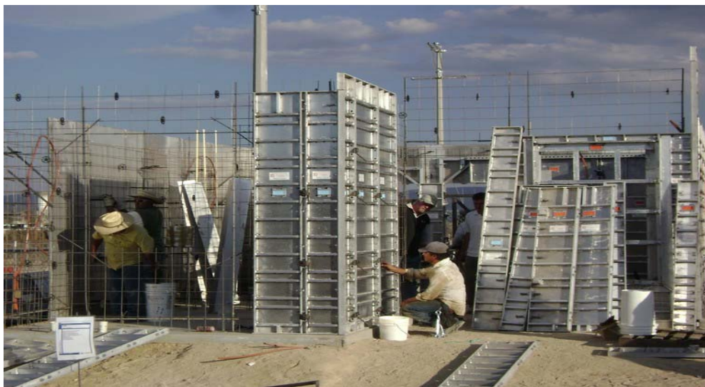
II.4.18 CIMBRADO DE MURO CON MOLDE WESTERN
