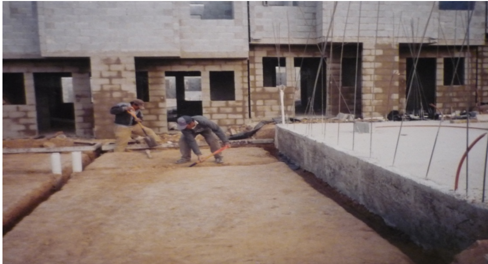
FIG. II.4.17 AFINE DE PLATAFORMAS
