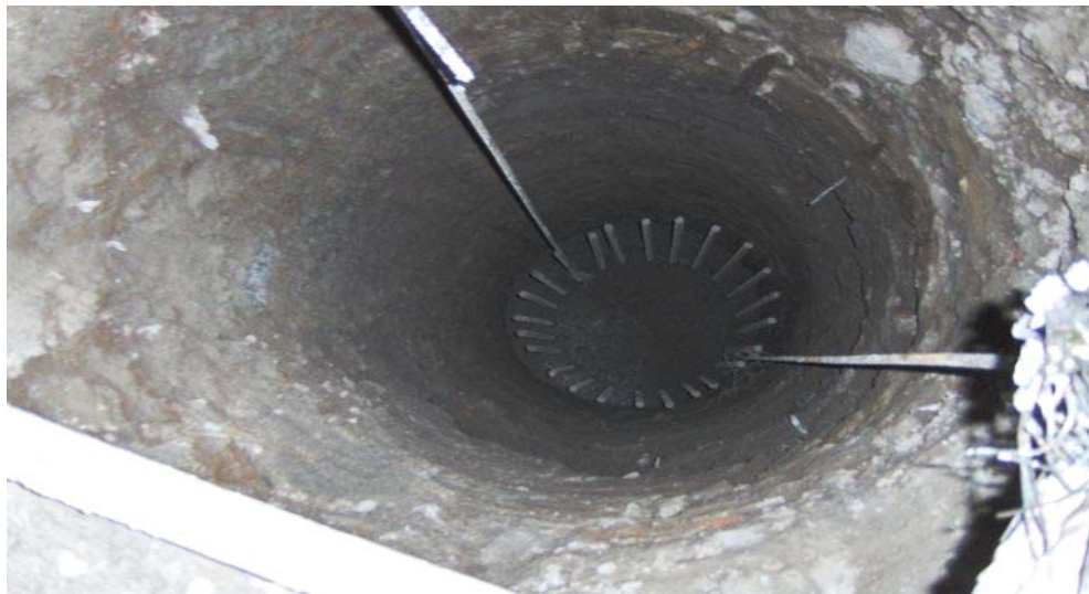
FIG. II.1.9 FABRICACIÓN DE PILAS
