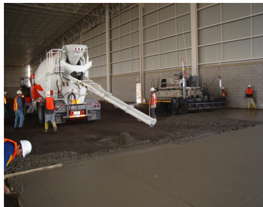
PAVIMENTO DE CONCRETO HIDRAULICO
