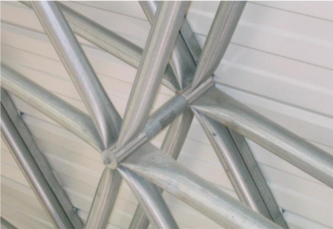
Conexiones o nodos del domo
