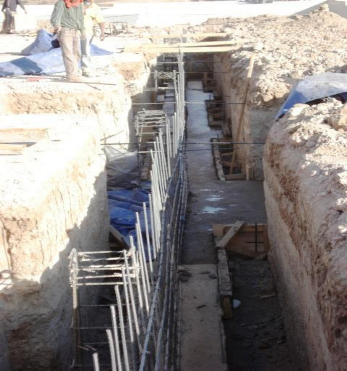
ZAPATAS CORRIDAS PARA SOPORTE DE MUROS PRECOLADOS DE FACHADA
