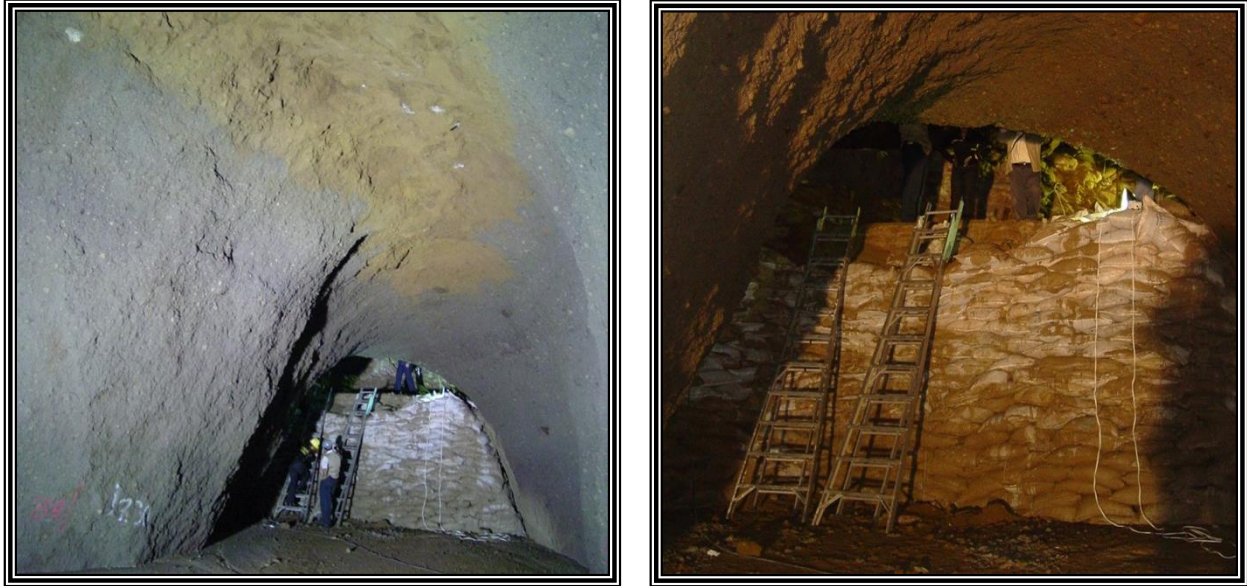
Figura. No. 34.- Procedimiento de regeneración de suelos. Nótese la regeneración de una mina con costales rellenos de material controlado, colocándolos de manera cuatropeada, hasta cubrir la oquedad completamente.
