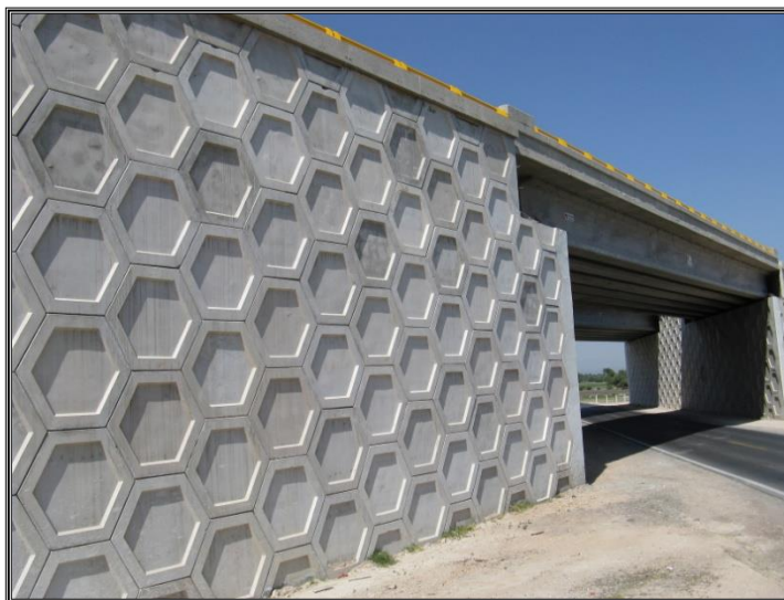
Figura No. 23.- Muro de Tierra mecánicamente estabilizado conteniendo terraplen de acceso y salida del PSV ubicado en el km. 3+040 del tramo carretero Teocalco Doxey.
