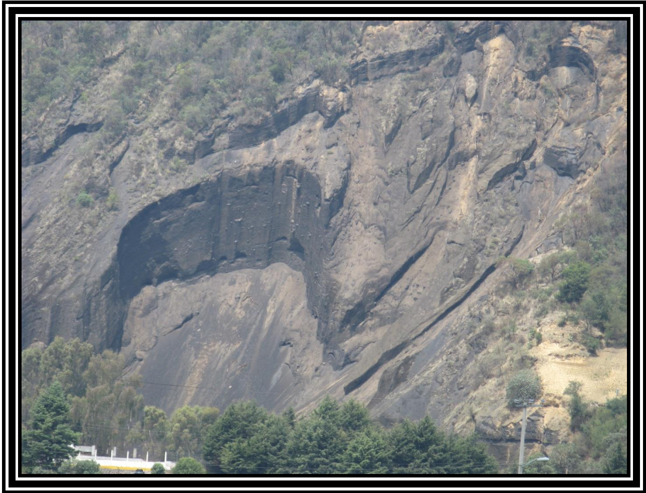
Figura No. 3.- Fotografía en Xalatlaco, Estado de México, en la que se aprecia deslizamiento de la masa de suelo, conocido como falla reticular, inducido por las raíces de los árboles.
