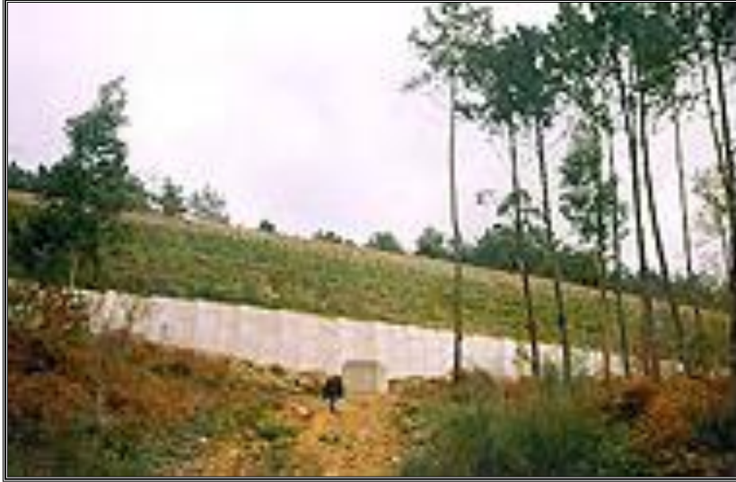
Figura No. 26.- Estabilización del suelo mediante vegetación.
