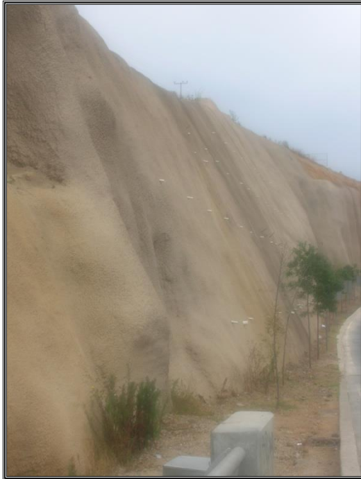
Figura No. 24.- Zampeado de concreto en el talud del Puente Los Poetas, complejo Santa Fe.
