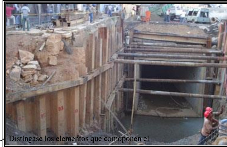
Figura No. 20.- Protección de las edificaciones circunvecinas mediante un sistema de tablaestacado.
