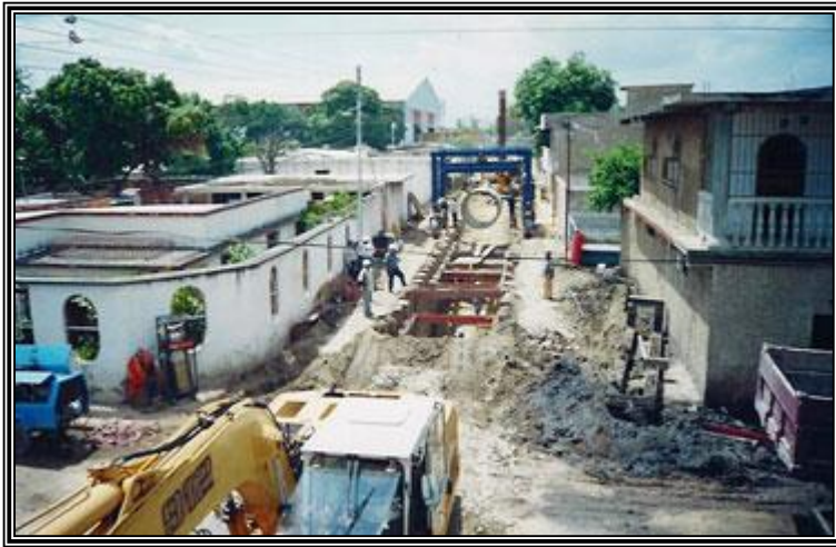
Figura No. 20.- Protección de las edificaciones circunvecinas mediante un sistema de tablaestacado.
