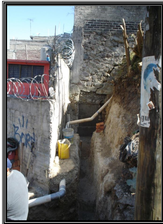
Figura. No. 38.- Nótese la grieta en la cimentación de una vivienda la cual refleja el movimiento que presenta el suelo al buscar su ángulo de reposo.
