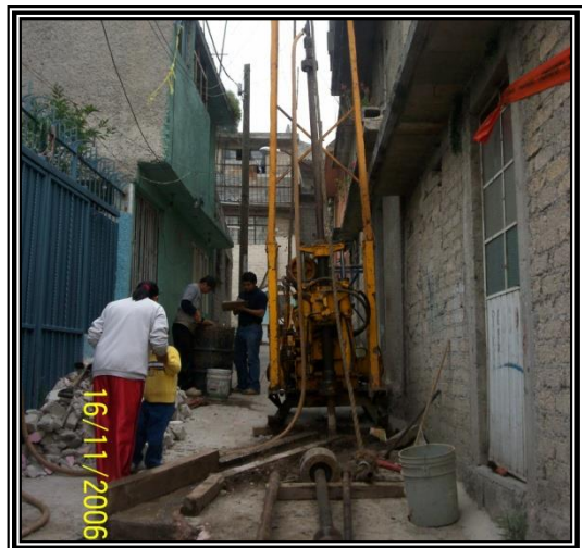
Figura No. 32.- Desarrollo de la prueba de penetración estándar.
