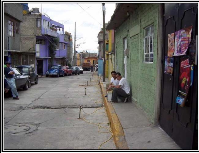
Figura No. 30.- Realización de sondeo con cono.
