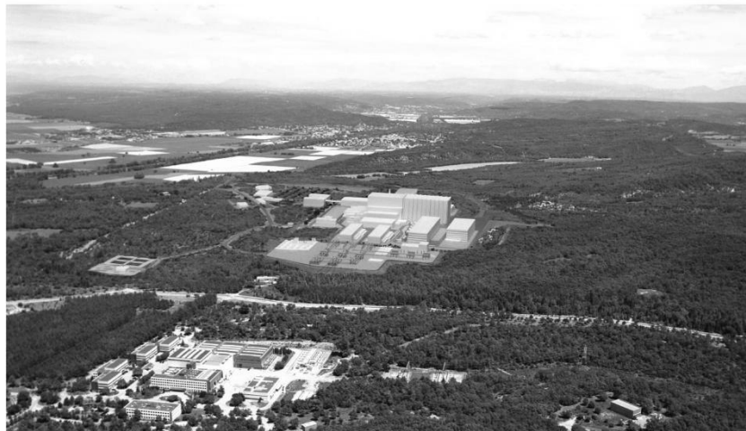
Fig. 8.5 Vista panorámica Cadarache, Francia.
