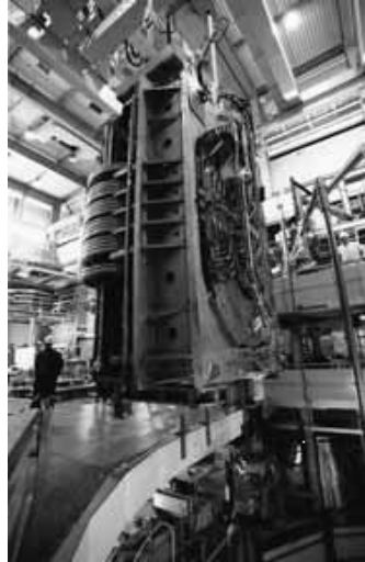
Fig. 8.1 Prototipo de la bobina de campo toroidal en la instalación para ensayos TOSKA (Karlsruhe, Alemania).
