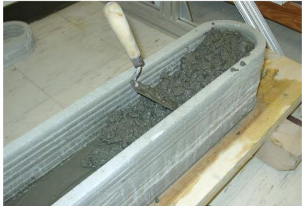
Imagen 24. Depositando concreto fresco, capa por capa. Behrokh Khoshnevis. 2005
