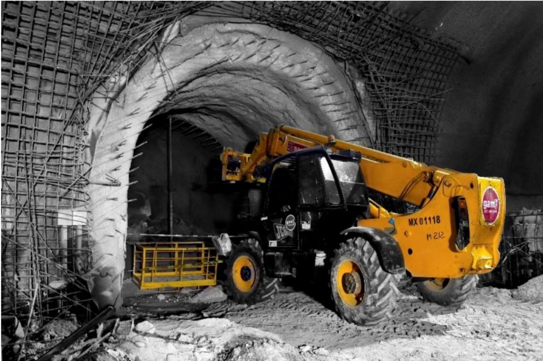
*Ilustración 15 - Nicho para instalaciones electromecánicas. SOBSE 2020.*
