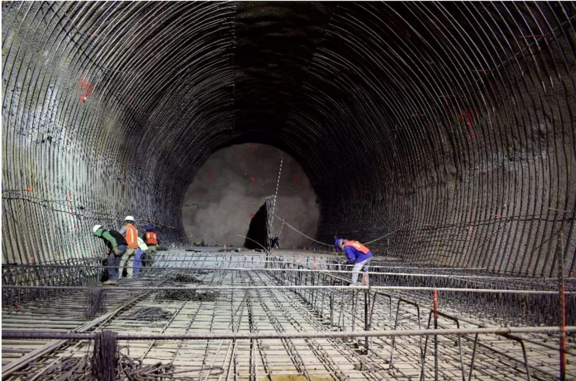
*Ilustración 9 - Habilitado de acero de refuerzo. SOBSE 2020.*
