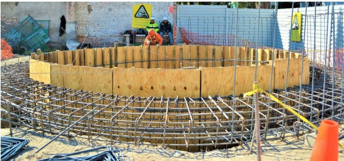
*Ilustración 4 - Excavación y habilitado de acero de refuerzo para el Brocal de la lumbrera. SOBSE 2018.*
