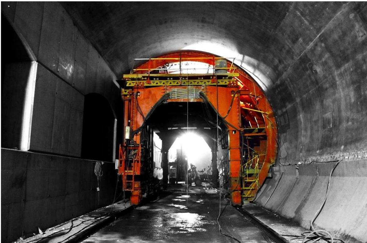
*Ilustración 10 - Cimbra metálica deslizable para la bóveda del túnel de estación. SOBSE 2020.*
