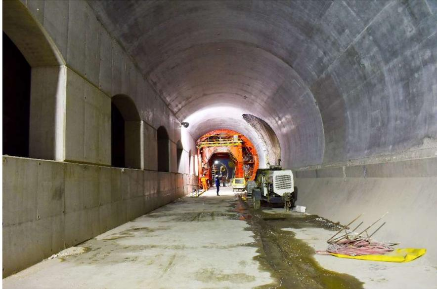
*Ilustración 11 - Estructuración de losa de fondo, muro hastial y muro central de estación. Cimbra deslizante para el colado de bóveda. Estación de 1 vía terminada su estructuración. SOBSE 2020.*
