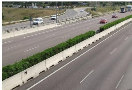
Fig.36 El muro New Jersey, es uno de los muros más duraderos principalmente por su bajo mantenimiento y durabilidad.
