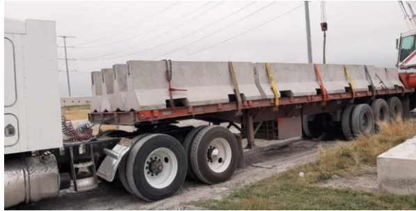
Fig.35 Las barreras New jersey son elementos prefabricados de 2.00 a 3.00 mts de largo.
