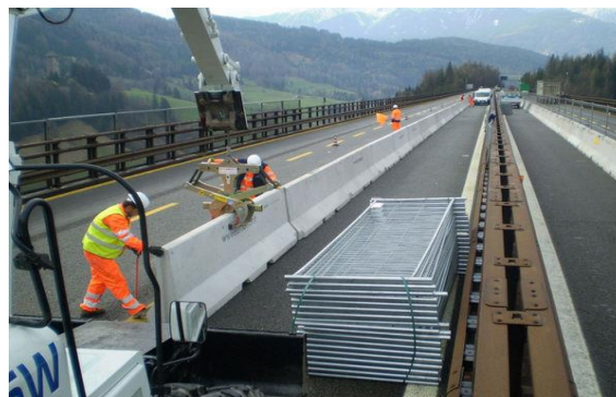
Fig.32 Personal y equipo, para colocación de las barreras en la vialidad.
