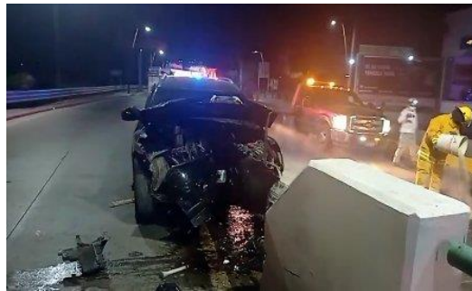
Fig.3 Camioneta se estrelló contra muro de contención que divide los dos carriles de circulación.
