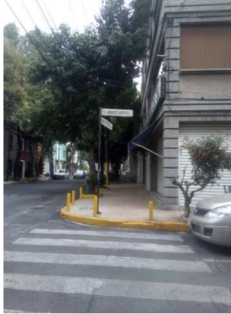
Fotografía 51. Calle Nogal esquina calle Amado Nervo. No existe rampa de accesibilidad universal.
