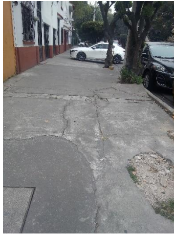
Fotografía 33. Calle Nilo banqueta sur, casi esquina avenida Azcapotzalco.
