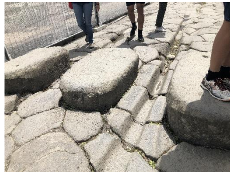
Fotografía 4. Paso peatonal entre dos aceras que permite el paso del agua. Fuente: archivo personal tomada en Pompeya el 31 de mayo de 2019.
