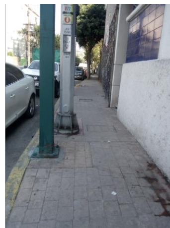
Fotografía 49. La infraestructura ocupa casi la mitad del ancho de banqueta que además es escaso.
