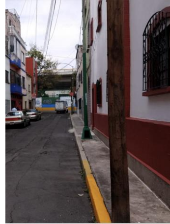
Fotografía 52. La infraestructura ocupa casi la totalidad del escaso ancho de banqueta.
