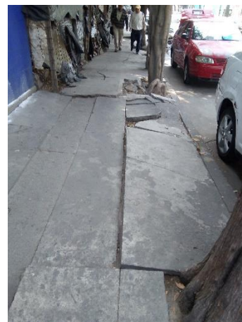
Fotografía 16. Banqueta levantada por las raíces de los árboles, colonia Santa María la Ribera.
