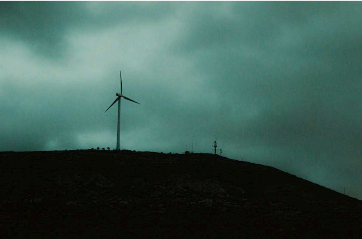
Fotografía 61 Generadores, Daniel Jiménez Vega, 2014.
