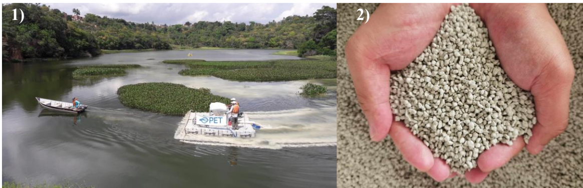
Figura 2. (1) Aplicación de Phoslock® en cuerpo de agua eutrófico y (2) Phoslock® granulado (PET, 2017)
