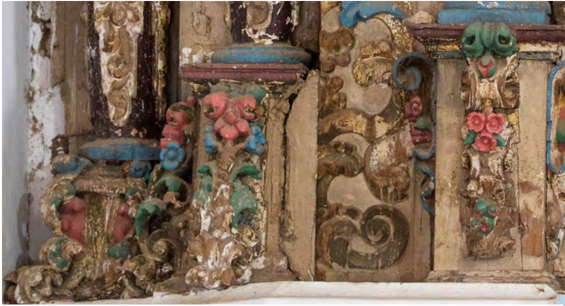
Fig. 23. Detalle de los pedestales que soportan las columnas de la calle lateral del retablo de san Nicolás Tolentino, capilla de san Nicolás de Ayotla, Oaxaca. Fotografía: Vanessa Santiago, 2021.
