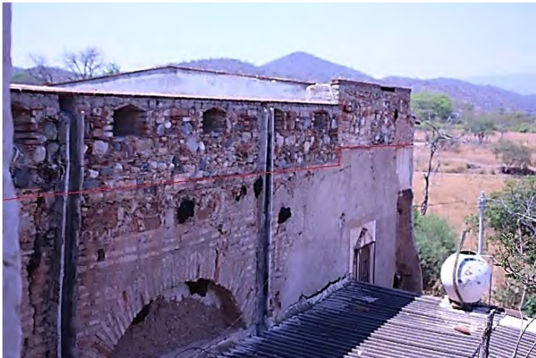
Fig. 12a. Arriba. Vista interior de la capilla de Ayotla. En rojo se señalan dos arcos cegados, aún visibles en el interior de la capilla. Fig. 12b. Abajo. Vista exterior del costado poniente de la capilla. Se observan los arcos ciegos y dos etapas constructivas en la altura (línea roja). Fotografías: Vanessa Santiago, 2022.
