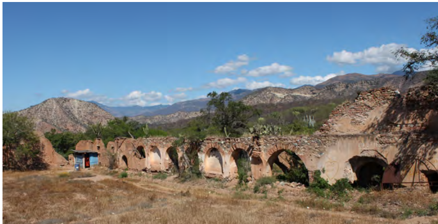
Fig. 6. Ruinas del acueducto de la hacienda de San Nicolás de Ayotla, Oaxaca. Fotografía: Gonzalo Sánchez, 2014.
