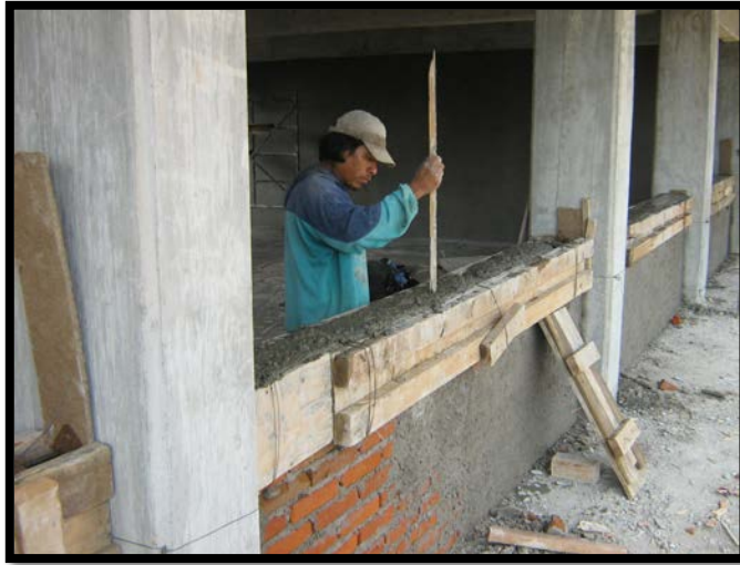
Imagen 4.36. Construcción de dalas de cerramiento en muros de tabique rojo.
