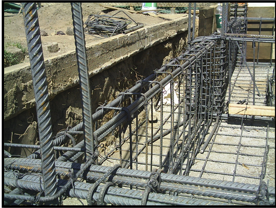
Imagen 4.1. Anclaje del acero de refuerzo en columnas en cimentación.
