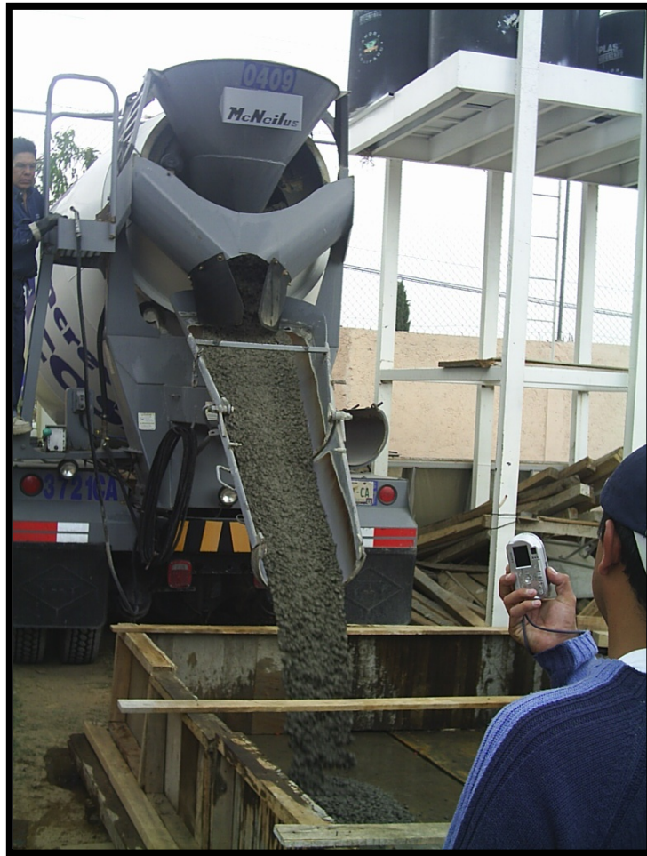
Imagen 4.8. Vaciado de concreto premezclado en artesa hecha en obra.
