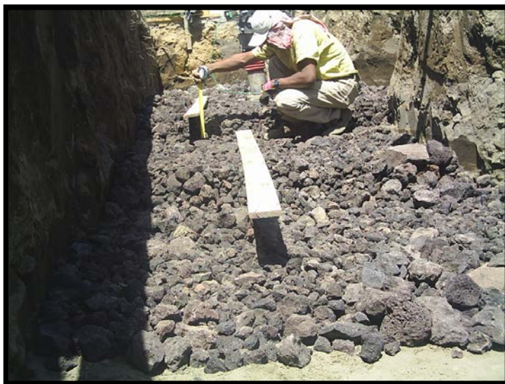
Imagen 3.2. Colocación de capas de material pétreo (balastre) en el fondo de la excavación.
