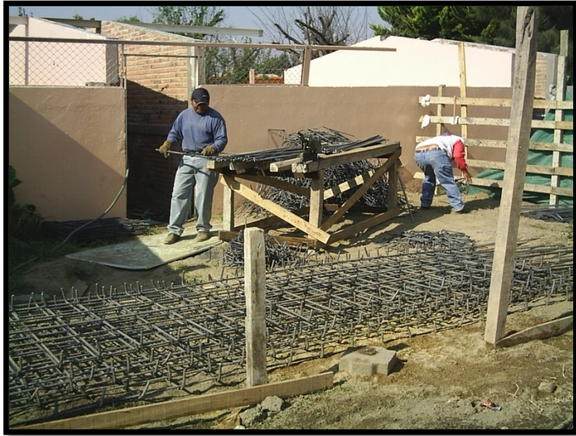
Imagen 3.11. Habilitado de acero a un costado de la construcción en proceso.
