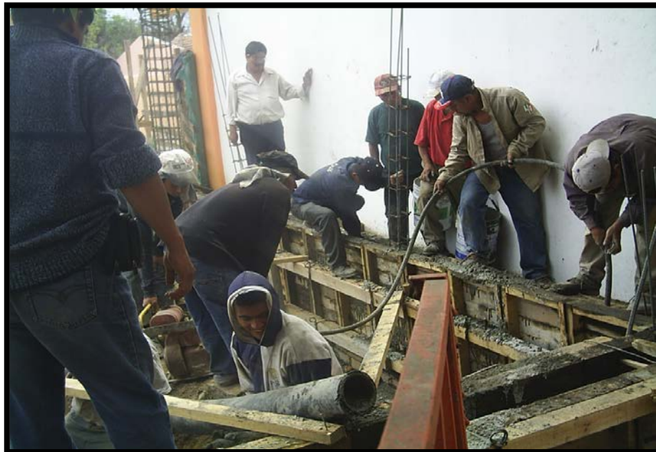
Imagen 3.17. Vibrado de concreto en la construcción de zapatas de cimentación.
