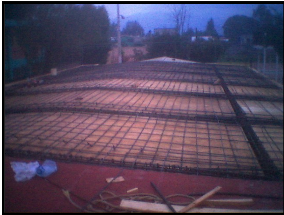
Imagen 4.26. Losa armada concluida.
