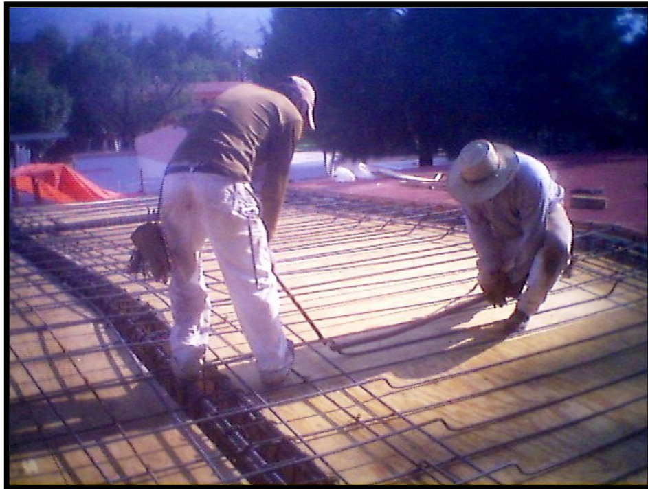
Imagen 4.25. Fabricación de columpios en el armado de la losa tapa.
