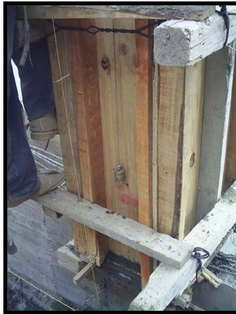
Imagen 4.6. Rectificación de la verticalidad de una columna con el apoyo de plomada.
