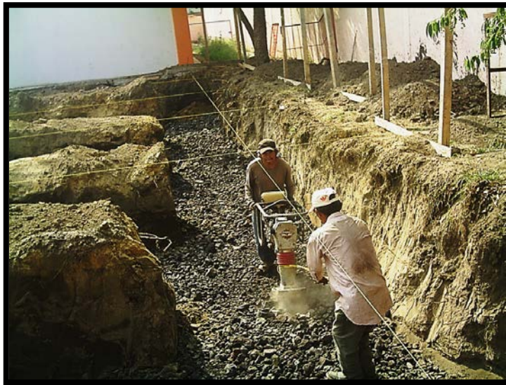
Imagen 3.4. Distribución y compactación de material pétreo (balastre) de acuerdo con los niveles del terreno.
