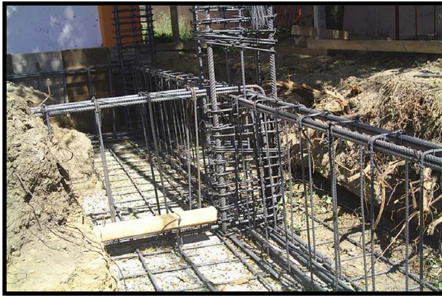
Imagen 3.13. Colocación de acero para la construcción de zapatas de cimentación y para la construcción de columnas.
