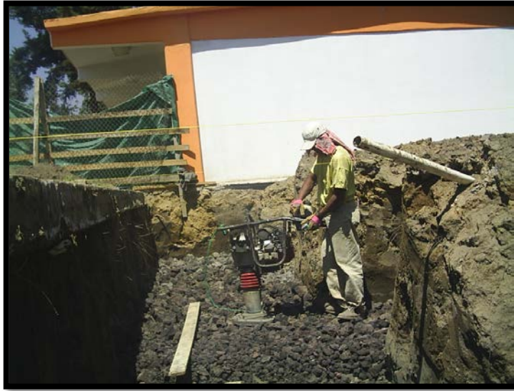
Imagen 3.3. Compactación de material pétreo (balastre) en el fondo de la excavación.
