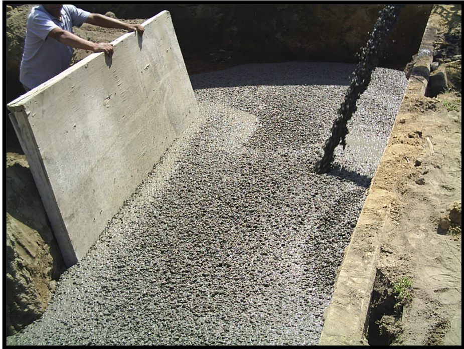
Imagen 3.9. Vaciado de concreto premezclado.
