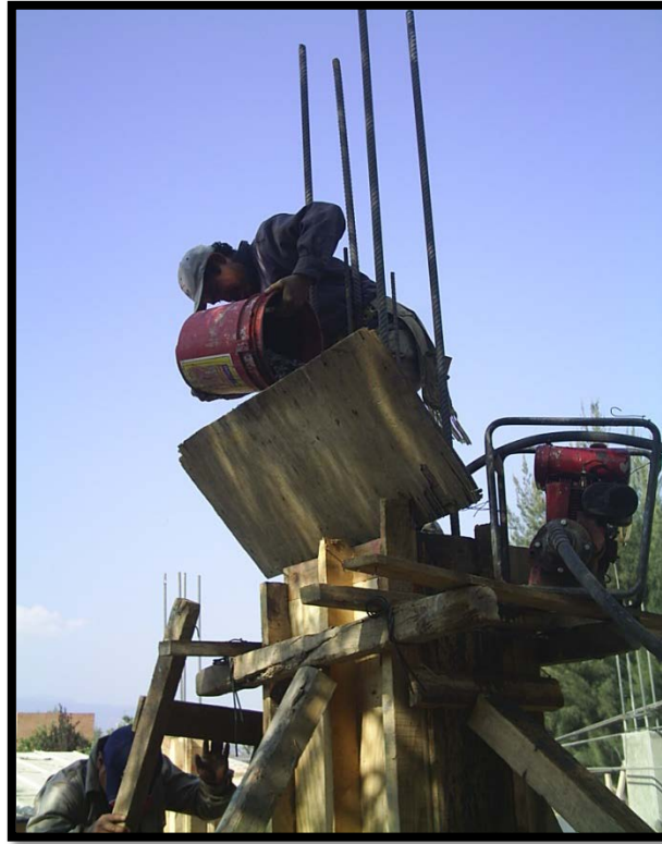
Imagen 4.9. Colado manual de columnas.
