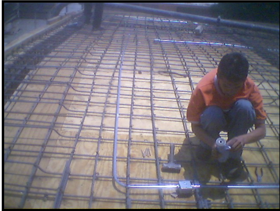
Imagen 4.27. Colocación de tubería Conduit y cajas galvanizadas para la instalación eléctrica ahogada en losa.
