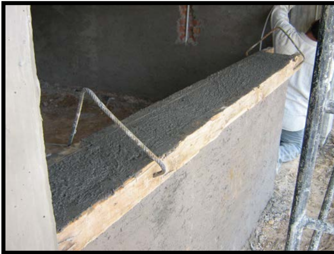
Imagen 4.37. Remate de boquillas para recibir cancelería ajustadas al nivel requerido en el proyecto.
