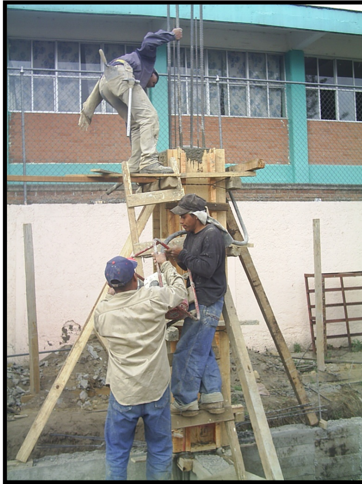
Imagen 4.11. Empleo de un vibrador eléctrico para realizar el vibrado de concreto en las columnas en construcción.
