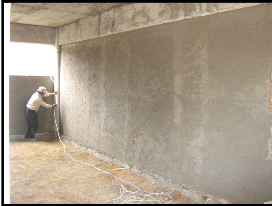
Imagen 4.40. Sacando niveles y realizando la marcación de columnas para tener un parámetro al momento de construir el piso de concreto.
