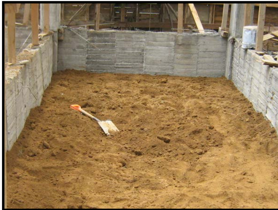
Imagen 4.3. Aspecto que presentó la superficie de la cimentación construida.
