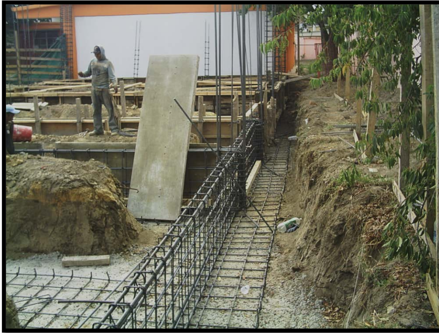
Imagen 3.14. Colocación de cimbra en zapatas de cimentación.
