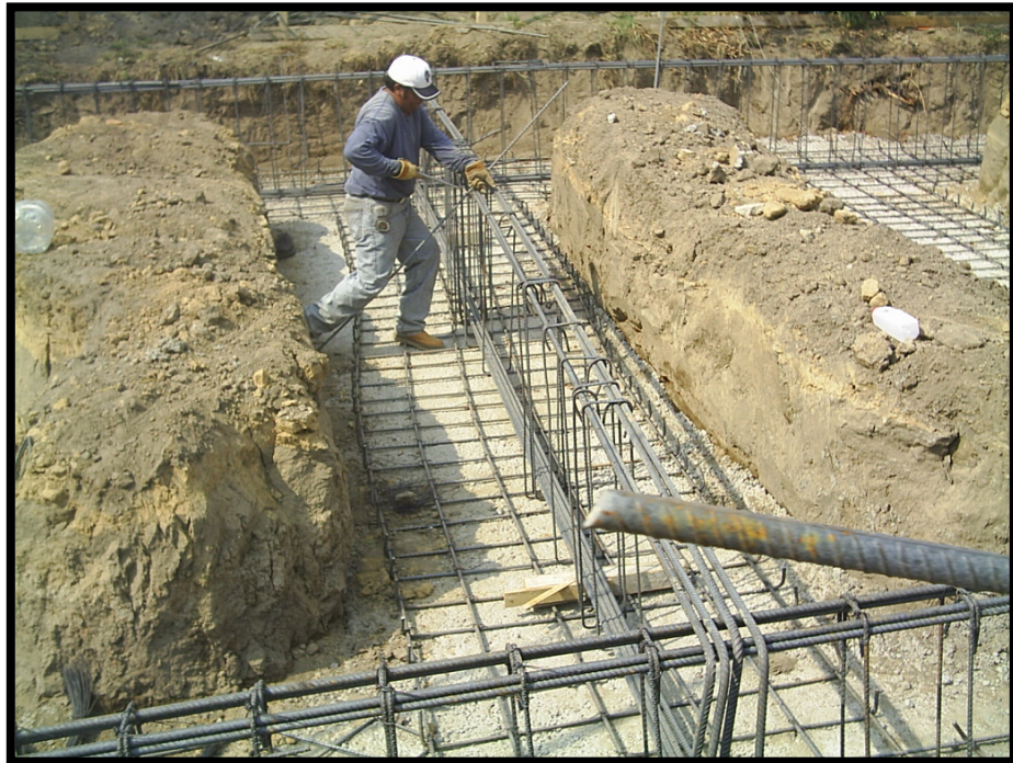
Imagen 3.12. Armado del acero de refuerzo para la construcción de zapatas.
