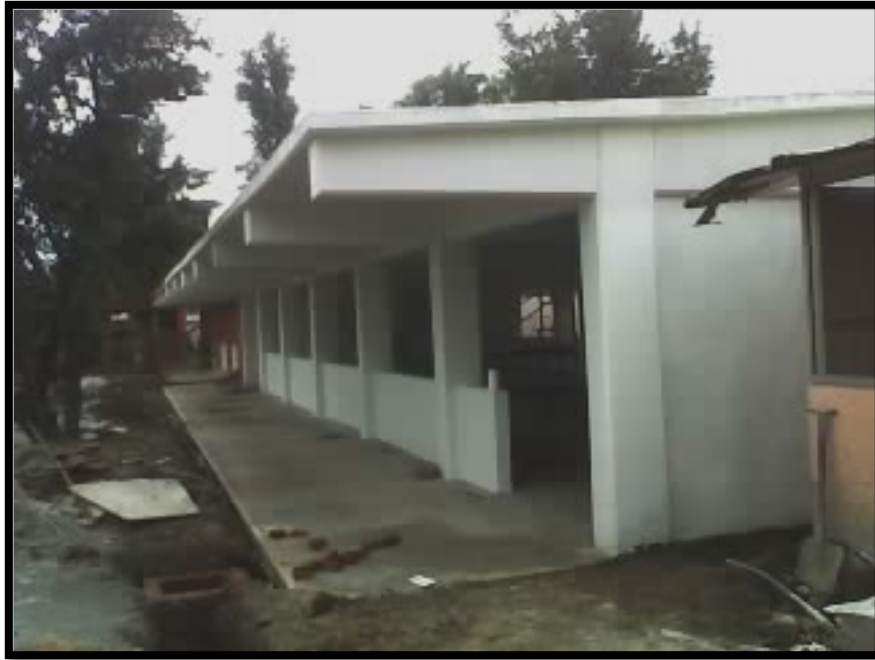
Imagen 4.45. Aplicación de sellador y una mano de pintura blanca en la superficie interior y exterior del salón.
