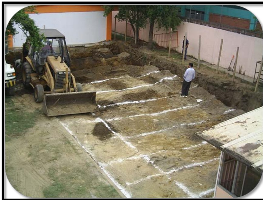
Imagen 2.12. Área total de excavación.
