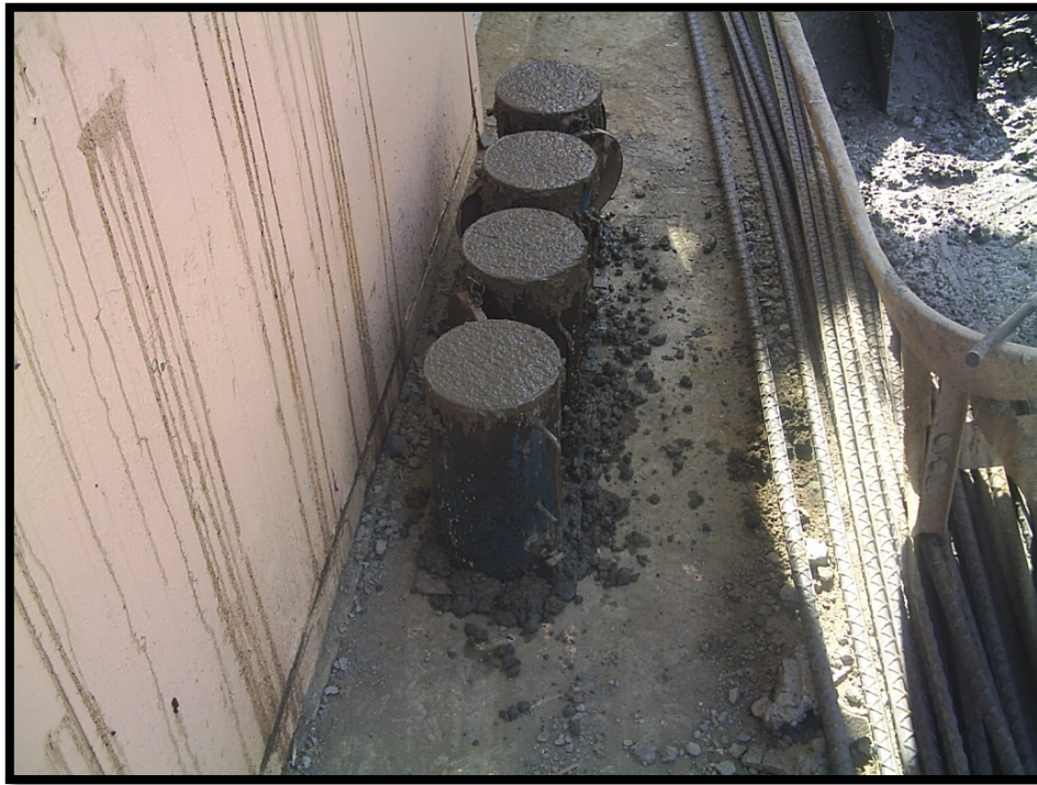
Imagen 4.31. Muestras de concreto enviadas a un laboratorio para verificar su resistencia.
