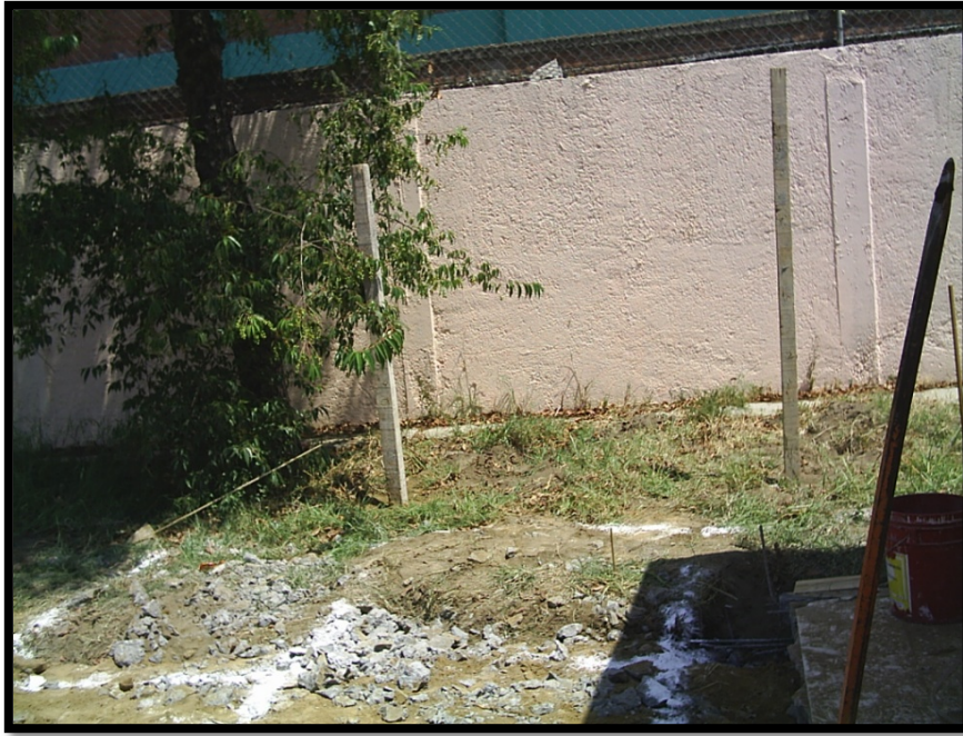
Imagen 2.11. Colocación de polines de apoyo para delimitar la profundidad de la excavación.
