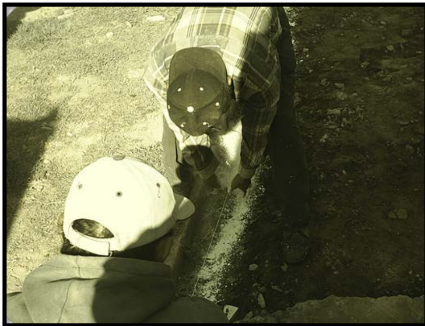
Imagen 2.9. Trazo del terreno con cal hidratada.
