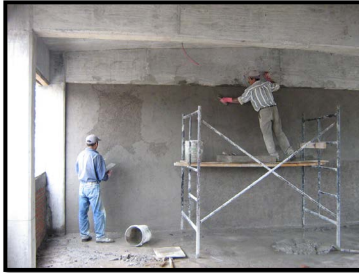
Imagen 4.38. Aplanado de medios muros en los claros largos del salón.
