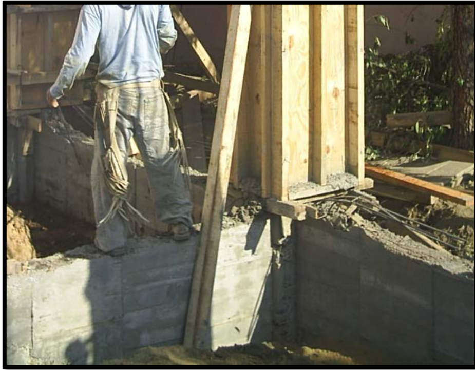
Imagen 4.7. Acero de refuerzo para la construcción de los castillos adyacentes a columnas.
