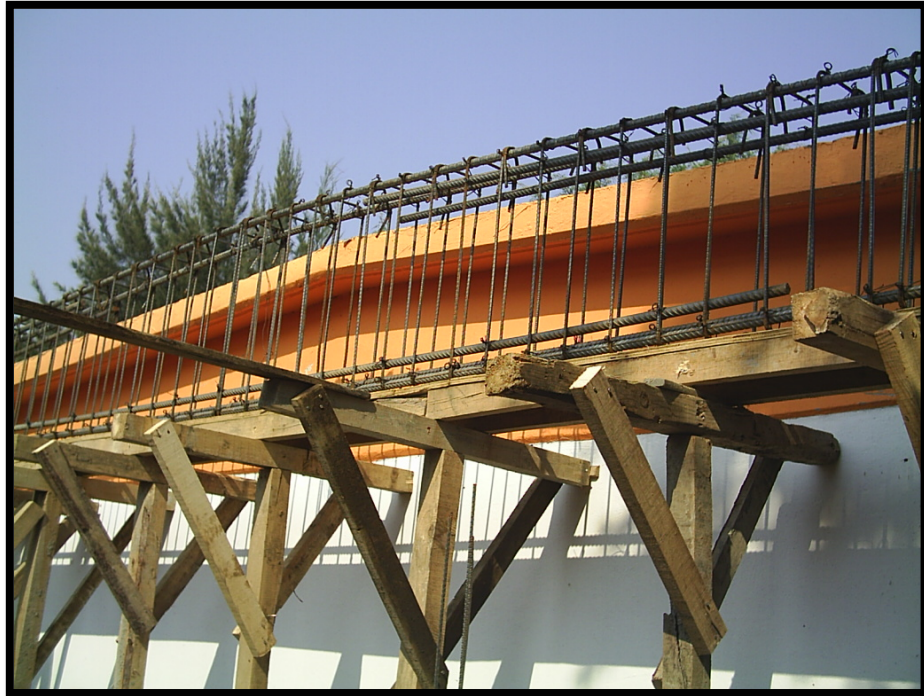
Imagen 4.19. Trabe armada colocada sobre la superficie de contacto de la cimbra.
