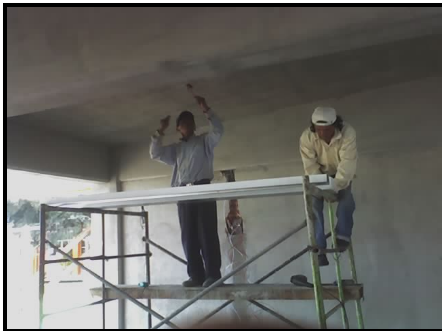
Imagen 4.46 Colocación del tablero y las luminarias en el interior del aula.
