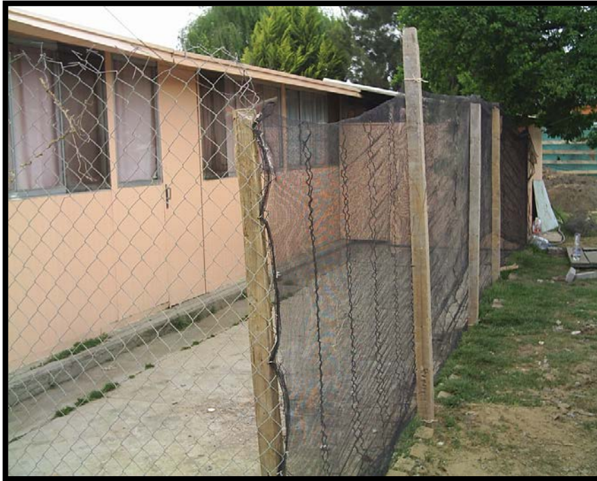
Imagen 2.1. Colocación de malla en un área de poca circulación.
