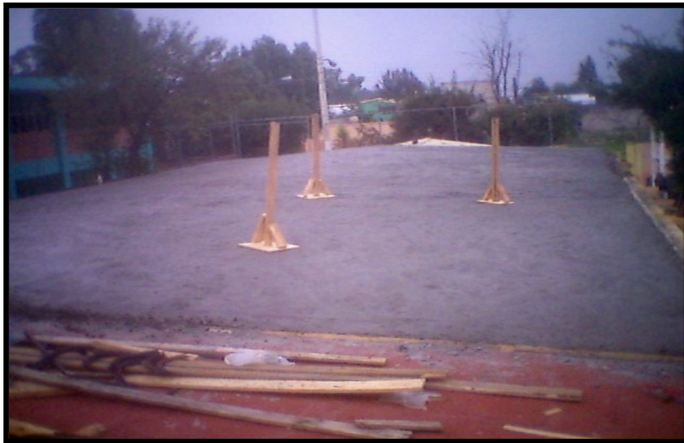
Imagen 4.30. Apisonado de la losa de concreto recién colada.
