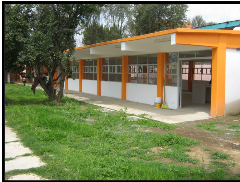
Imagen 4.53. Vista frontal de la obra terminada.
