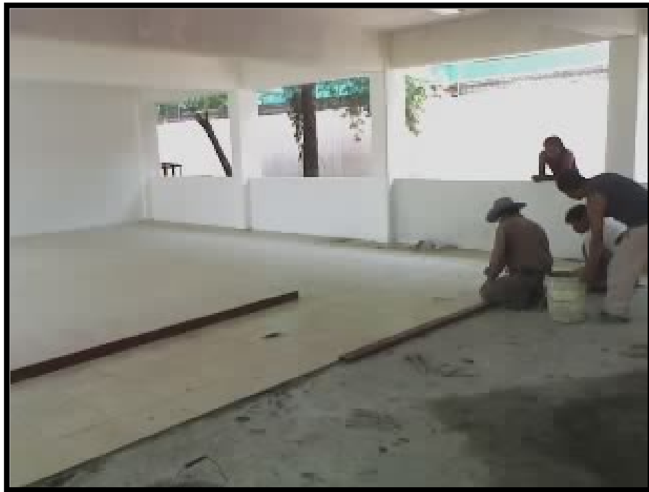
Imagen 4.48. Colocación del piso de azulejo cerámico, asentado en el piso con pasta de pegazulejo.
