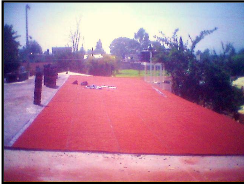
Imagen 4.51. Colocación de rollo prefabricado para impermeabilizar la azotea del aula.
