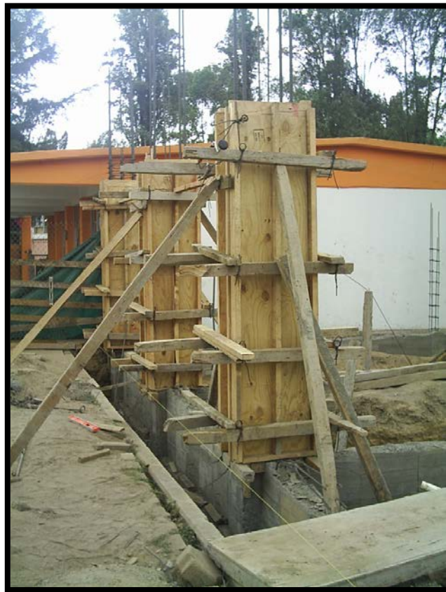
Imagen 4.5. Cimbra de columnas apuntaladas al terreno.
