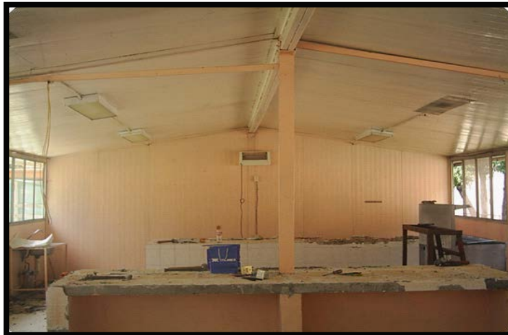
Imagen 2.4. Estructura destinada a la demolición y desmantelamiento.
