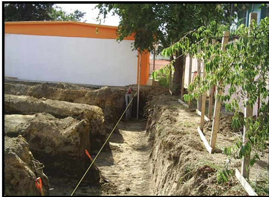
Imagen 2.15. Excavación y nivelación del terreno.
