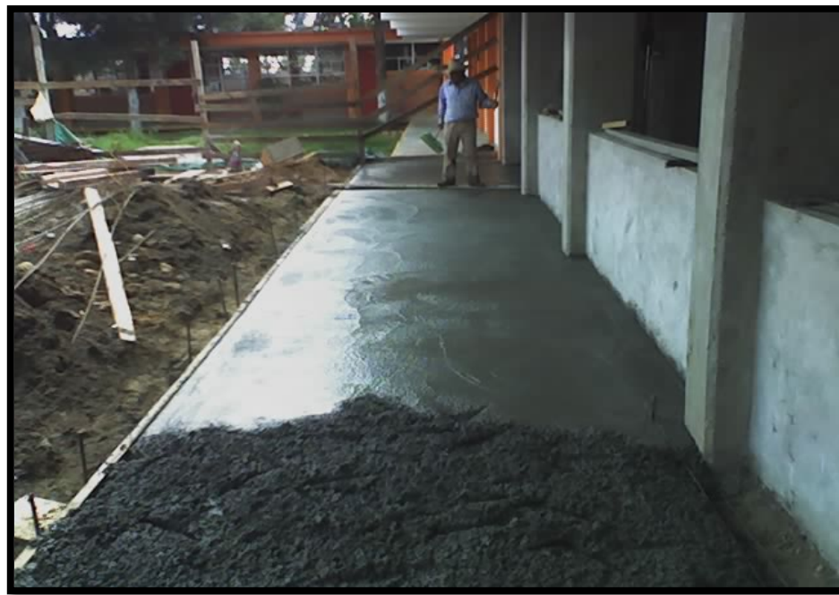
Imagen 4.43. Construcción de la banqueta en la fachada frontal del aula.
