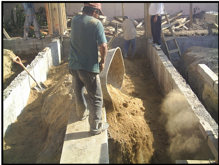
Imagen 4.12. Relleno con tepetate de la excavación adyacente a las zapatas de cimentación.
