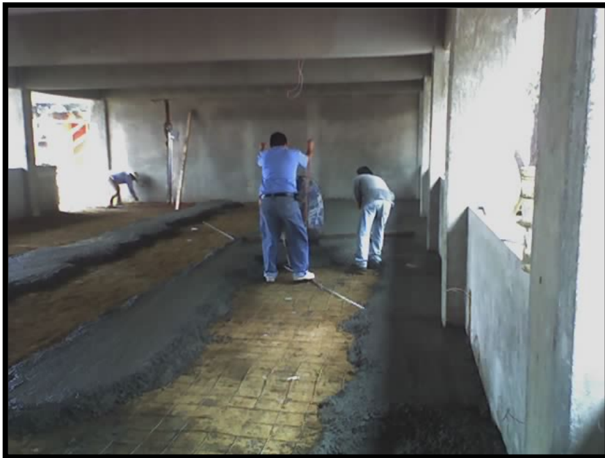
Imagen 4.42. Vaciado de concreto para la construcción de piso de concreto dentro del aula.
