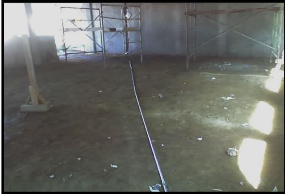
Imagen 4.39. Colocación de tubería conduit en el piso, anclada al terreno compactado.
