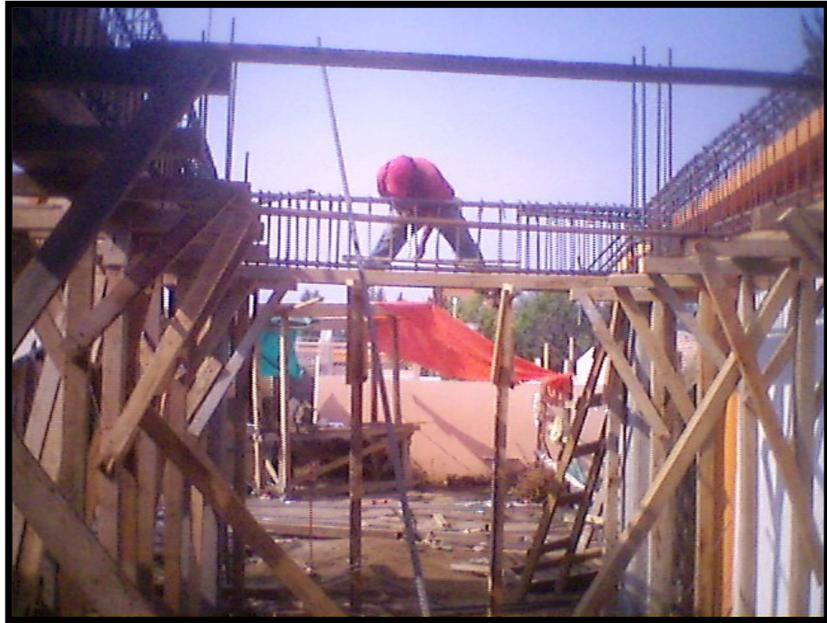
Imagen 4.17. Colocación de cimbra de soporte para traves de losa.
