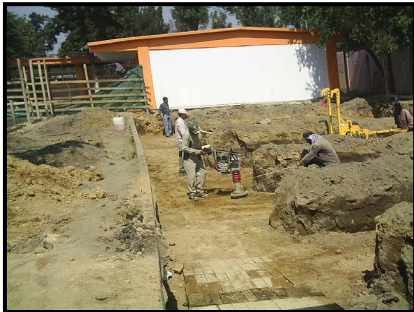
Imagen 3.6. Compactación de capa de tepetate por medio de maquinaria ligera.
