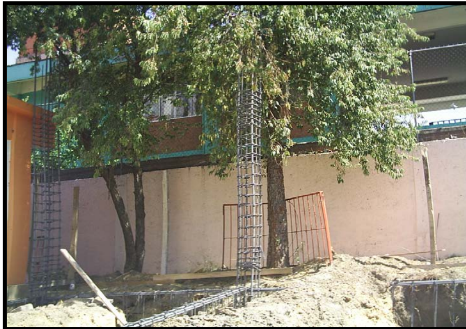
Imagen 4.2. Armado de columnas pertenecientes a la superestructura de la edificación.
