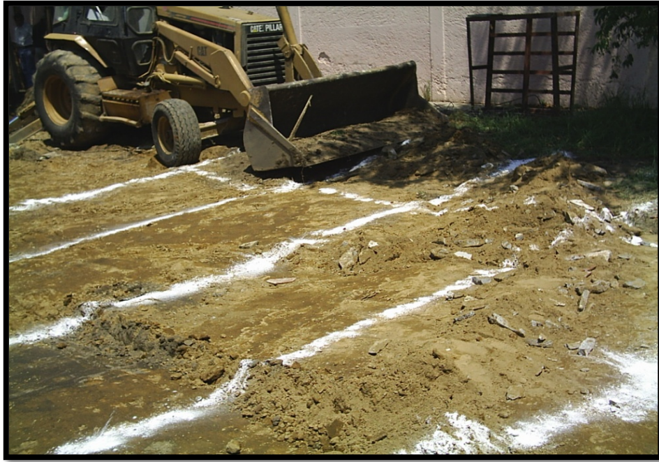
Imagen 2.10. Trazo del terreno, con áreas definidas para la excavación.
