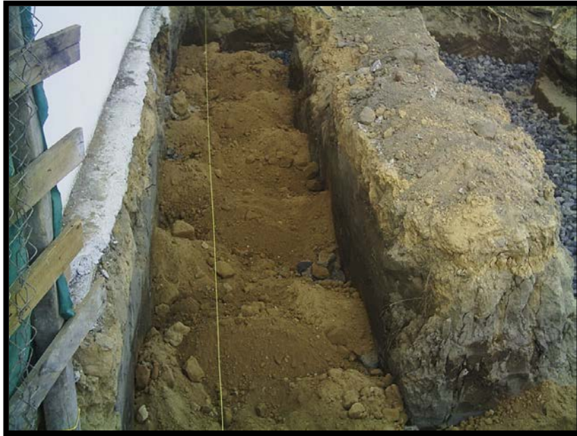
Imagen 3.5. Distribución de manera uniforme de tepetate sobre la capa de balastre. Se puede apreciar que se conservaron los hilos que sirvieron de referencia para mantener los niveles requeridos en el proyecto.
