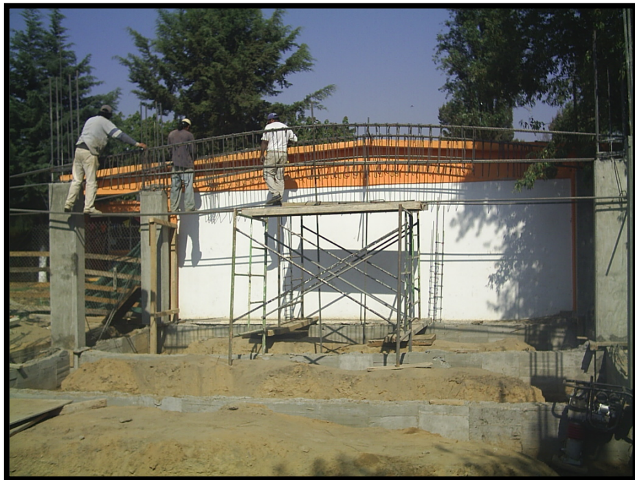
Imagen 4.16. Armado de trabes antes de la colocación de la cimbra.
