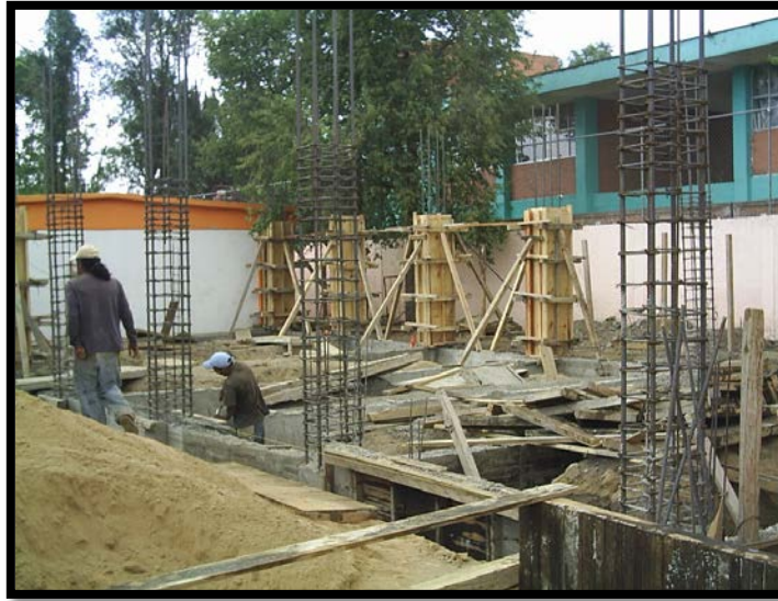
Imagen 4.4. Trabajos de armado de columnas y colocación de cimbra.
