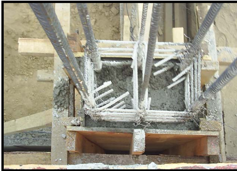
Imagen 4.10. Vaciado de concreto hasta la altura requerida para las columnas.
