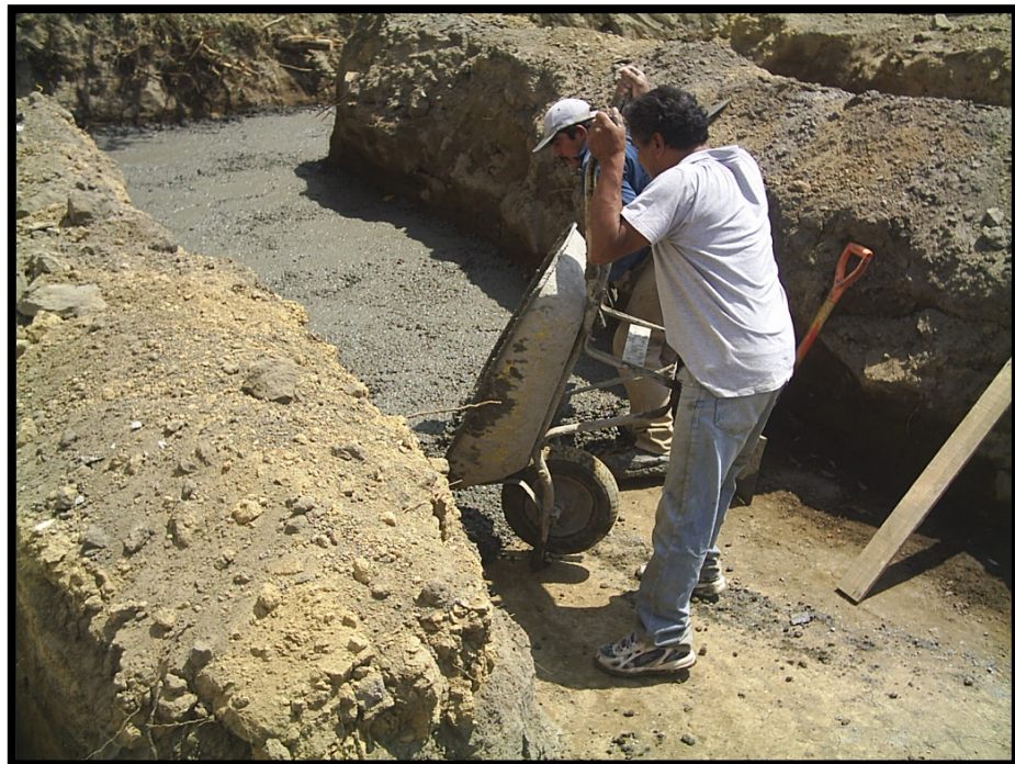
Imagen 3.10. Distribución de concreto para la construcción de la plantilla en todas las áreas donde se ubicaron las zapatas de cimentación.
