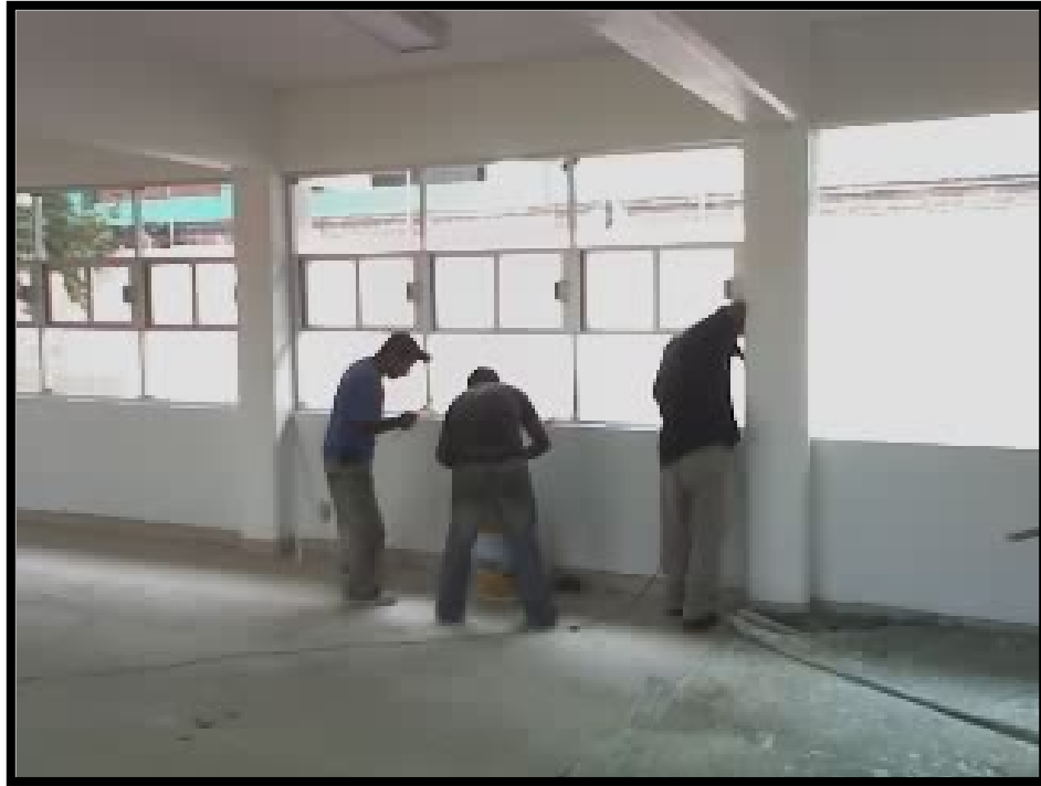
Imagen 4.49. Colocación de ventanas de aluminio en los costados del aula.
