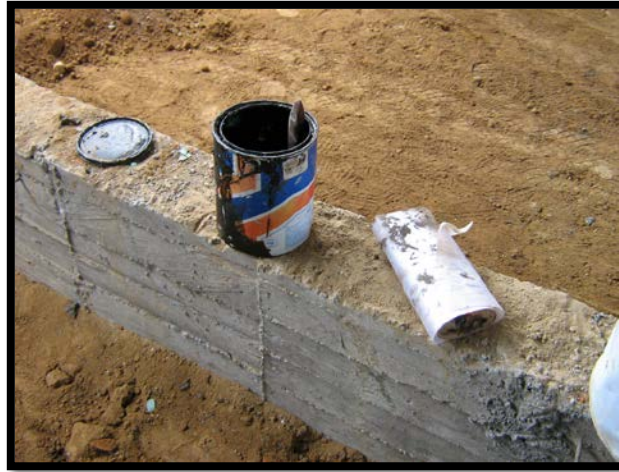
Imagen 4.32. Microlastic y película de polietileno para impermeabilizar.
