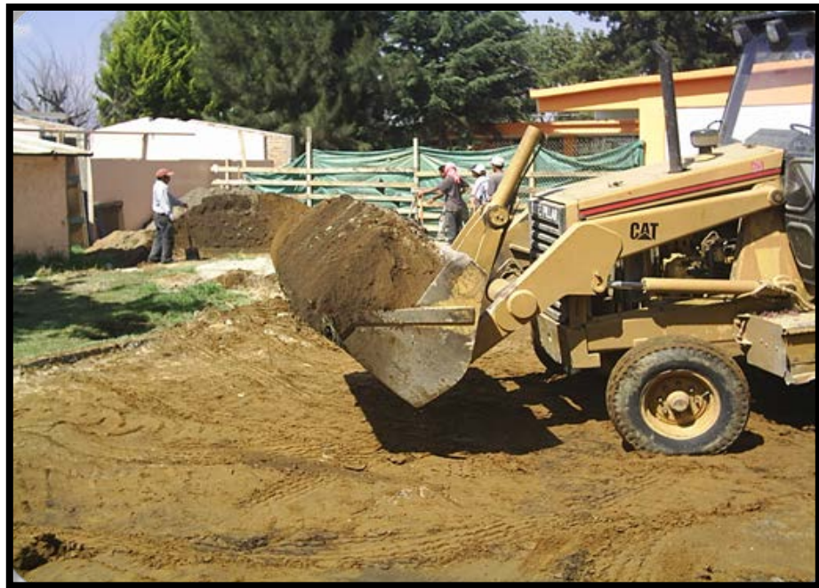
Imagen 2.7. Se observa la nivelación del terreno por medios mecánicos.
