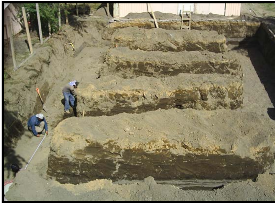
Imagen 2.16. Vista de la excavación total del área de construcción.
