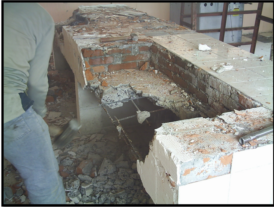
Imagen 2.3. Elementos de concreto dentro del salón del inmueble existente.
