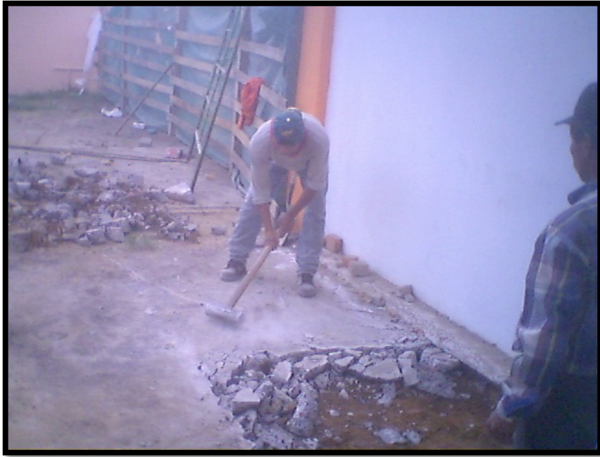
Imagen 2.5. Demolición manual de elementos de concreto.
