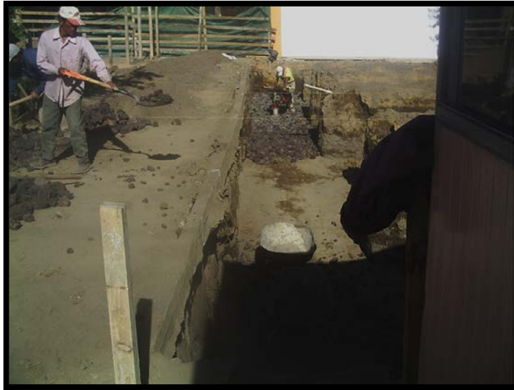
Imagen 3.1. Distribución de material pétreo (balastre) en el fondo de la excavación.
