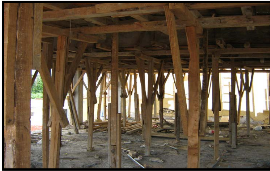
Imagen 4.24. Cimbra de soporte para la construcción de la losa colocada sobre terreno compactado.
