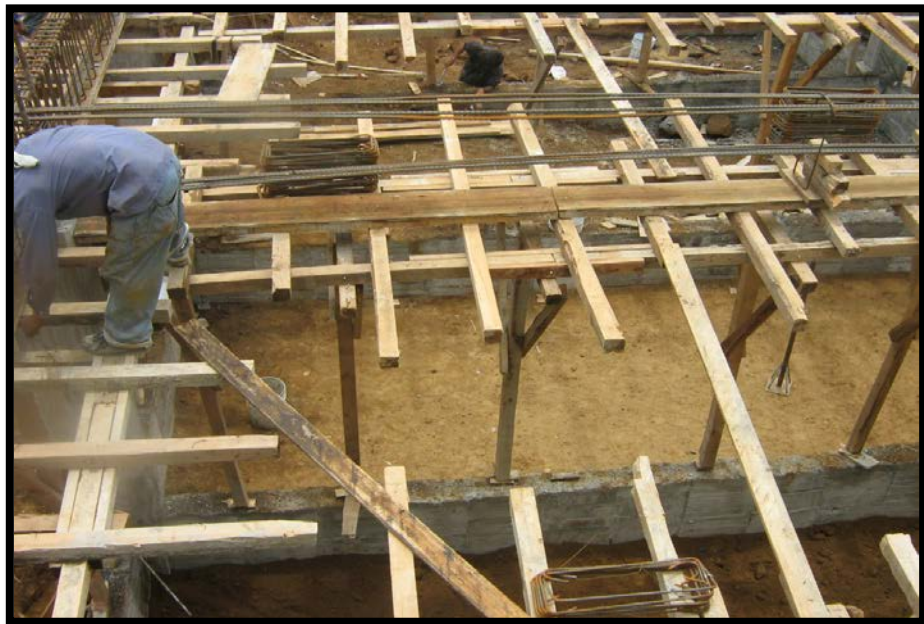
Imagen 4.18. Vista superior de la cimbra de soporte para la construcción de traves y losa de concreto.
