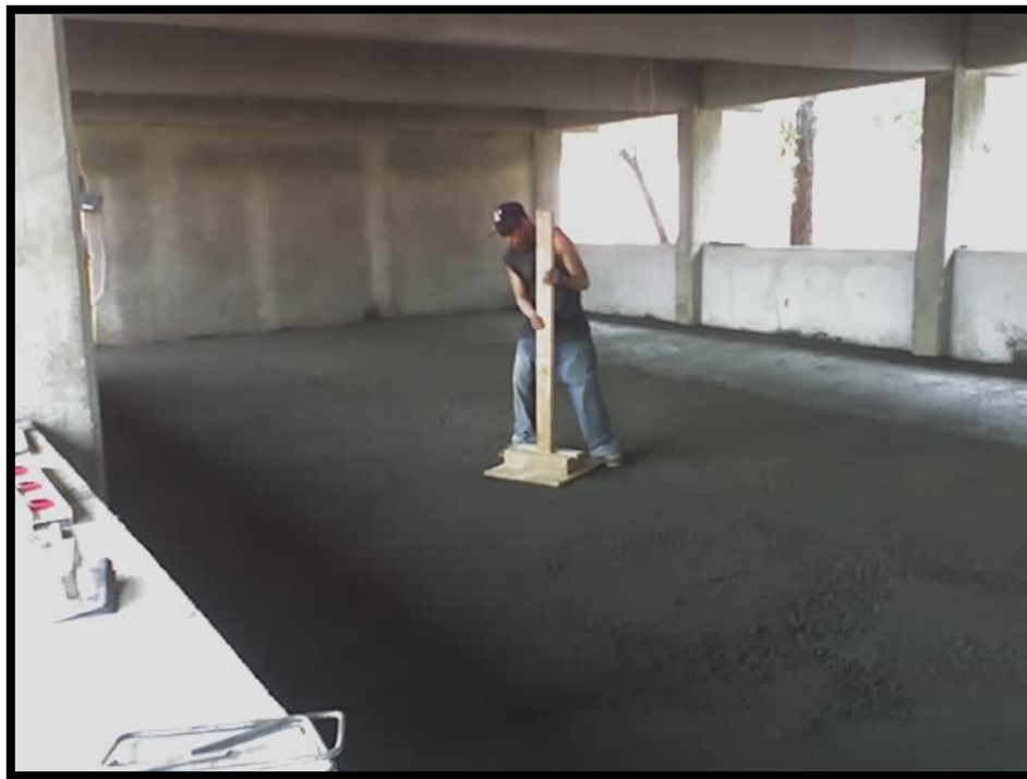
Imagen 4.44. Apisonado del piso de concreto recién construido.
