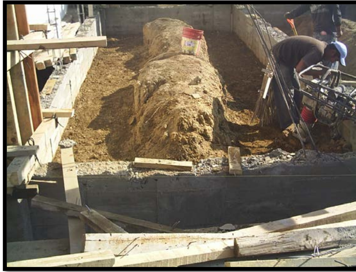
Imagen 4.13. Compactación por capas del relleno con tepetate.
