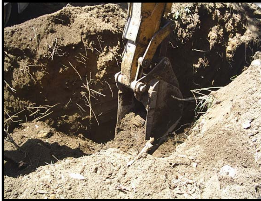
Imagen 2.13. Excavación del terreno con retroexcavadora.
