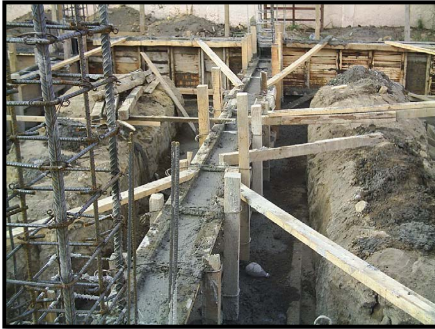
Imagen 3.18. Zapatas de cimentación al término del colado.
