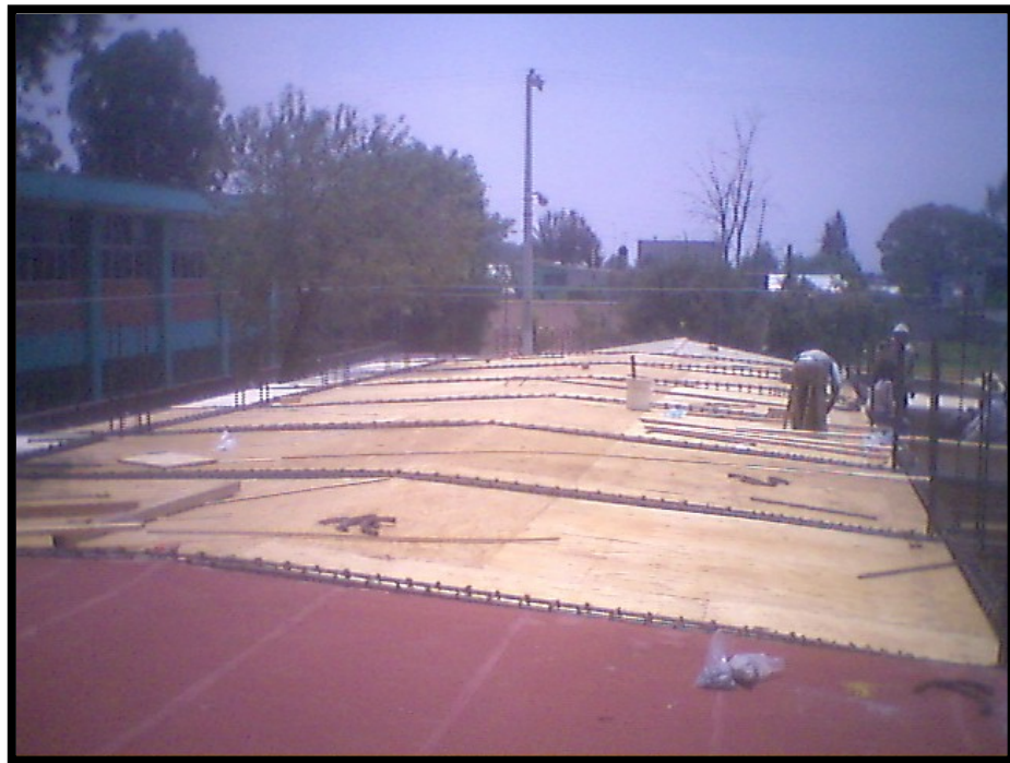
Imagen 4.23. Colocación de cimbra de contacto para la construcción de la losa.
