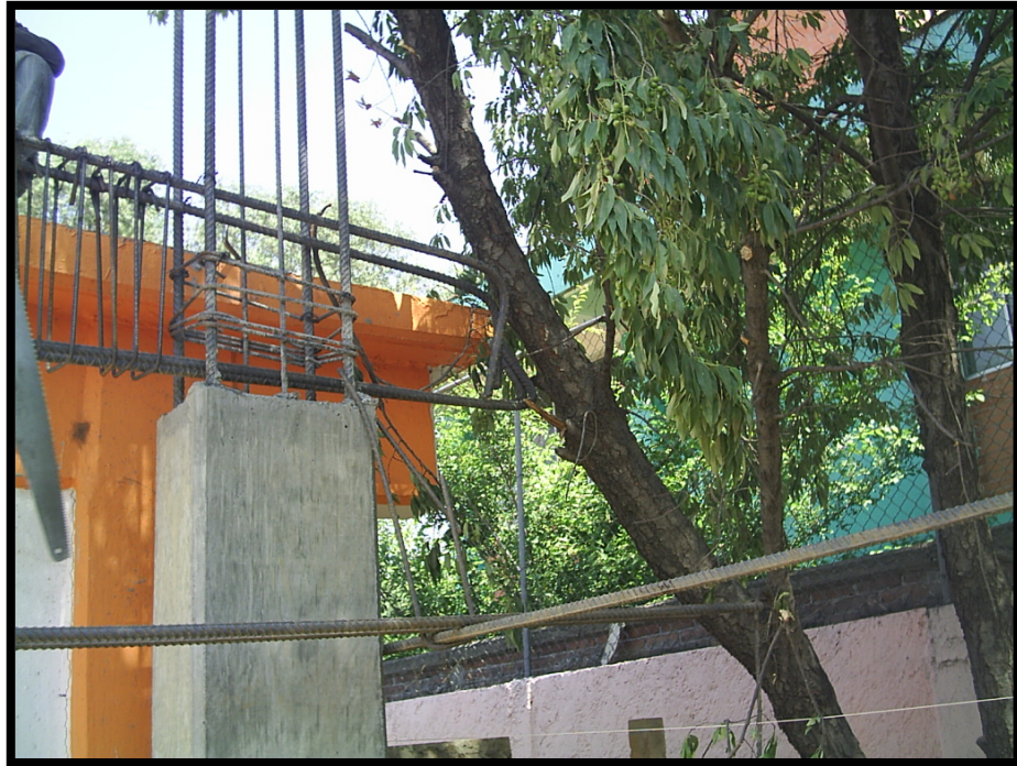
Imagen 4.15. Anclaje de acero en entronque de columnas y trabes.
