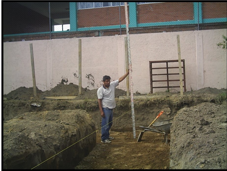
Imagen 3.7. Rectificación de niveles de proyecto con el apoyo de hilos.
