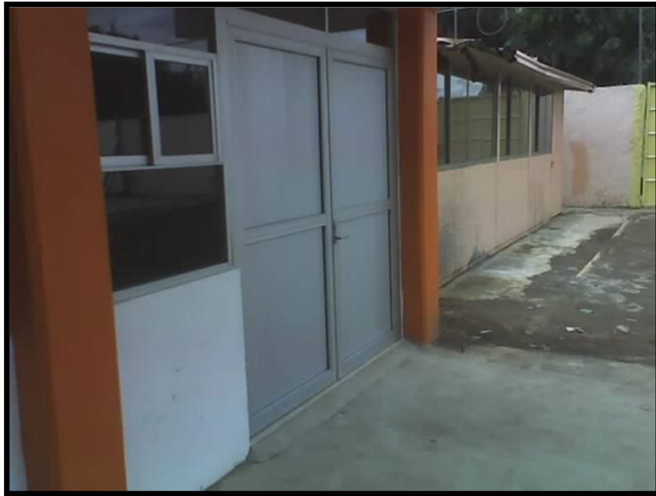
Imagen 4.50. Colocación de puertas de aluminio en la fachada frontal del aula.
