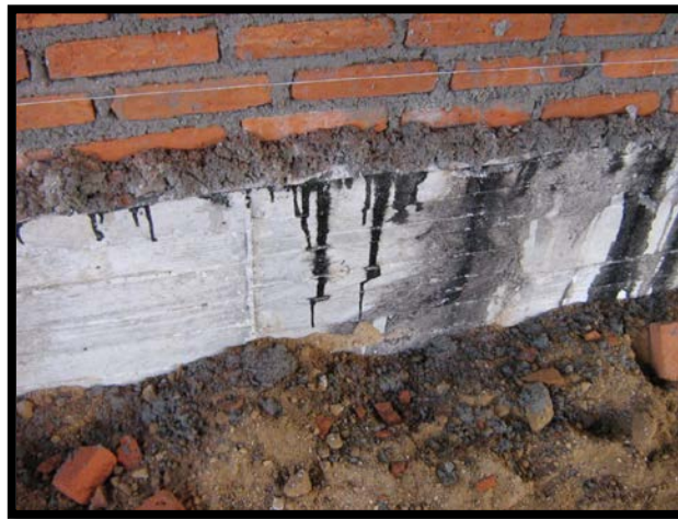
Imagen 4.33. Impermeabilización de desplante de los muros de tabique rojo.
