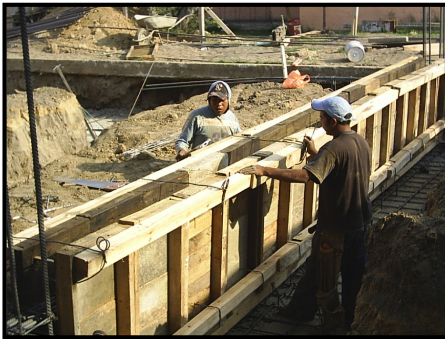
Imagen 3.15. Colocación de cimbra, simultáneamente con el armado de acero de refuerzo, en las zapatas de cimentación.
