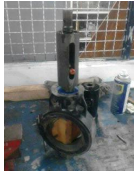
Imagen 95 – Se observa a una de las válvulas en la etapa de mantenimiento.
