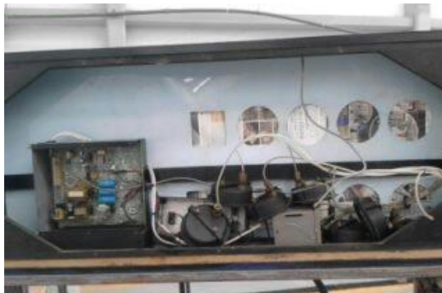
Imagen 44 – Vista posterior del panel frontal y sus elementos desmontados en el panel.
