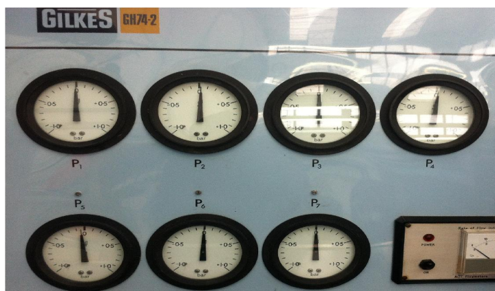
Imagen 6 – Se observan de forma física los manómetros en el panel principal.
