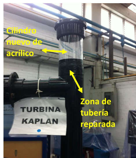
Imagen 96 – Se aprecian las condiciones finales de ambos trabajos.
