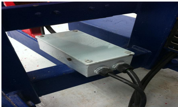
Imagen 19 – Se muestra el módulo de interconexión rehabilitado.
