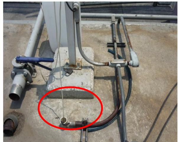
**Tubería dañada con corrosión**
