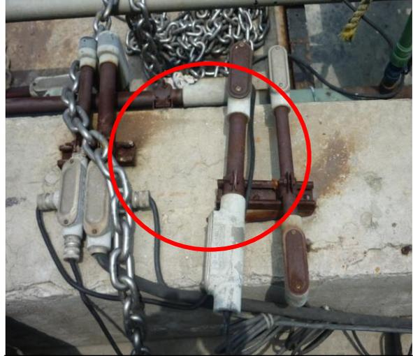
**Alto grado de corrosión en tubería, condulet y abrazaderas**
