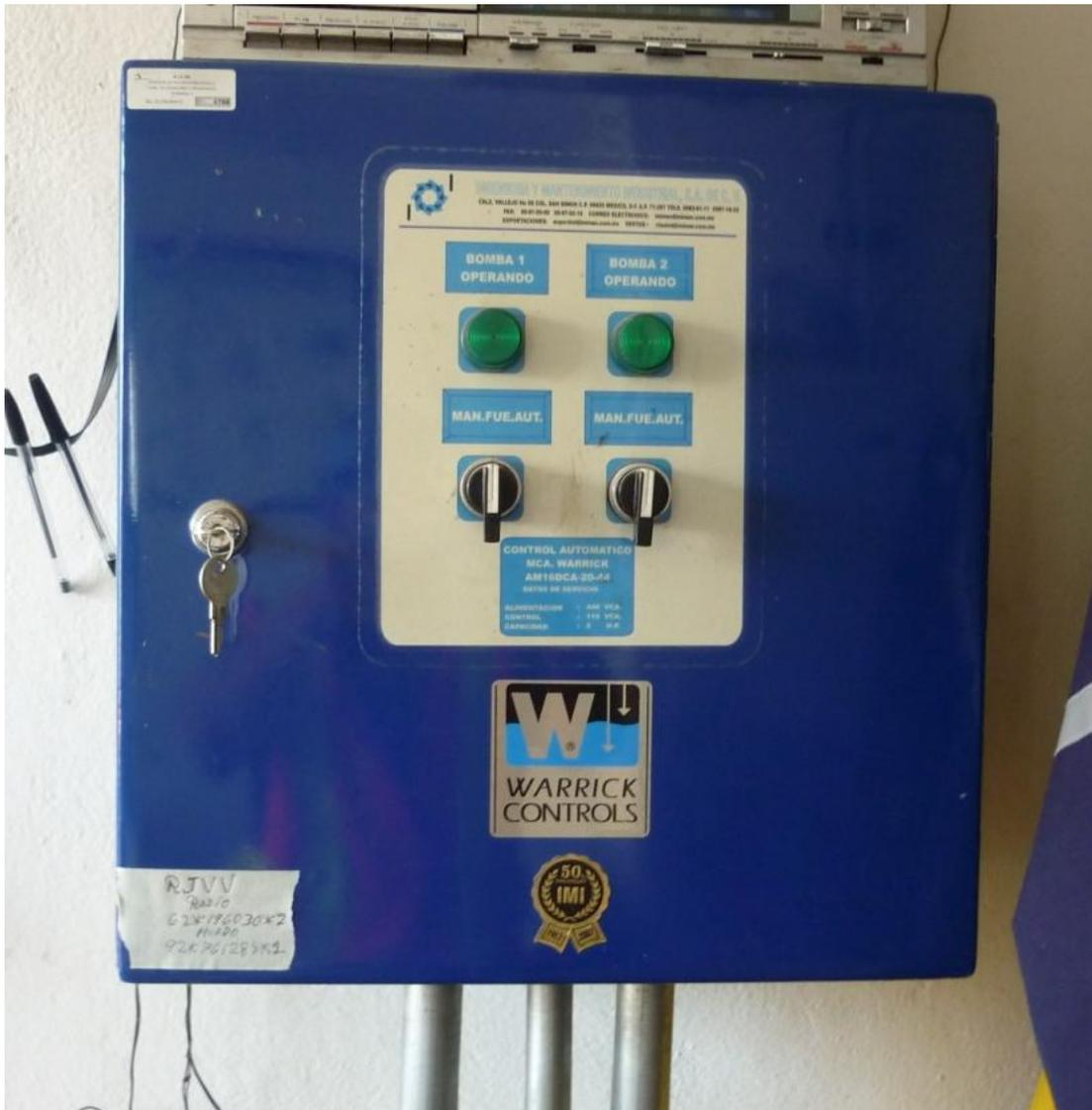
Tablero diseñado para secuenciar 2 bombas de 2 Hp. cada uno.
