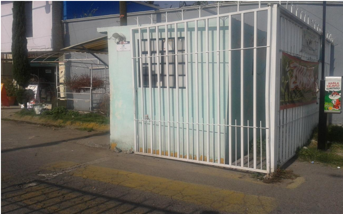
Caseta de vigilancia en desuso en avenida Paloma. Foto: Ricardo Tang, 21 de septiembre del 2013.
