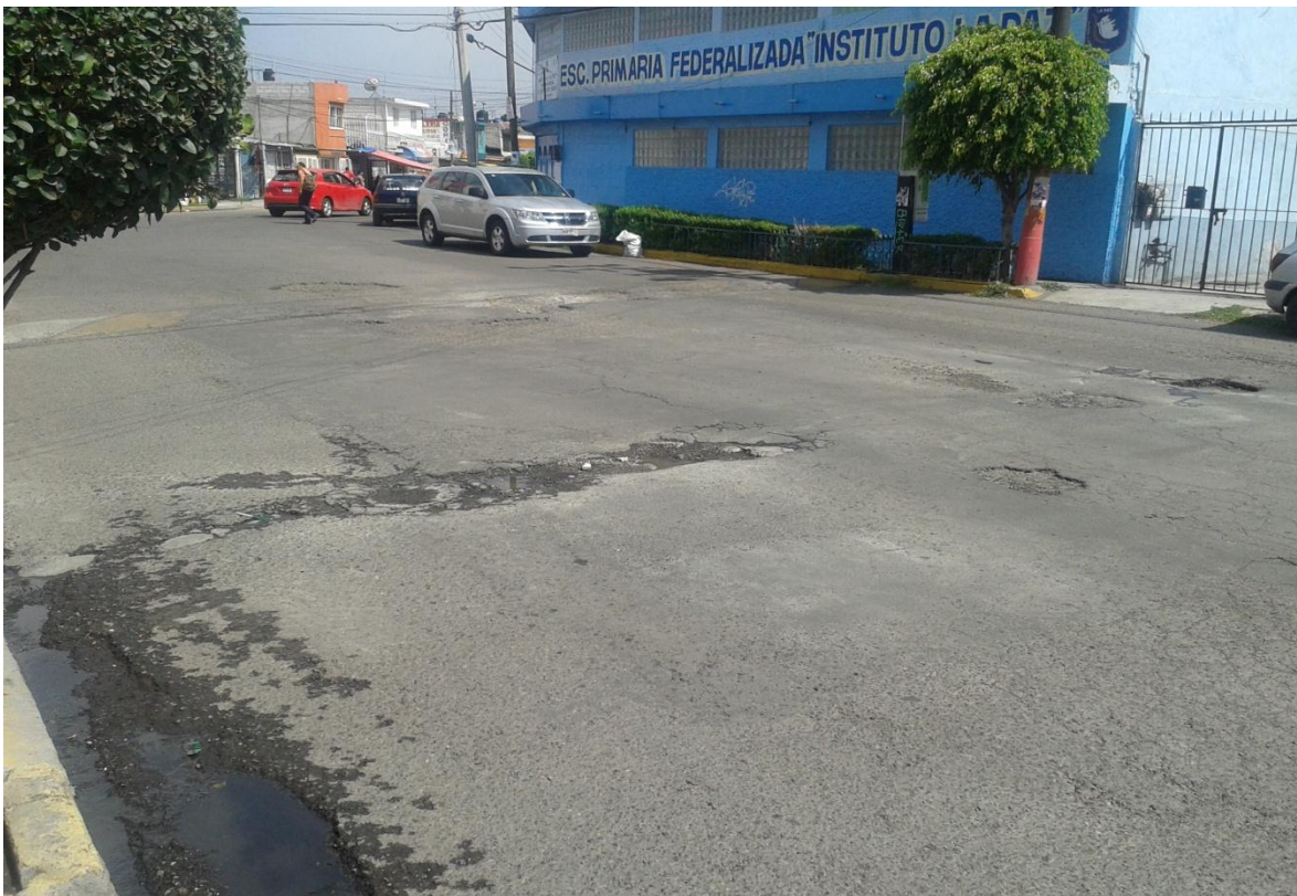
Problemas de baches en la avenida Cóndor. Foto: Ricardo Tang, 27 de mayo del 2013.
