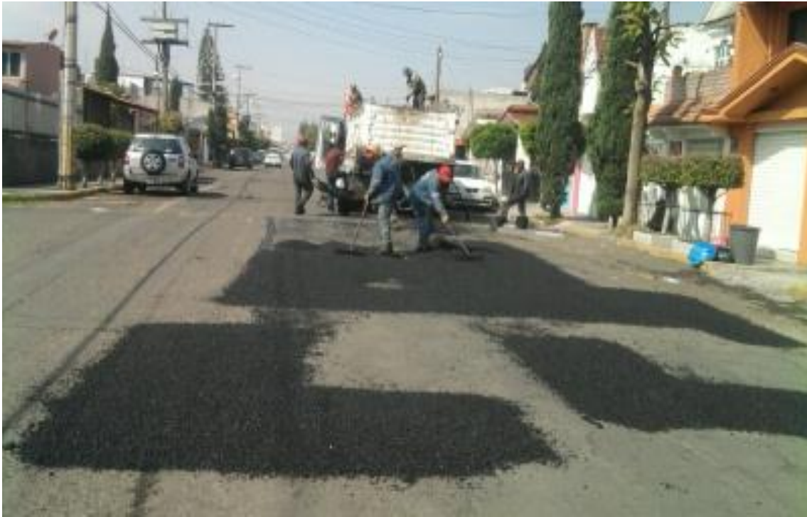
Mantenimiento a la avenida Cisne. Foto: Ricardo Tang, 26 de septiembre del 2013.
