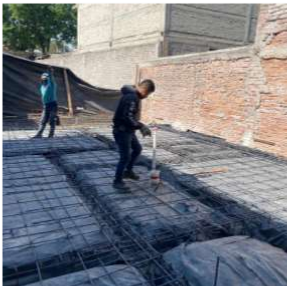
Habilitado y armado de parrilla de losa de cimentación.
