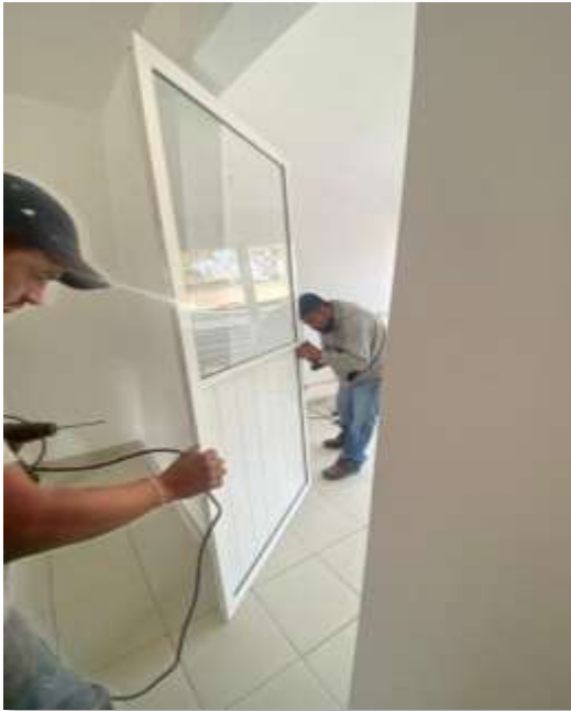
Colocación puerta de patio de servicio de aluminio blanco.
