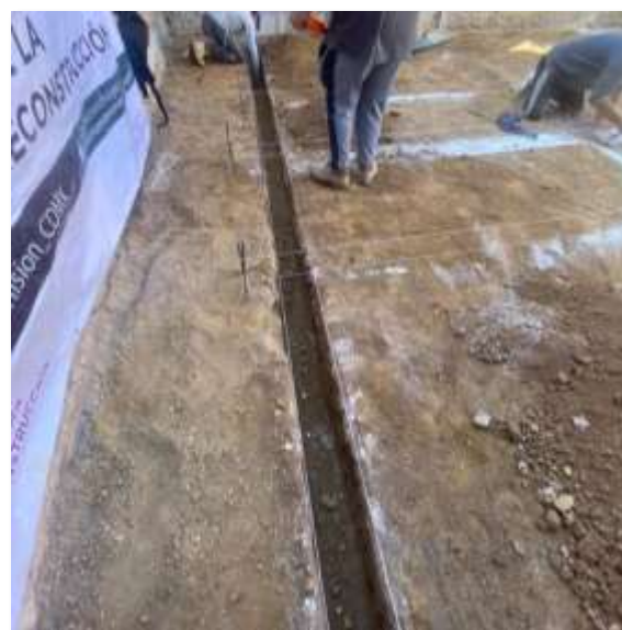
Excavación de contratrabes perimetrales e intermedias.
