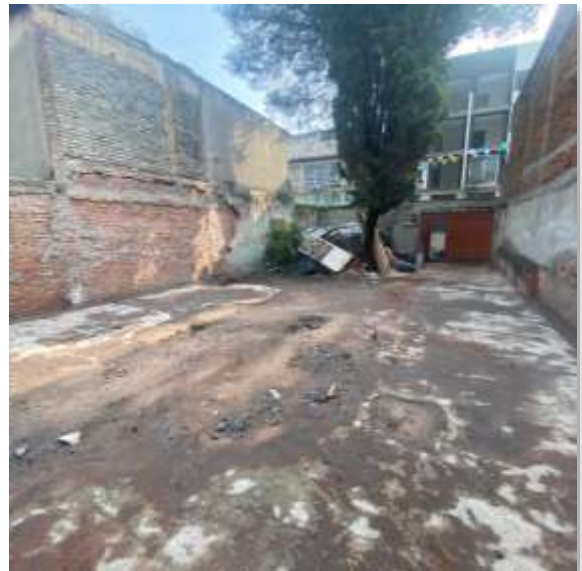
Predio limpio parte frontal.
