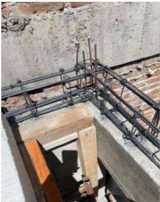
Refuerzo en uniones "L" y "T" de 80 cm largo con varilla de 3/8".
