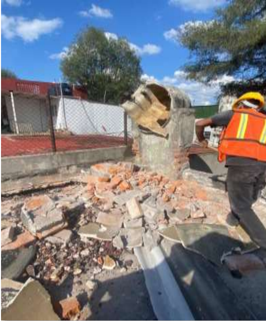
Demolición de entortado y pretil en área para dividir muro de colindancia.
