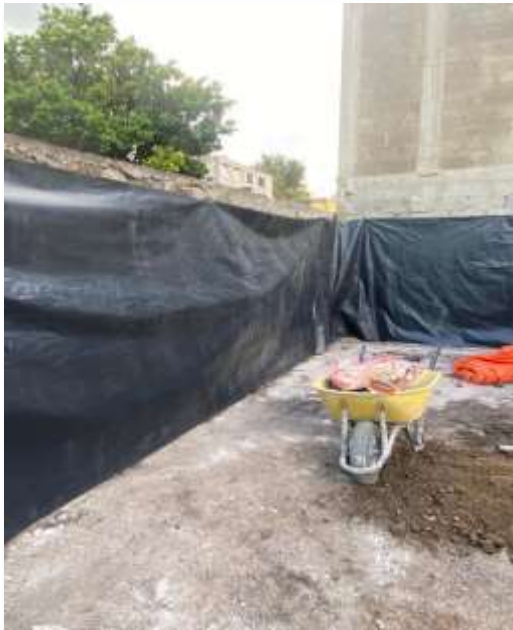
Colocación de tapial para protección a colindancias.
