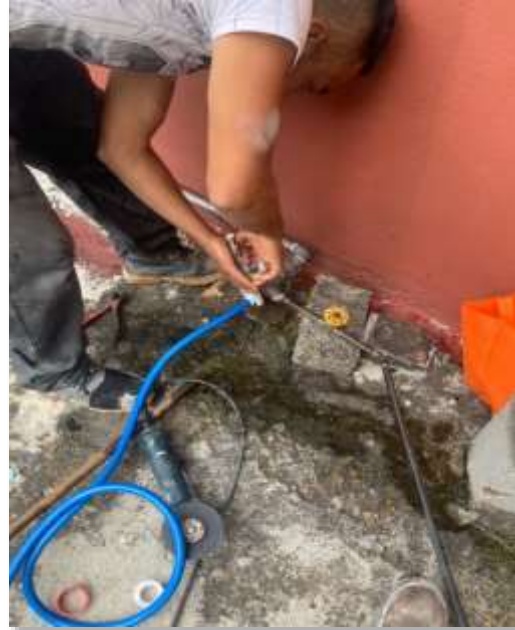
Cancelación instalación hidráulica.
