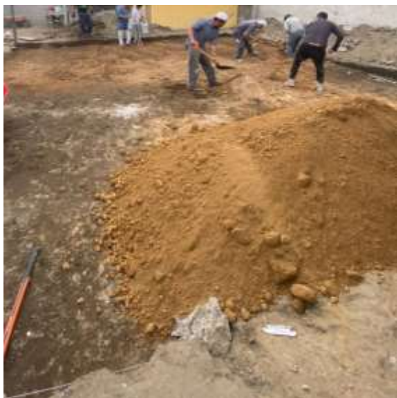
Colocación de tepetate para plataforma.
