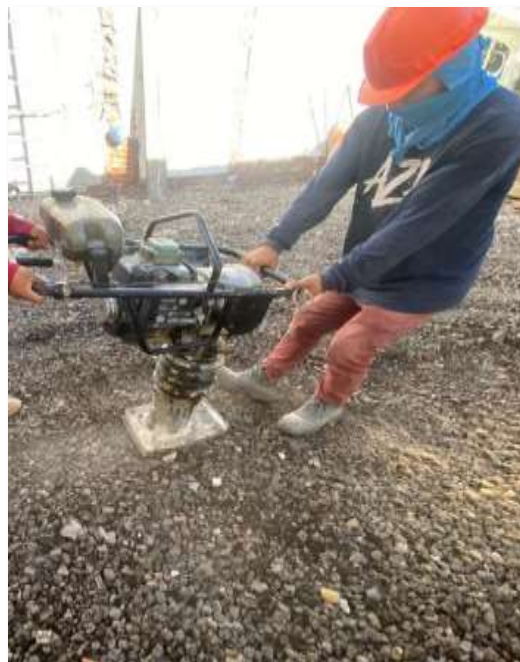
Compactación de tezontle con bailarina.
