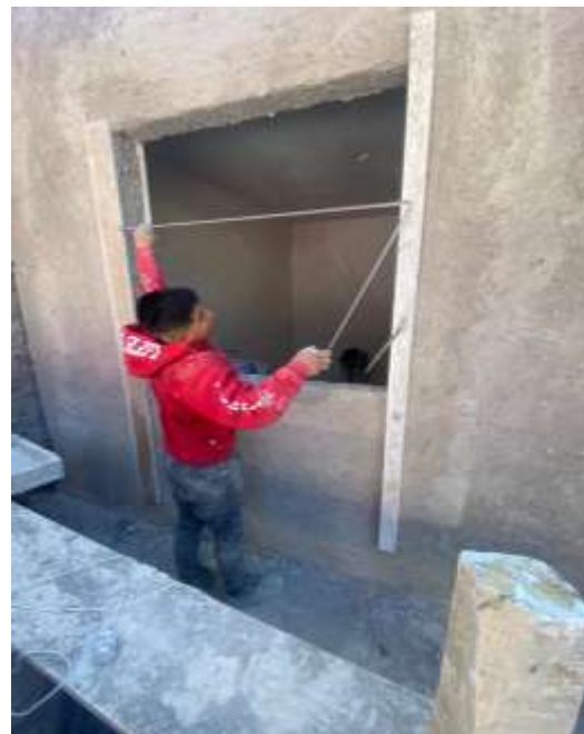
Emboquillado con reglas y grapas de varilla.
