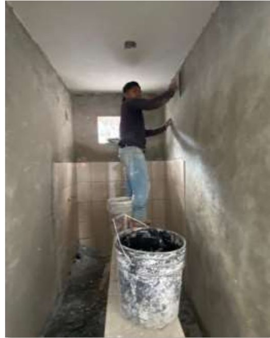
Aplanados de muros en baño.
