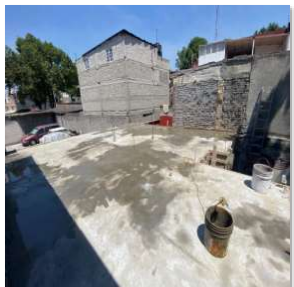
Curado de losa con agua 3 veces al día por 28 días.
