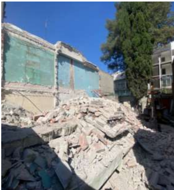
Demolición de toda la estructura desligada del muro colindante.
