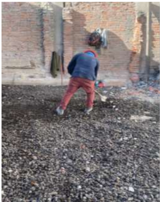
Colocación de tezontle para plataforma.
