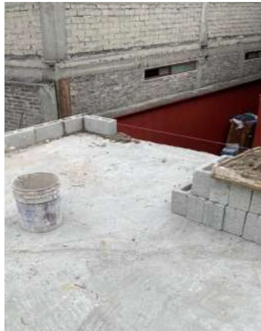
Pretil de una hilada de block hueco 12-20-40.
