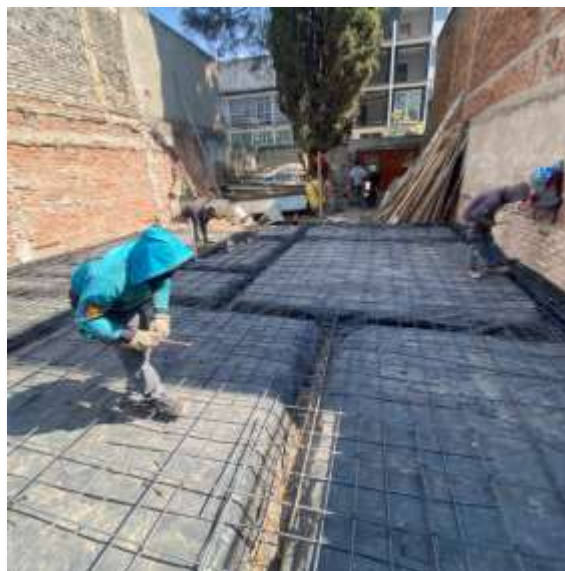
Habilitado y armado de bastones, 1/4" de claro a cubrir.
