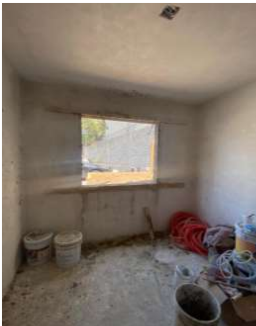
Emboquillado de ventanas.
