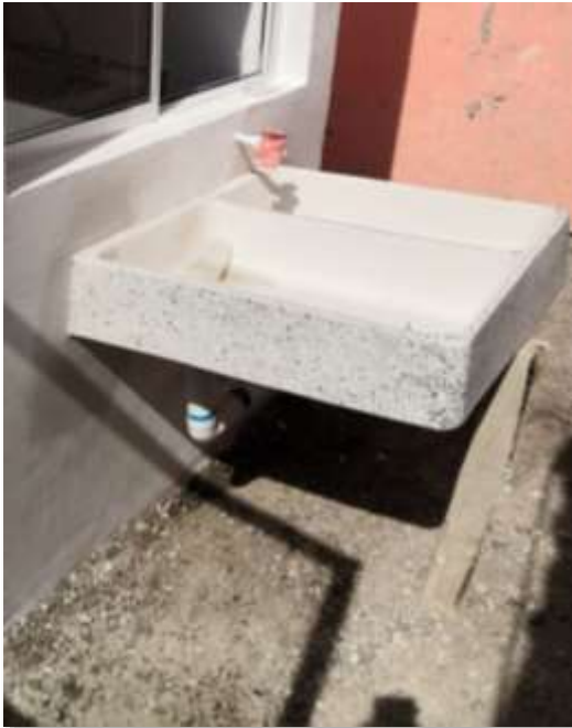
Colocación de lavadero 60 cm x 60 cm.
