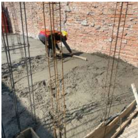
Nivelación de losa de cimentación.
