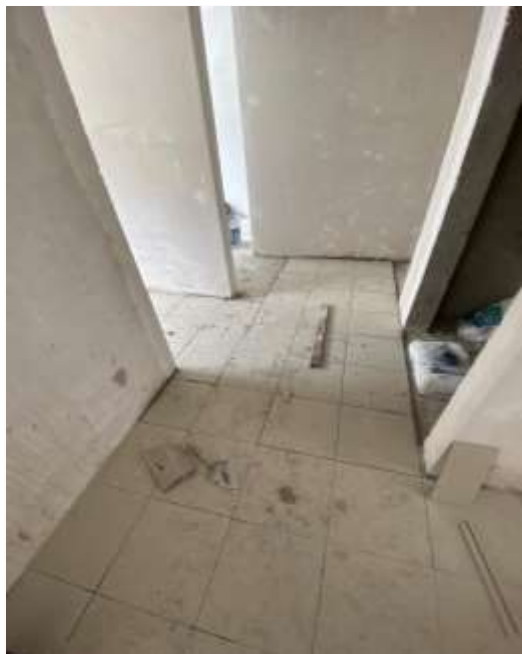
Colocación de loseta 33 x 33 cm en piso.
