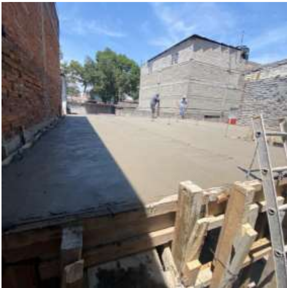
Losa terminada lista para pisonear y curar para evitar fisuras.
