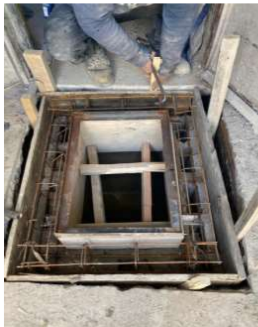
Fabricación de registro sanitario.
