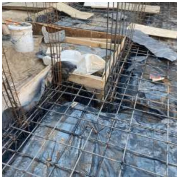
Anclaje de castillos armex 12-12-4 a losa de cimentación.
