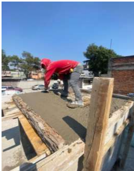
Colado placa de concreto para tinaco de 10 cm de espesor.
