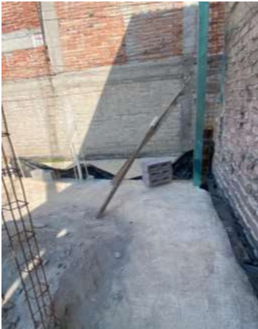
Regla a plomo para levantamiento de muros.
