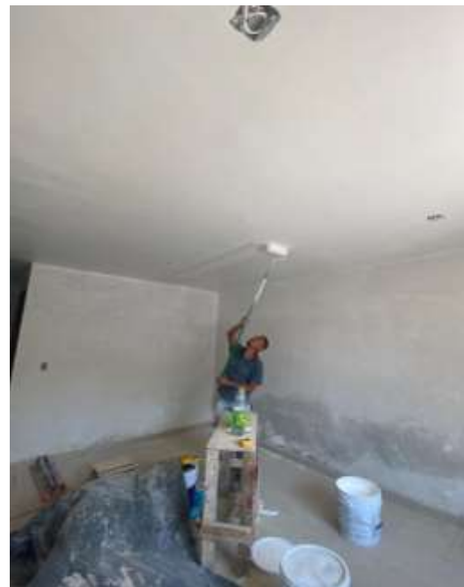
Aplicación de pintura vinílica en plafones.
