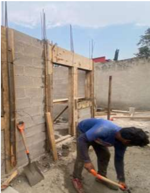
Cimbra y colado de castillos y cadena de cerramiento en puertas y ventanas.
