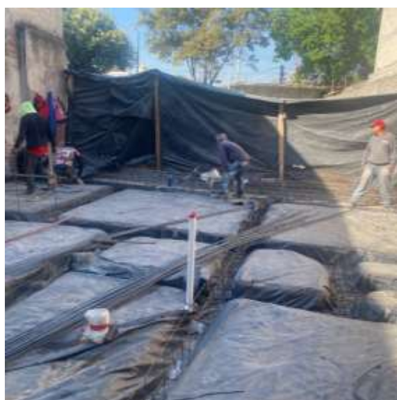
Habilitado de contratrabes intermedias y perimetrales de armex 30-15-4.
