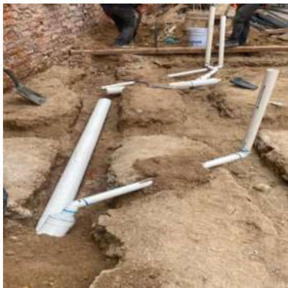
Colocación de instalación sanitaria de PVC de 2" y 4".
