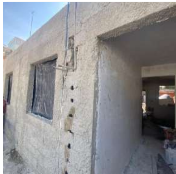
Aplanada en fachada trasera con mortero cemento-arena.
