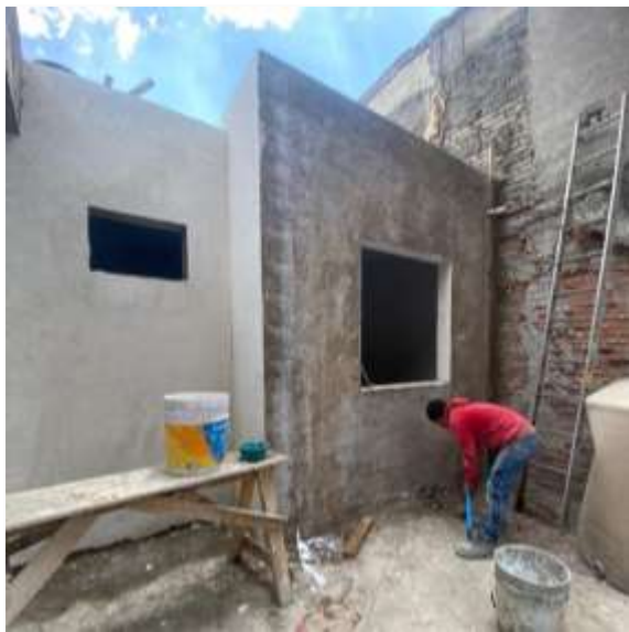
Aplanado fino en fachada principal con estuco blanco.
