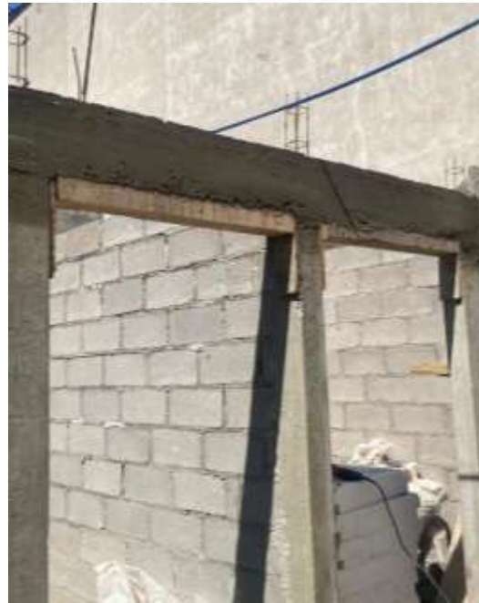
Colado de cadenas de cerramiento en puertas y ventanas.
