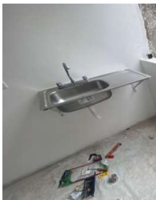
Instalación de tarja.
