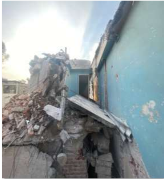
Demolición de muros en planta baja
