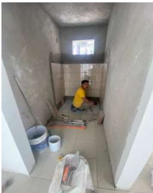
Colocación de azulejo en muro de área húmeda de baño.
