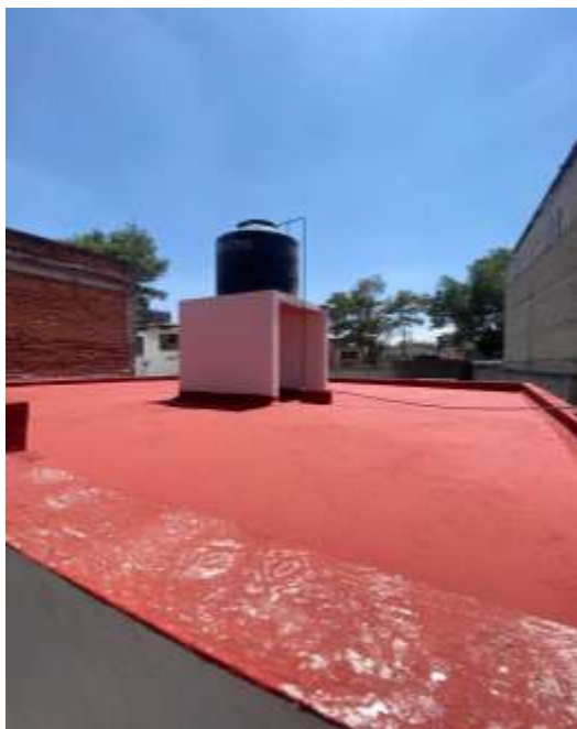
Impermeabilización y colocación de tinaco en base.
