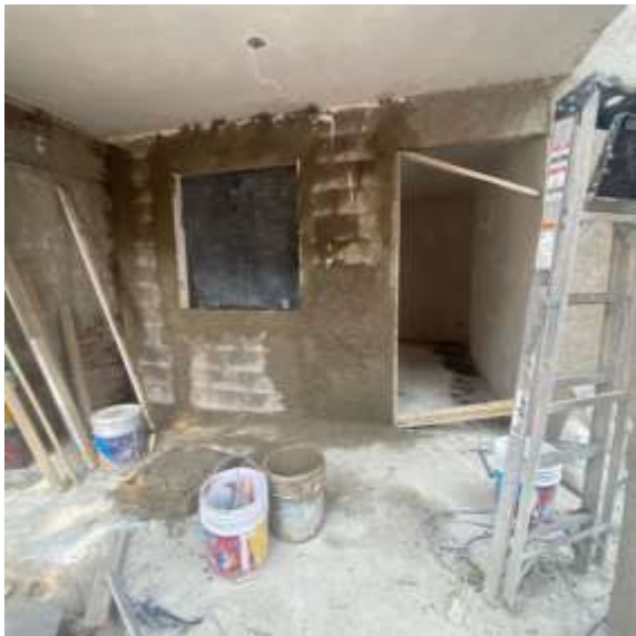
Aplanado en fachada principal con mortero cemento-arena.
