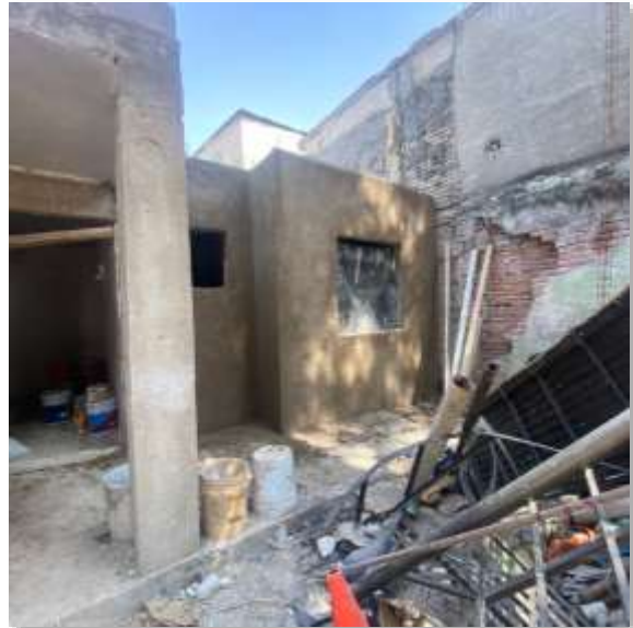
Acabado rustico en fachada principal lista para recibir aplanado fino.
