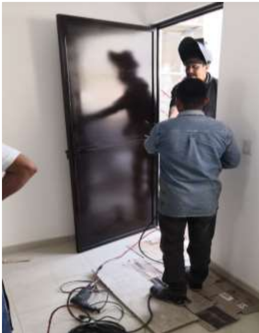
Colocación puerta de acceso de herrería.
