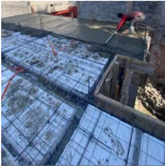
Colado losa tapa con concreto premezclado f'c=250 kg/cm 2 .
