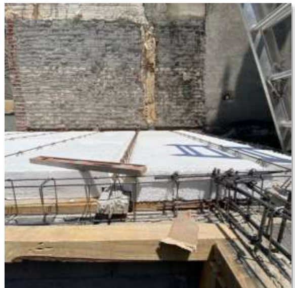
Detalle vigueta, bovedilla y armex de nivelación.
