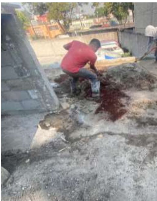
Preparación de entortado a base de cemento-arena-tezontle.
