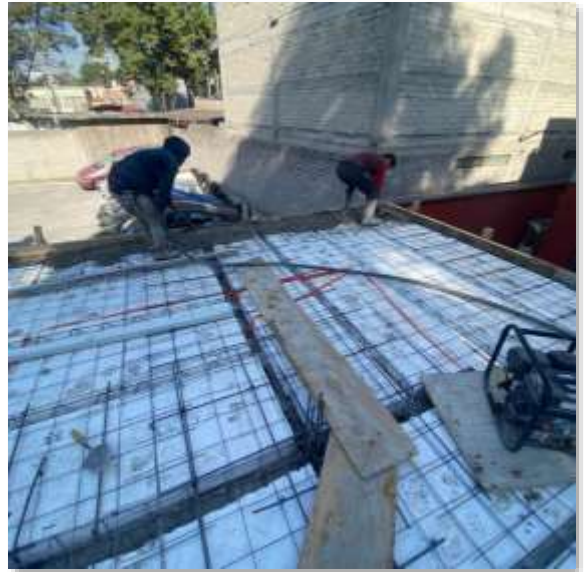
Vibrado del concreto premezclado f'c=250 kg/cm 2 .
