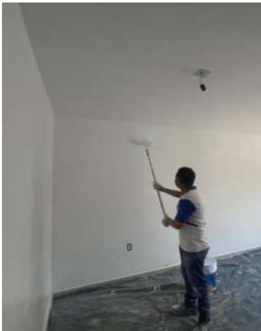
Aplicación de pintura vinílica en muros.
