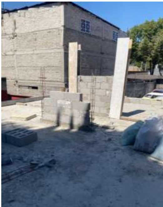
Fabricación de base de tinaco con block hueco.
