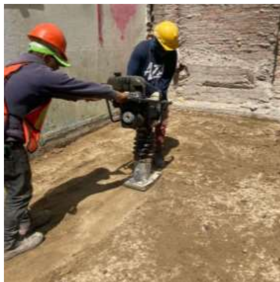
Compactación de tepetate con bailarina.
