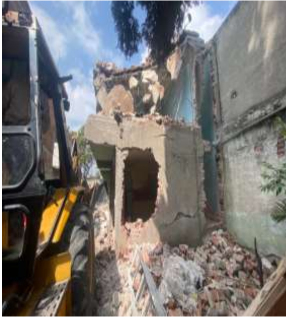
Demolición de losa planta baja
