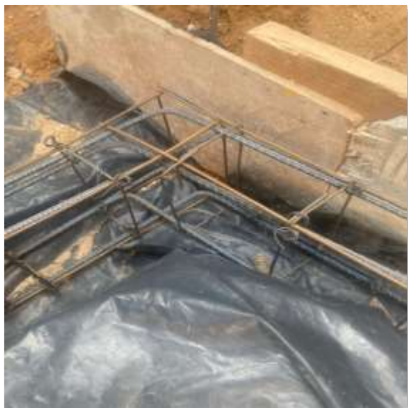
Refuerzo en uniones "L" y "T" de 80 cm largo con varilla de 3/8".
