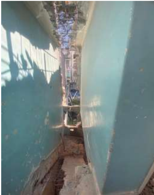
Demolición de losa, muro y trabes para desligar el muro de la estructura.
