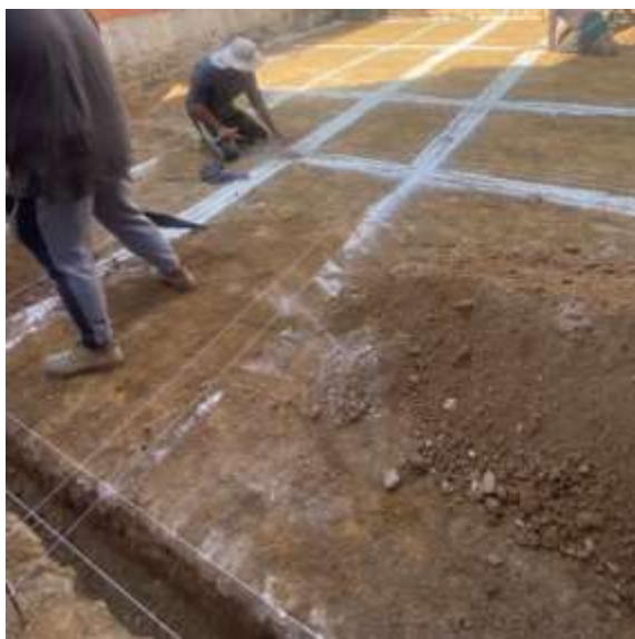
Trazo y nivelación de contratrabes en plataforma.
