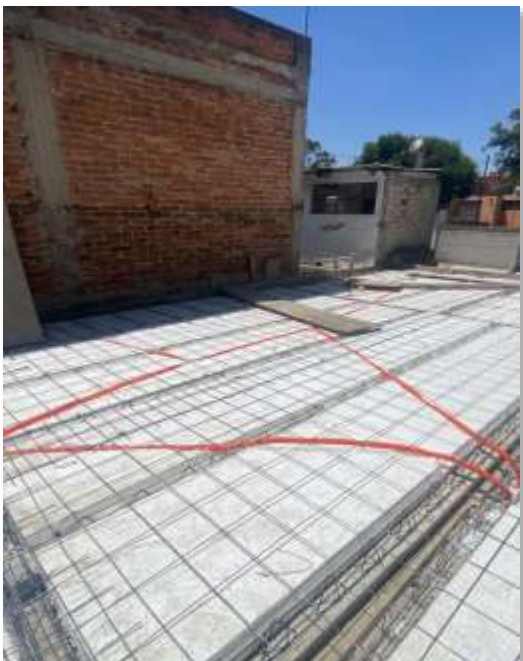
Colocación de tubería para instalación eléctrica.
