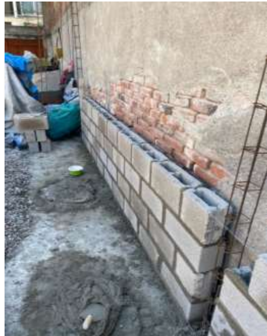
Levantamiento de muro de block hueco 12-20-40.
