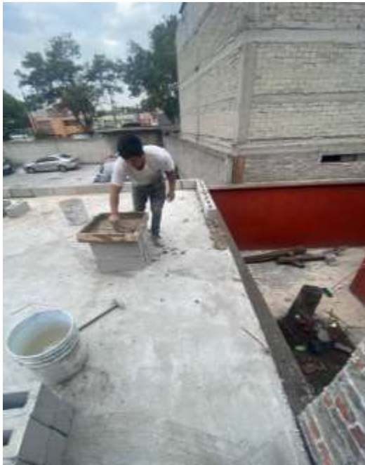
Colocación perimetral de pretil asentado sobre losa con mortero cemento-arena.
