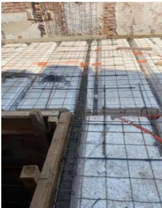
Habilitado y armado de bastones, 1/4" de claro a cubrir.
