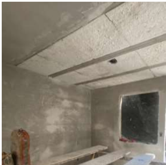
Aplanado de plafones interiores con yeso.
