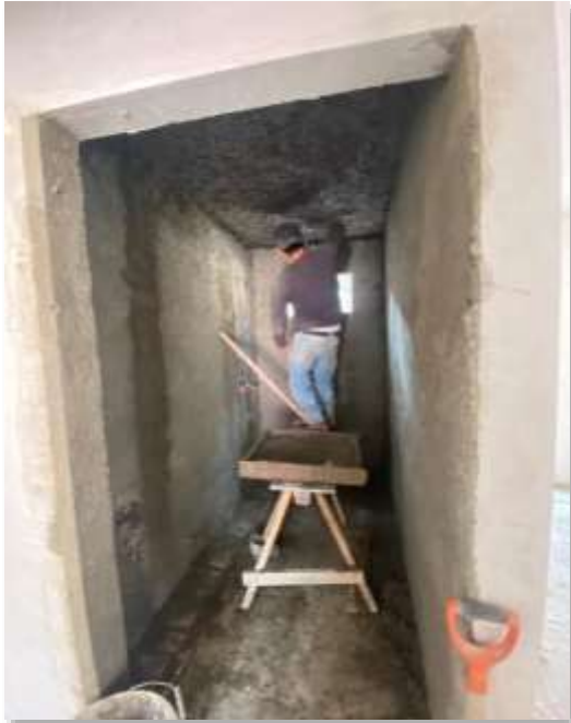
Aplanado de plafón en baño.
