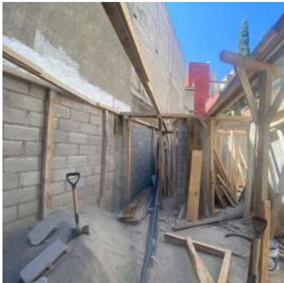
Colocación de vigas mdrina para recibir vigueta y bovedilla.
