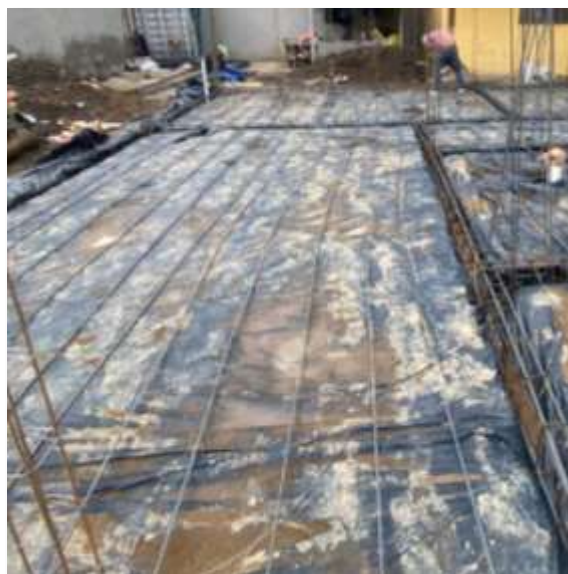
Colocación de parrilla de varilla de 3/8" en ambos sentidos @ 30 cm.
