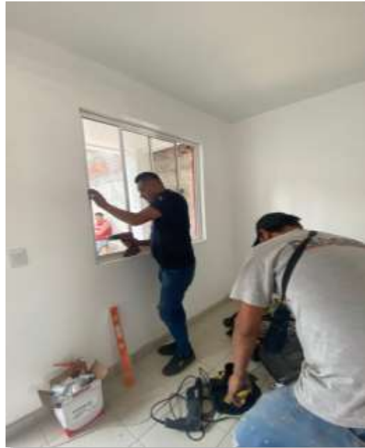
Colocación ventanas de aluminio blanco en habitaciones, sala y baño.
