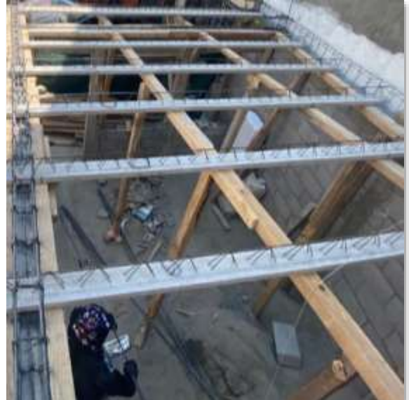
Colocación de vigueta 18 alma abierta.
