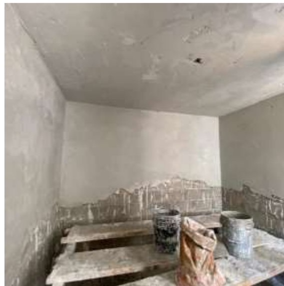
Aplanado de muros interiores con yeso.
