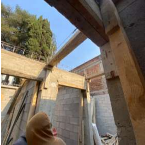
Colocación de cadena de nivelación de armex 12-20-4.
