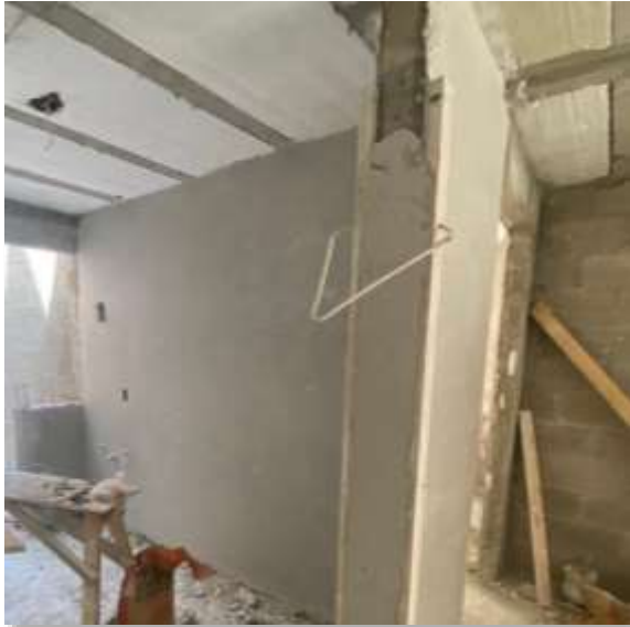
Perfilado de muros interiores.
