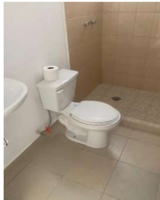
Instalación de W.C.
