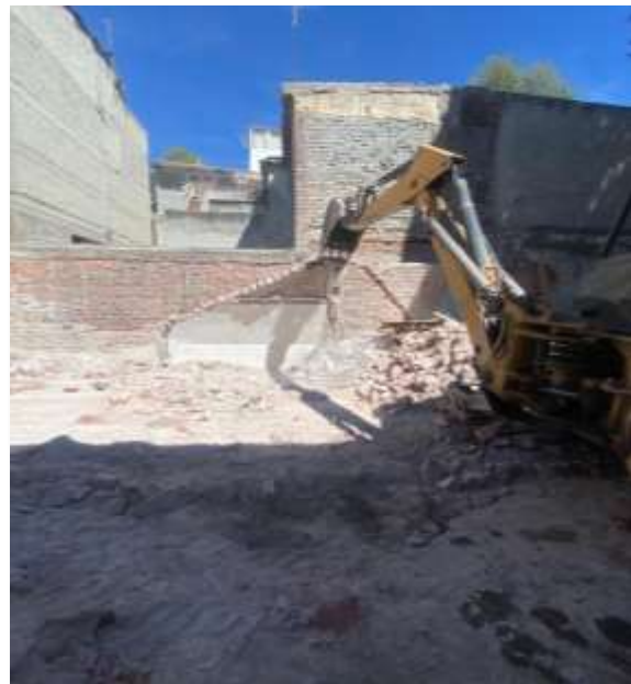
Demolición de muro sin afectaciones a muro colindante con daños previos.
