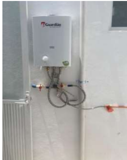
Colocación de calentador de paso gas L.P.
