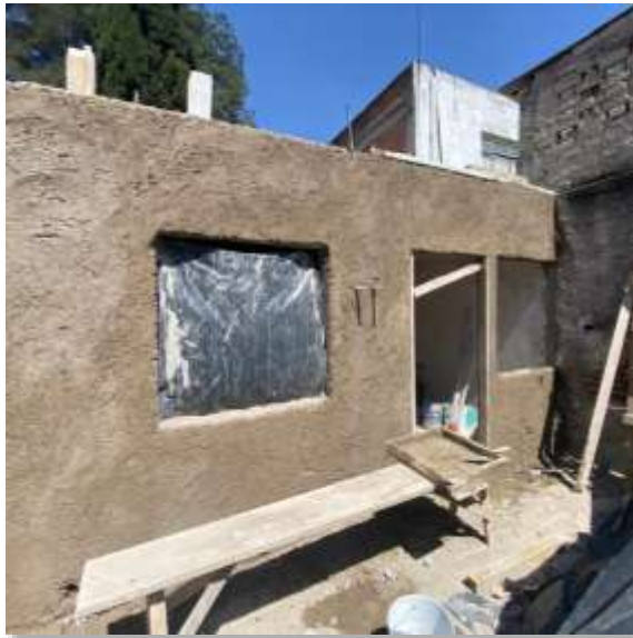
Acabado rustico en fachada trasera lista para recibir aplanado fino.
