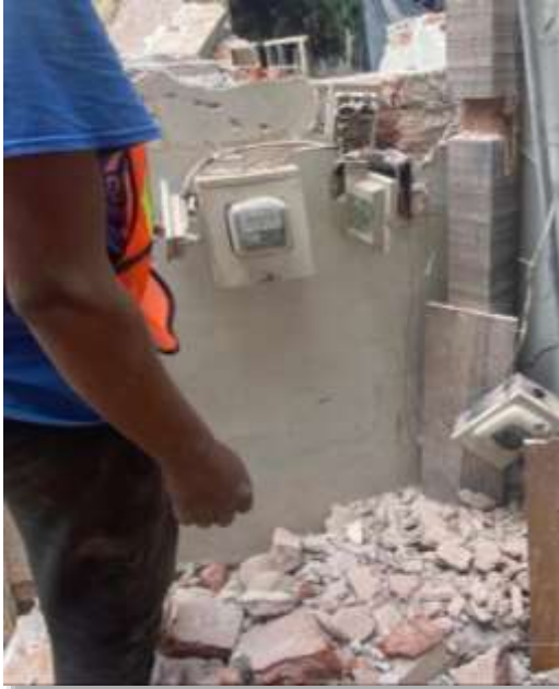
Cancelación instalación eléctrica.
