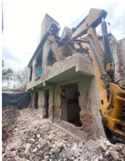
Demolición de losa planta alta.
