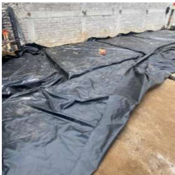
Colocación plantilla plástico negro entre cimentación y plataforma.
