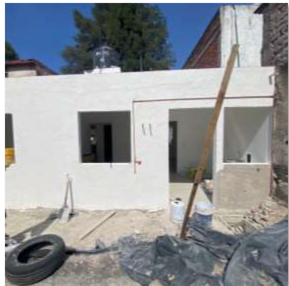
Aplanado fino en fachada trasera con estuco blanco.
