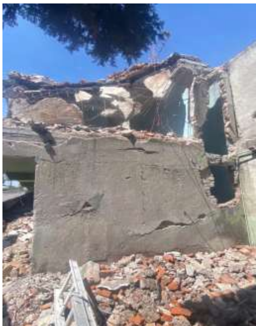
Demolición de muros planta alta.
