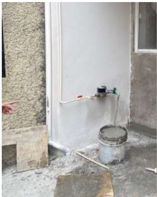
Conexión a toma de agua.
