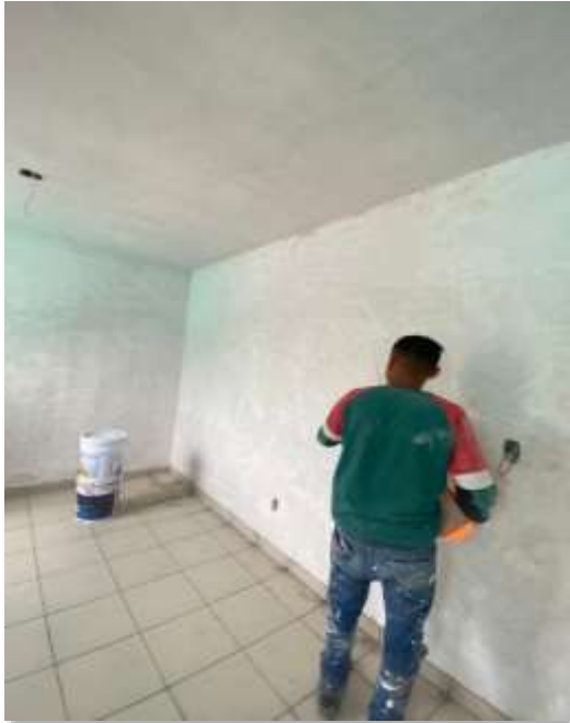
Resane de muros y plafones.
