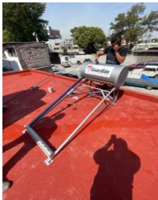
Colocación de calentador solar.
