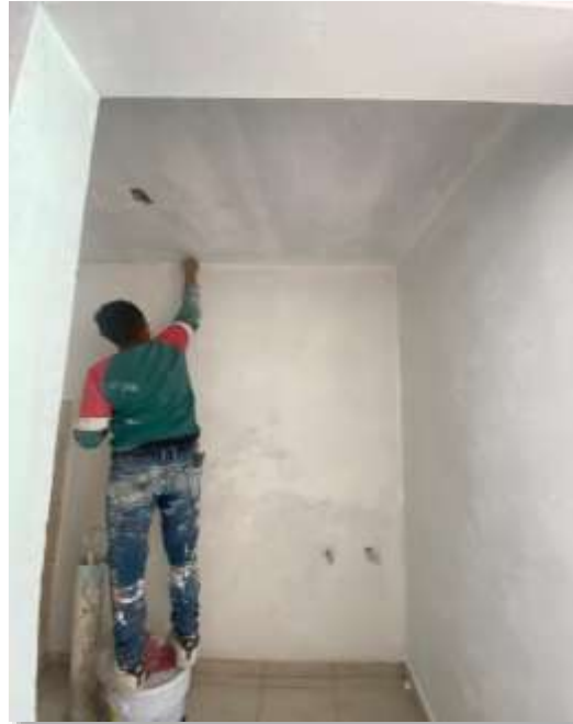
Aplicación de sellador en muros y plafones.
