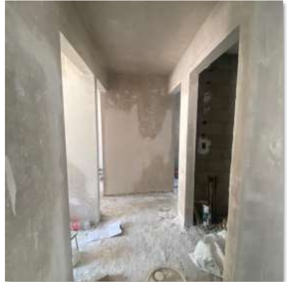
Emboquillado de puertas y cerramientos interiores.
