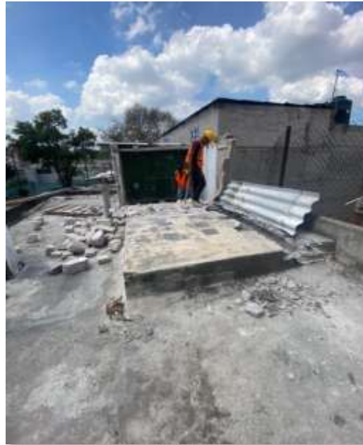
Retiro de elementos ubicados en azotea.
