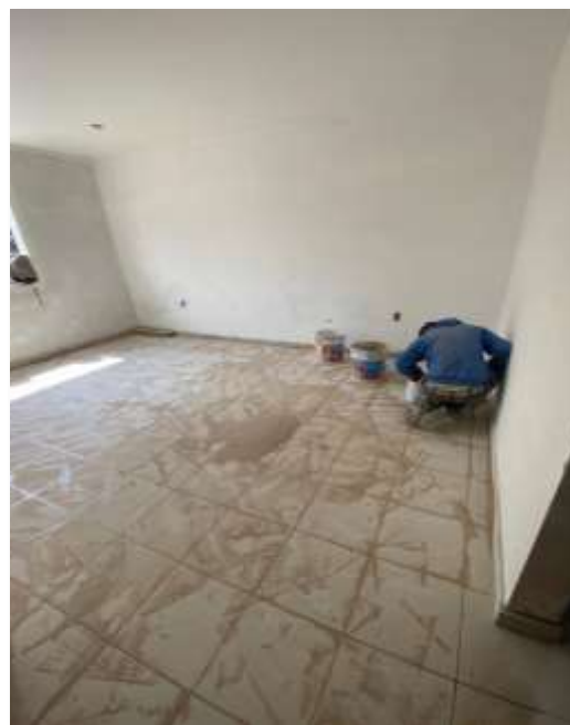
Junta de losetas con boquilla color arena.
