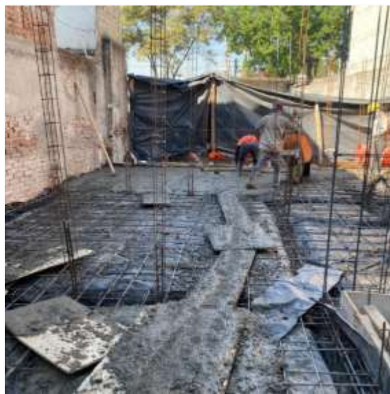
Colado con concreto premezclado f'c=250 kg/cm 2 y vibrado del mismo.
