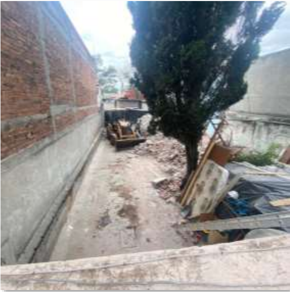
Limpieza y retiro de cascajo producto de demolición.
