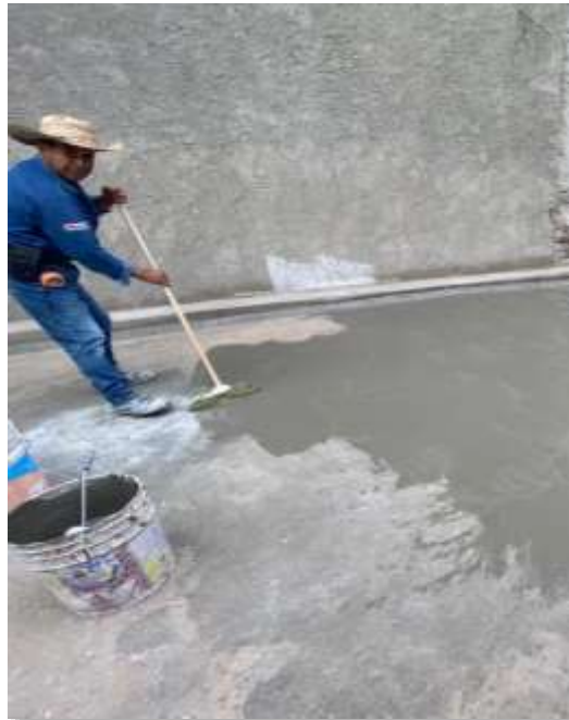
Lechereada de cemento y agua para tapar grietas.
