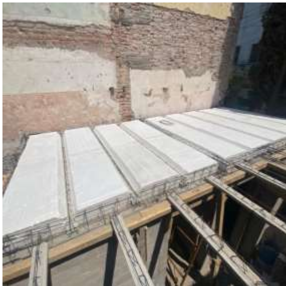
Colocación de bovedilla 70-13-1.27.
