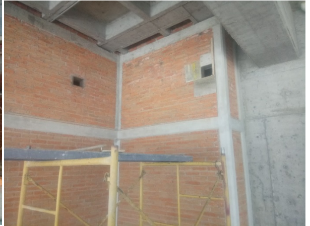
IMAGEN 2.2 MAGDALENA VAZQUEZ, 2 Vista de levantamiento de muro de tabique y salidas para ductería. Febrero 2017, Fotografía.
