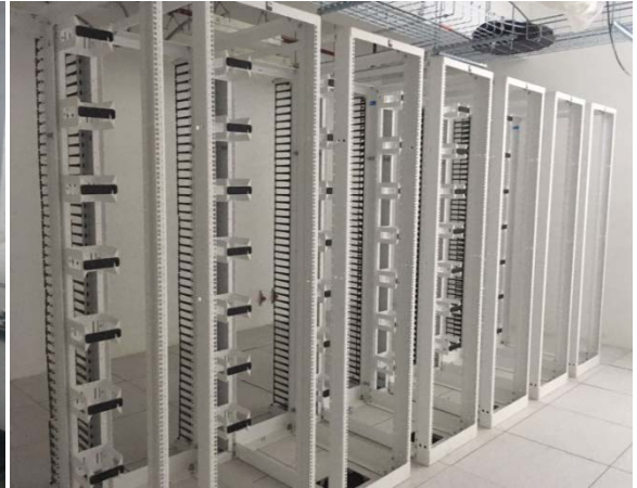
IMAGEN 2.6 MAGDALENA VAZQUEZ, Instalación de Racks para cableado de voz y datos en cuartos de Telecomunicaciones. Marzo del 2017, Fotografía.
