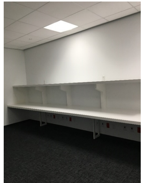
IMAGEN 2.18 MAGDALENA VAZQUEZ, Vista del espacio de bóvedas con los muebles instalados, acabados finalizados e instalación de luminarias. Febrero del 2018, Fotografía.
