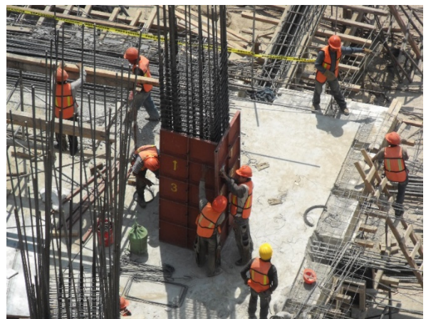
IMAGEN 1.11 C&W, En esta foto se puede apreciar el inicio del colado de las primeras losas para sótanos, así como el armado de las columnas., febrero 2015, Fotografía.
