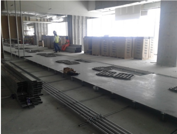
IMAGEN 2.5 MAGDALENA VAZQUEZ, En esta foto se pueden apreciar las canalizaciones para cableado eléctrico bajo piso falso. Marzo del 2017, Fotografía.
