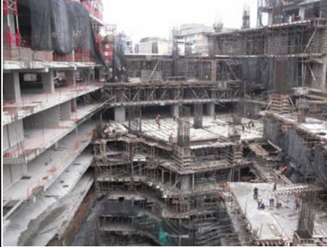
Vista de levantamiento de losas sótanos zona norte-poniente. Se aprecia la losa de sótano 1 lista para colar e iniciar posteriormente con la losa de P.B.
