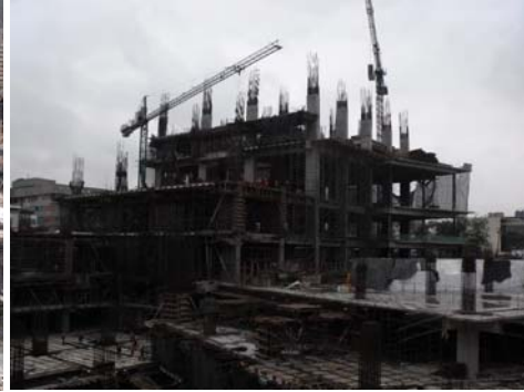
Vista de levantamiento de losas torre de oficinas zona oriente se aprecia el crecimiento de losa 2 hacia la zona poniente
