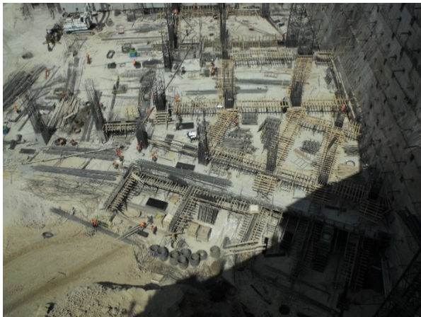
IMAGEN 1.10 C&W, Vista de excavación profunda e inicio de cimentación del edificio, en esta foto se puede apreciar el inicio del colado de las primeras losas para sótanos, febrero 2015, Fotografía.
