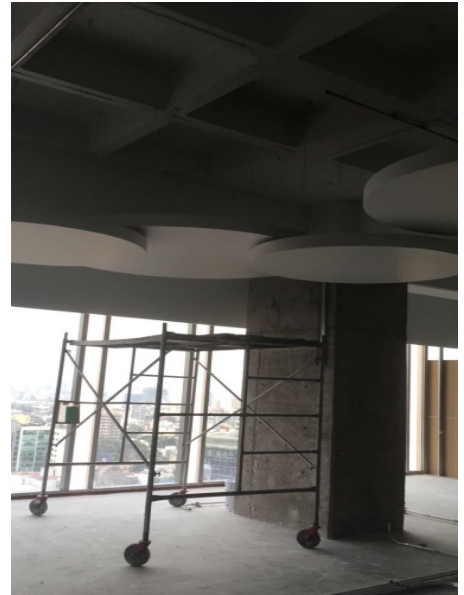
IMAGEN 2.14 MAGDALENA VAZQUEZ, Inicio de instalación de plafones para el área de cafeterías. Mayo del 2017, Fotografía.
