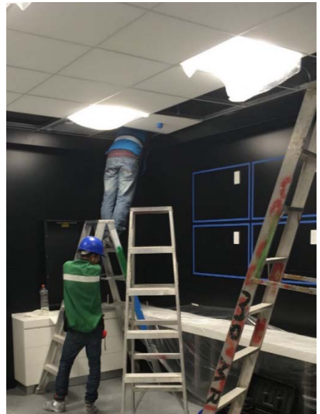
IMAGEN 2.4 MAGDALENA VAZQUEZ, Espacio ya con acabados e instalación de mobiliario., Fotografía.
