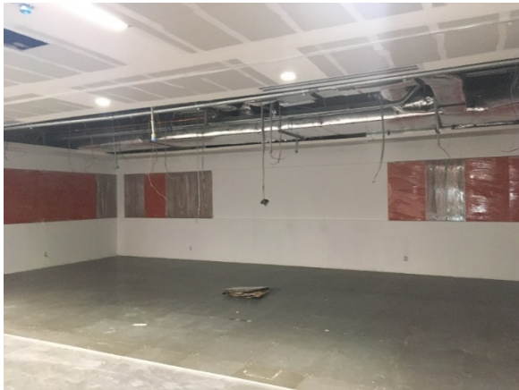
IMAGEN 3.17 MAGDALENA VAZQUEZ. Instalación de paneles acústicos en salas de juntas. Abril del 2017, Fotografía.
