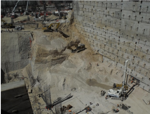
IMAGEN 1.8 C&W, Vista de muro Milán y proceso de excavación para sótanos, febrero 2015, Fotografía.
