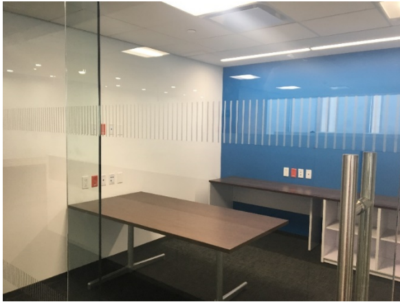
IMAGEN 3.24 MAGDALENA VAZQUEZ. Vista de oficina con muebles instalados y acabados finalizados. Abril del 2018, Fotografía.
