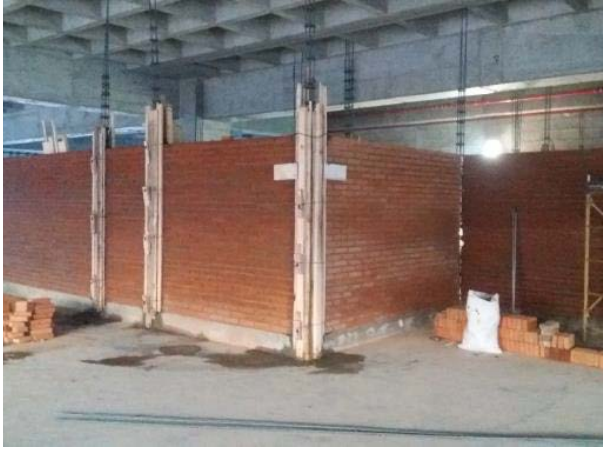
IMAGEN 2.1 MAGDALENA VAZQUEZ, Vista de levantamiento de muro de tabique y cimbra para columnas. Febrero 2017, Fotografía.
