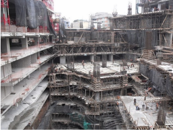
IMAGEN 1.12 C&W, Vista de levantamiento de losas de sótanos zona norte-poniente, con cimbra de losa para losa sótano 1, septiembre 2015, Fotografía.
