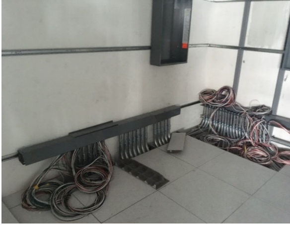
IMAGEN 2.9 MAGDALENA VAZQUEZ, Cableado eléctrico para tableros. Marzo del 2017, Fotografía.
