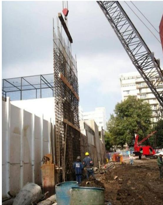
Figura 4.3. Colocación de acero de refuerzo.
