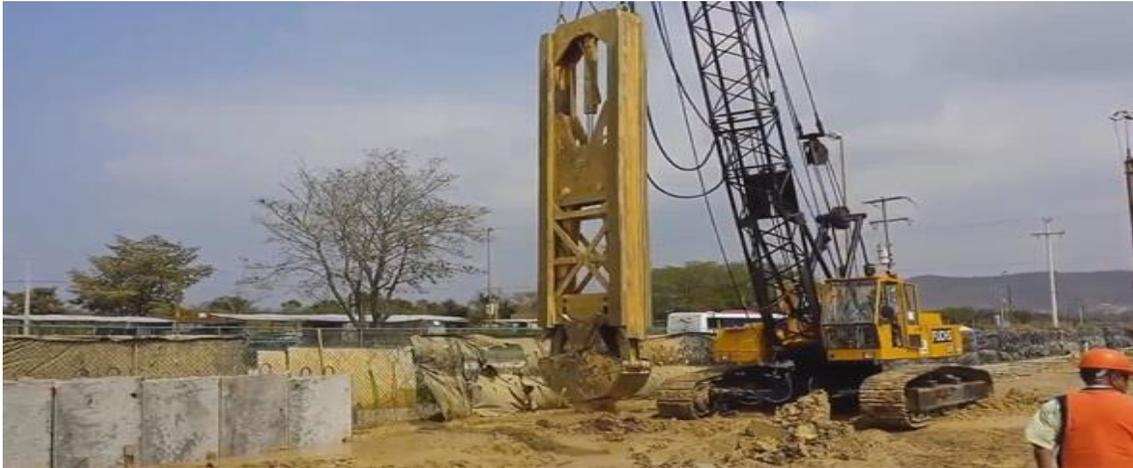
Figura 4.1 Excavación de zanja.
