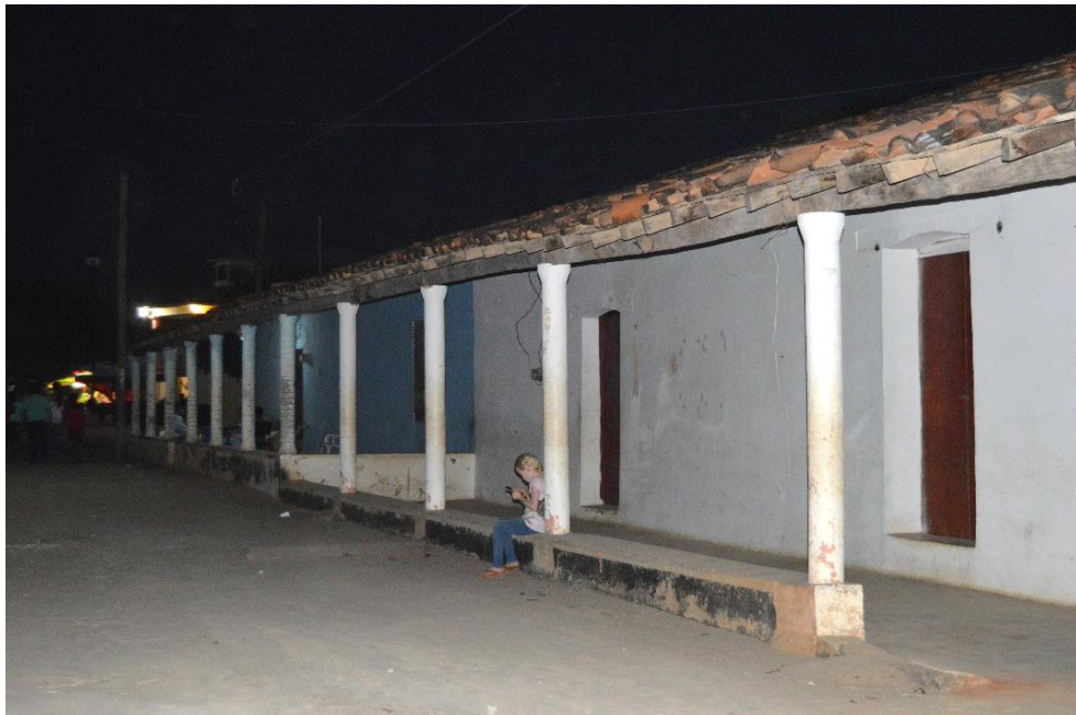
Las casas del centro de Lo de Soto conservan la misma arquitectura. Foto: Nadia Denisse Salinas Marroquín.
