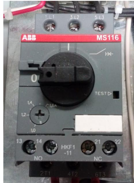
Guardamotor Marca ABB; Figura 16.
