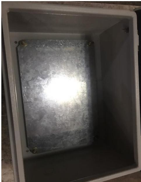
El módulo contiene en el interior una lamina totalmente aislada del chasis del módulo que funciona como un aislante para que no este haciendo contacto con el chasis del módulo y evitar que la carcaza se pueda energizar.
