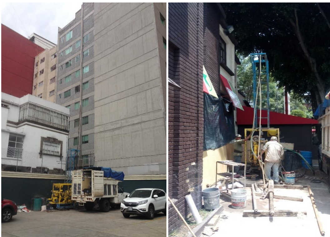
SONDEOS REALIZADOS CON MAQUINA LONG YEAR 34
