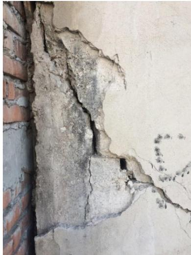
*Fotografía tomada de cerca a la grieta ubicada en estructura de fachada.*
