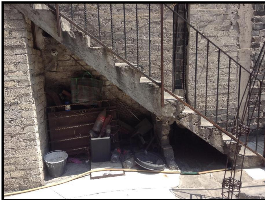
Se puede apreciar que la escalera se construyó por partes, tiene un pequeño apoyo sobre un muro de tabiques y los ángulos de la contrahuella no coinciden.
