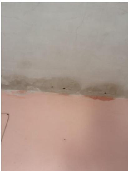
*Problemas de Humedad en parte de la losa y muro de la recámara ubicada en primer piso.*
