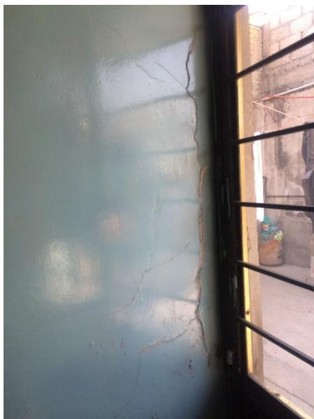
*Fisuras en muros de la cocina ubicada en planta baja.*
