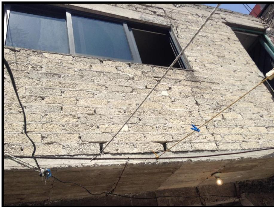
Flexión de la losa, grietas y desprendimientos por efectos de tensión.
