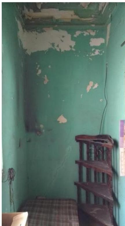
Daños en acabados de muro y losa de los baños correspondientes al primer nivel de la vivienda.
