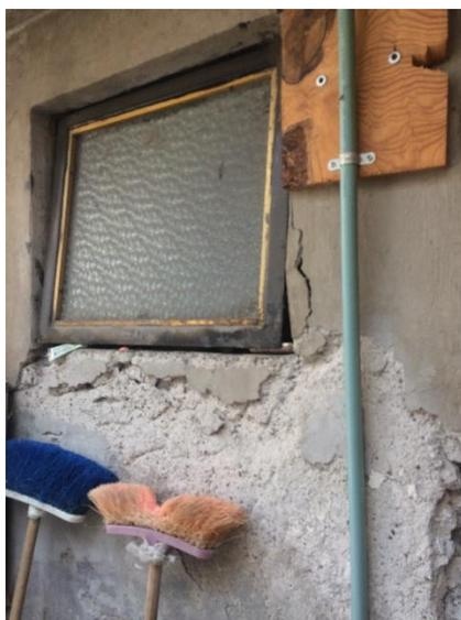
*Daños en muros correspondientes al baño ubicado en planta baja.*
