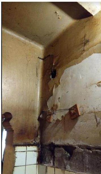
Desprendimiento de pintura en muro de baño ubicado en planta baja.
