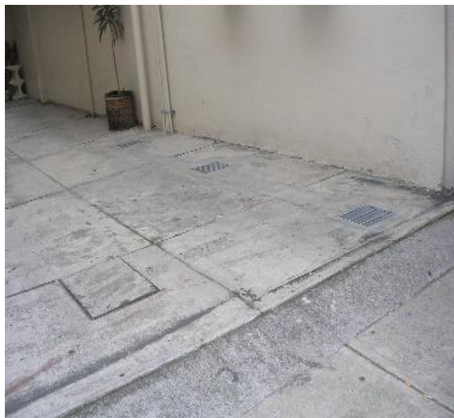
Fig. 12 Se muestra la construcción de la malla de tierra terminada.
