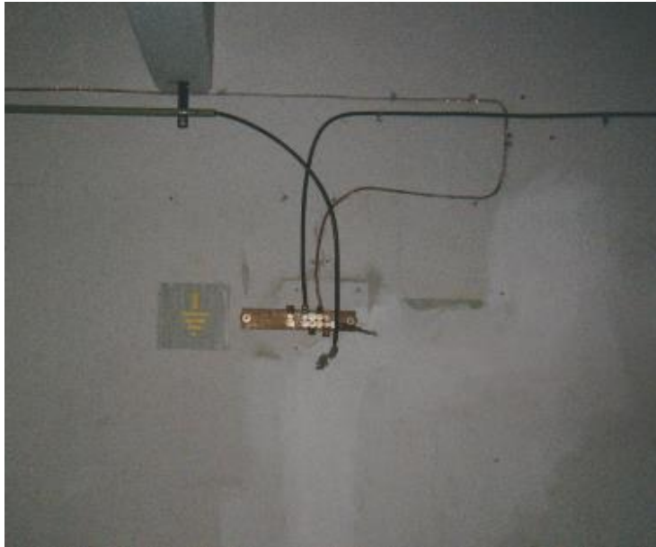
Fig. 02 Sin cable vertical.
