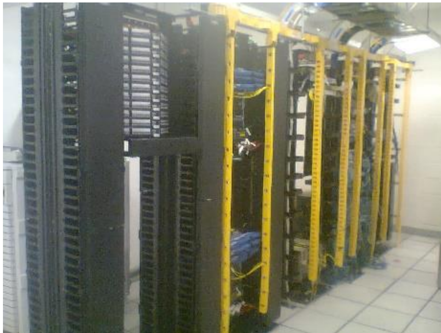
Fig. 24 Instalación de bastidor con todos sus elementos y preparado para instalación del cableado
