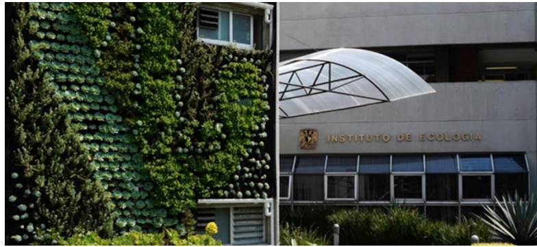
Muro Vegetal del Instituto de Biología UNAM.
